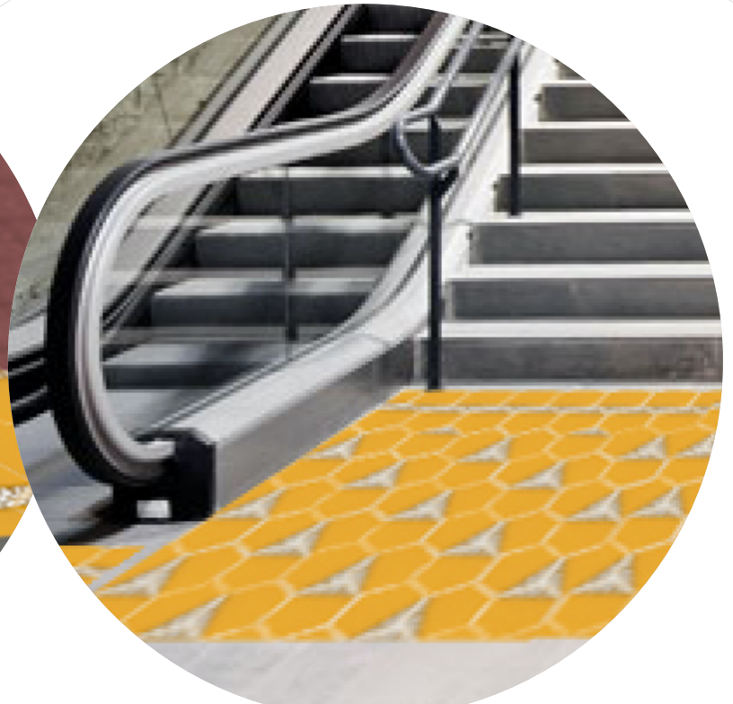
Señalizar escaleras de uso público
