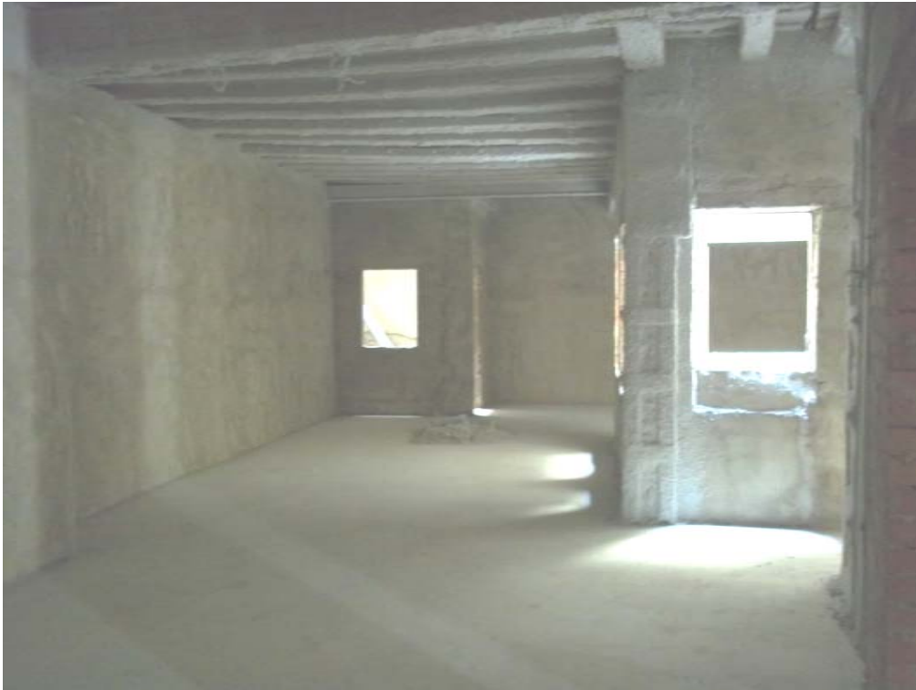
Imagen 12. Estado actual de una planta del edificio. (Elaboración propia).
