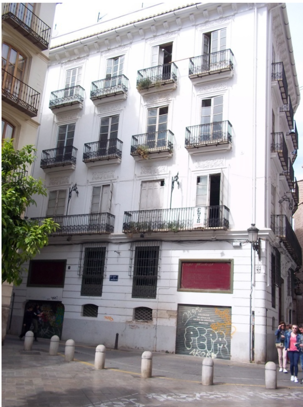
Imagen 7. Fachada del inmueble en Calle Embajador Vich. (Elaboración propia).
