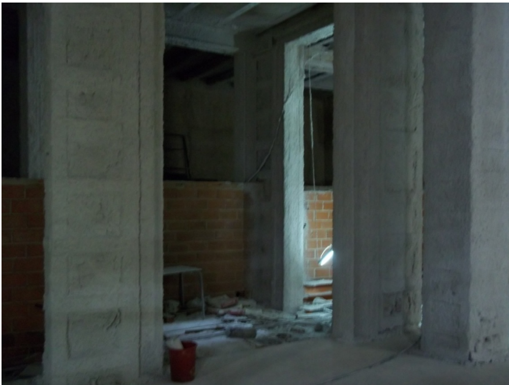
Imagen 11. Estructura de pilares reforzados y cubiertos contra incendios. (Elaboración propia).
