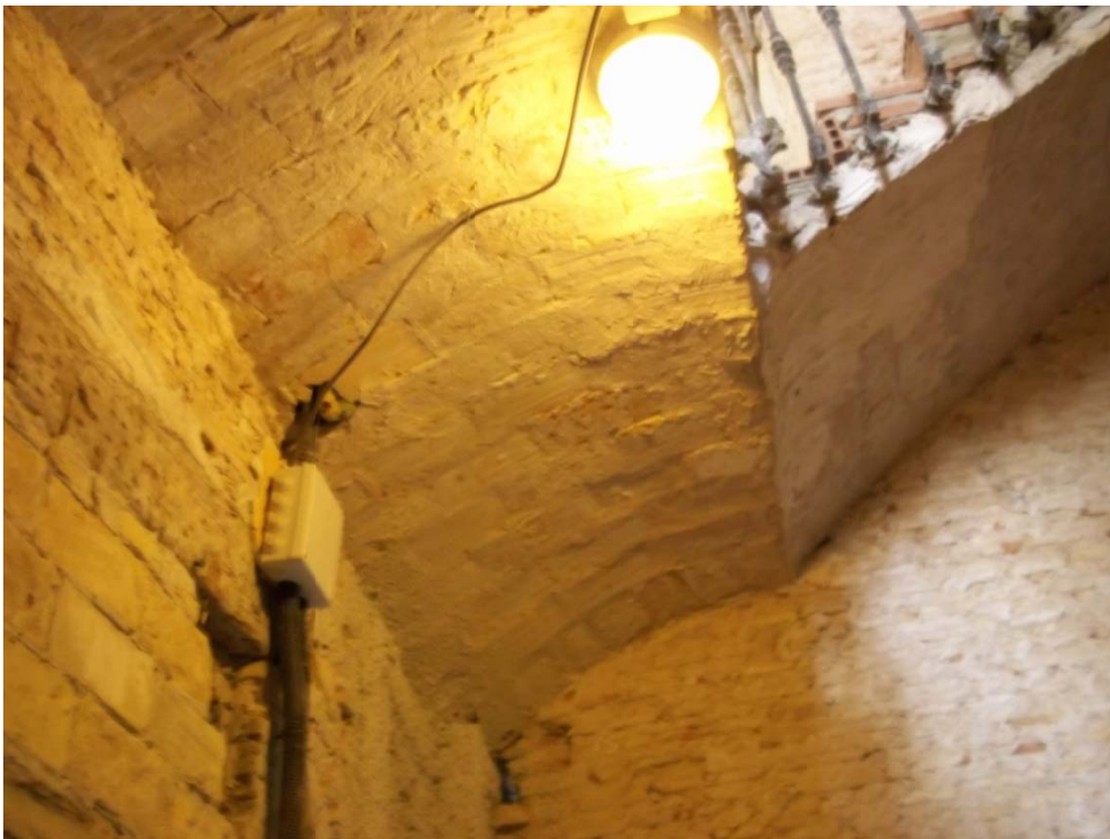
Imagen 13. Estructura de la escalera original del edificio. (Elaboración propia).
