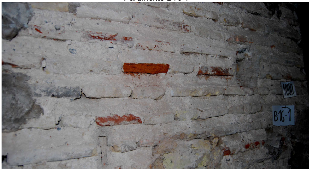
Detalle de la fábrica
