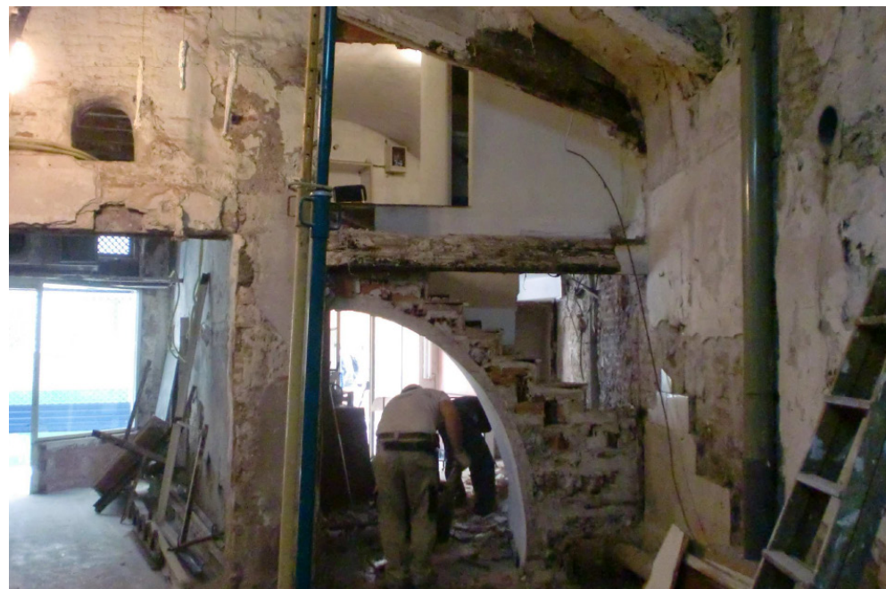
Estado de los locales de Navellos durante las obras de demolición que precedieron al estudio arqueológico
