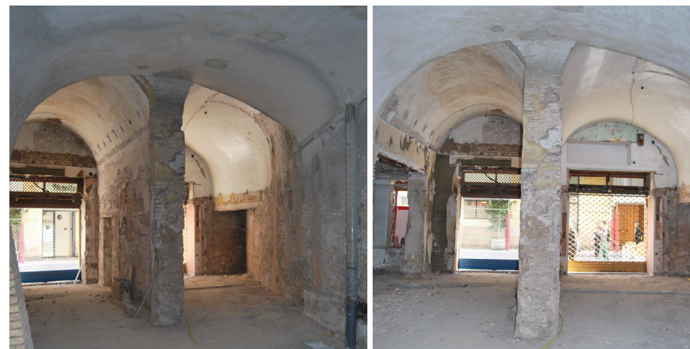
Cañones de las bóvedas
