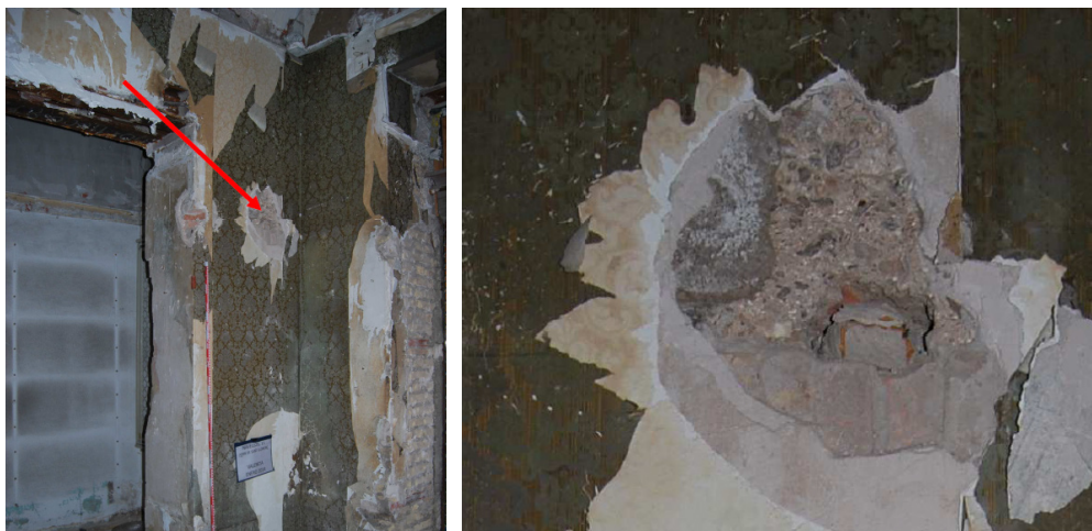
Localización y detalle del fragmento de muro de tapia calicostrada (s. XIV) del muro B15-1
