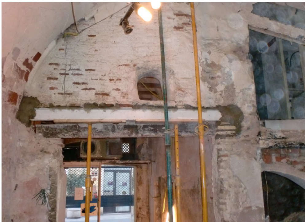
Estado del muro antes de su demolición
