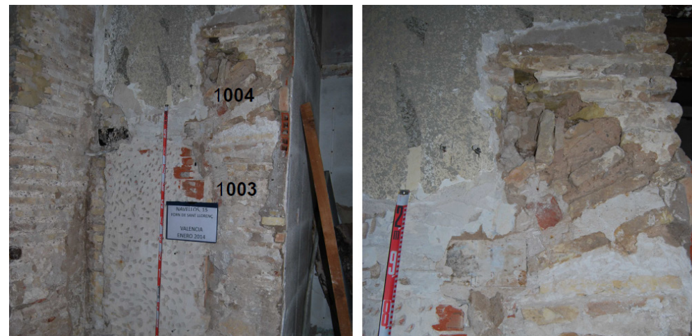
Vista general y detalle del muro-jamba 1003 y arco 1004
