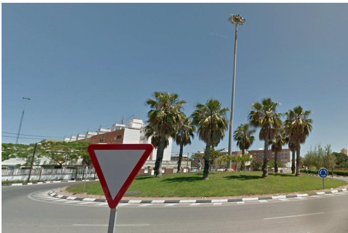
Ilustración 5: Alumbrado específico de la rotonda del Perellonet del Parque Natural de la Albufera. Fuente: elaboración propia.
