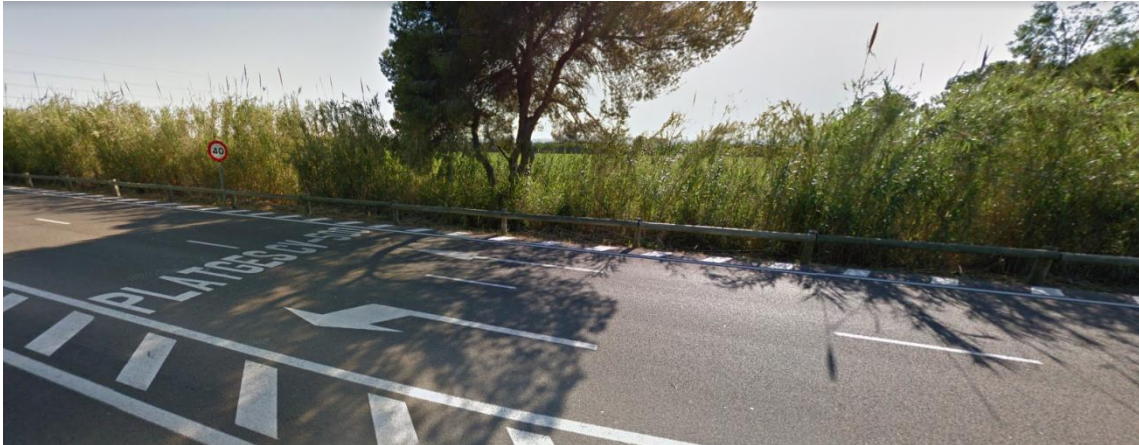
Ilustración 3: Pavimento con zonas reflectantes del Parque Natural de la Albufera. Fuente: elaboración propia.
