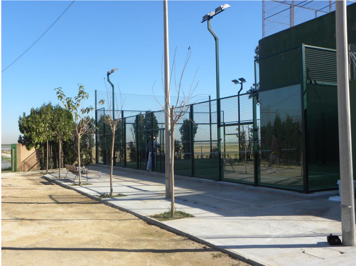
Ilustración 7: Alumbrado instalaciones deportivas. Fuente: elaboración propia
