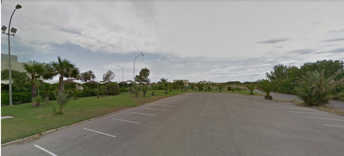
Ilustración 6: Alumbrado aparcamiento al aire libre del Parque Natural de la Albufera. Fuente: elaboración propia.
