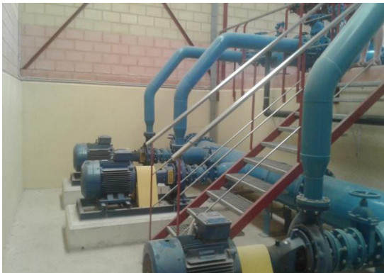
Figura 9. Interior del cabezal de la red de San Rafael en el subsector norte del Sector 4 de Picassent: a) Bombas de impulsión de agua desde el embalse de San Rafael hasta la red ; b) Tubería previa a la red donde se miden los parámetros de funcionamiento y se realizan los tratamientos de filtrado y fertirrigación. Fuente: Propia
