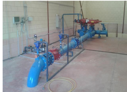
Figura 9. Interior del cabezal de la red de San Rafael en el subsector norte del Sector 4 de Picassent: a) Bombas de impulsión de agua desde el embalse de San Rafael hasta la red ; b) Tubería previa a la red donde se miden los parámetros de funcionamiento y se realizan los tratamientos de filtrado y fertirrigación. Fuente: Propia
