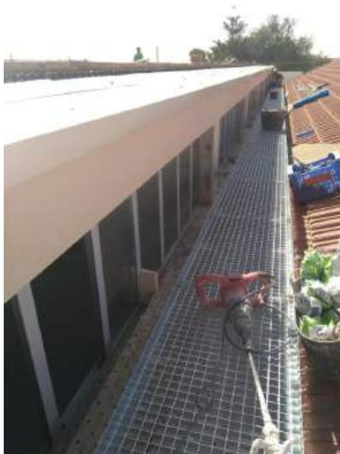
**Ilustración Diario de Obra 81 - Pasarela de mantenimiento colocada. Fuente propia.**
