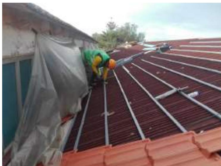
**Ilustración Diario de Obra 74 - Replanteo y colocación de rastreles PVC. Fuente propia**
