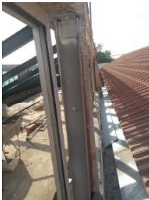
**Ilustración Diario de Obra 41 - Anclaje Perfil IPE-100 de refuerzo. Fuente propia**
