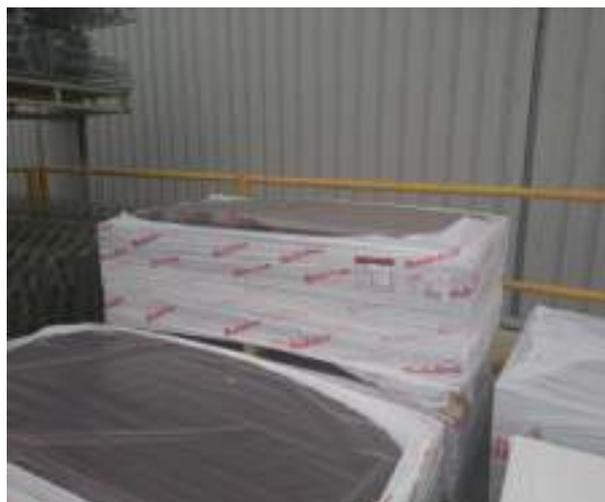
Fotografía 28 - Placas asfálticas onduladas para teja acopiadas
