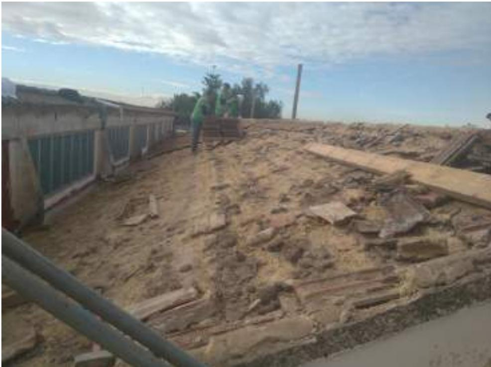
**Ilustración Diario de Obra 24 - Retirada tejas. Fuente propia.**
