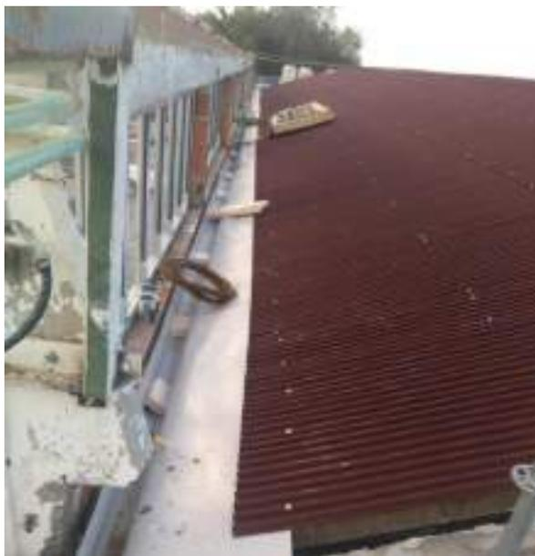
**Ilustración Diario de Obra 67 - Placas asfálticas onduladas sobre paneles y canal. Fuente propia.**
