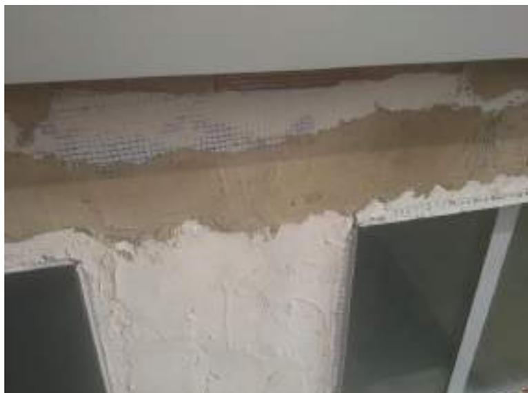
**Ilustración Diario de Obra 73 - Detalle preparación para el revestimiento exterior. Fuente propia.**
