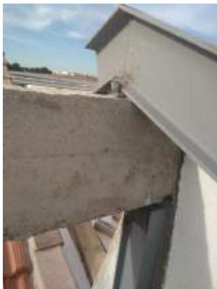
**Ilustración Diario de Obra 45 – Anclaje superior vigueta C4. Fuente propia.**
