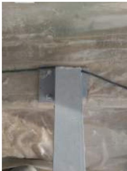
**Ilustración Diario de Obra 44 – Anclaje inferior vigueta C4. Fuente propia.**
