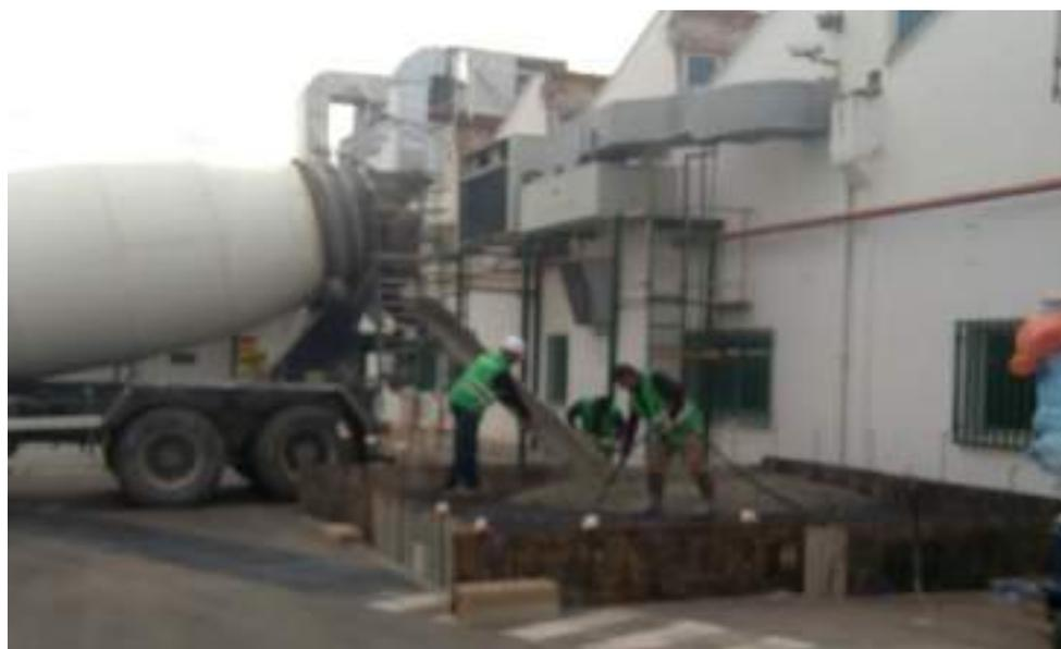
**Ilustración Diario de Obra 31 - Hormigonado losa grúa**
