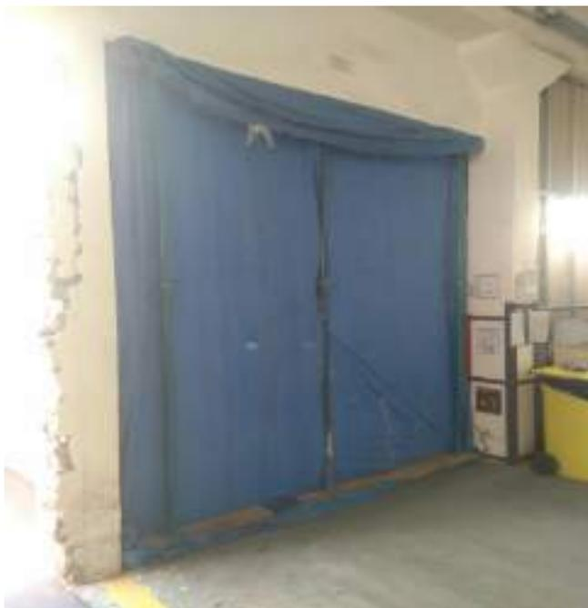
**Ilustración Diario de Obra 60 - Colocación de la lona correctamente. Fuente propia.**
