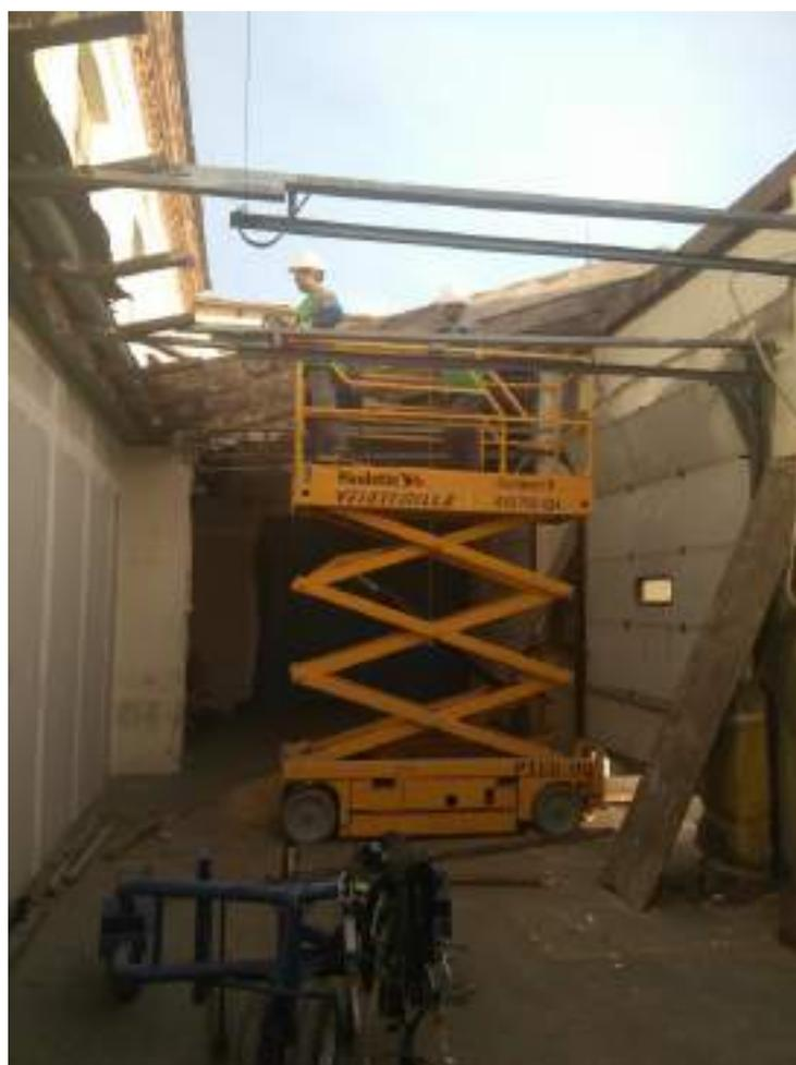
Ilustración Diario de Obra 63 - Demolición desde el interior de la cruzía. Fuente propia.
