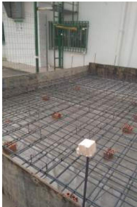
Fotografía 15 - Armado de la losa de hormigón para la grúa
