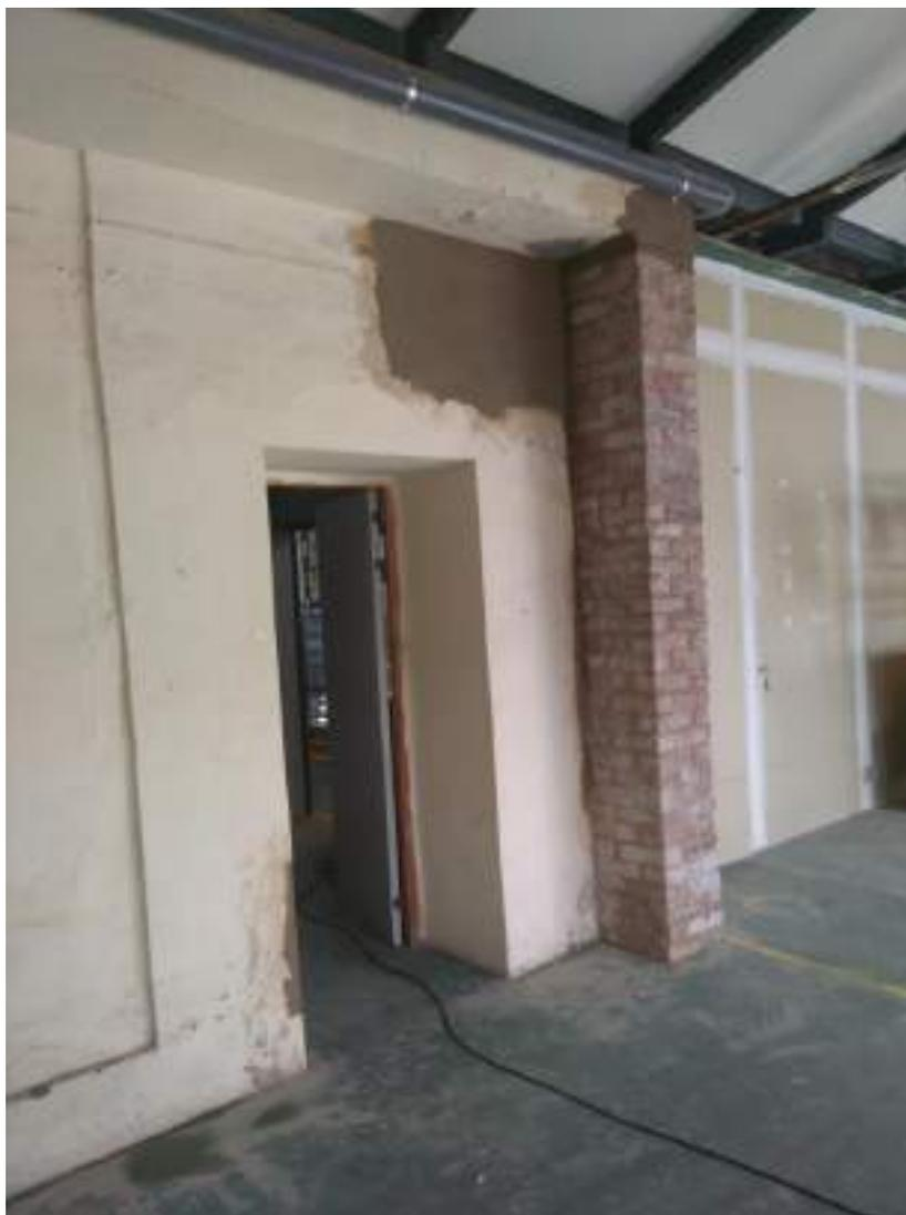
**Ilustración Diario de Obra 98 - Picado y lijado de pilar de la crujía 34 para que quede visto su aparejo. C34.**
