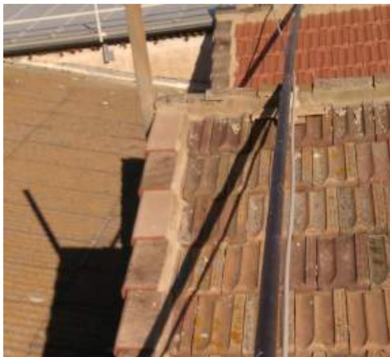
**Ilustración Diario de Obra 88 - Detalle colocación tejas alero y cumbre. Fuente propia.**
