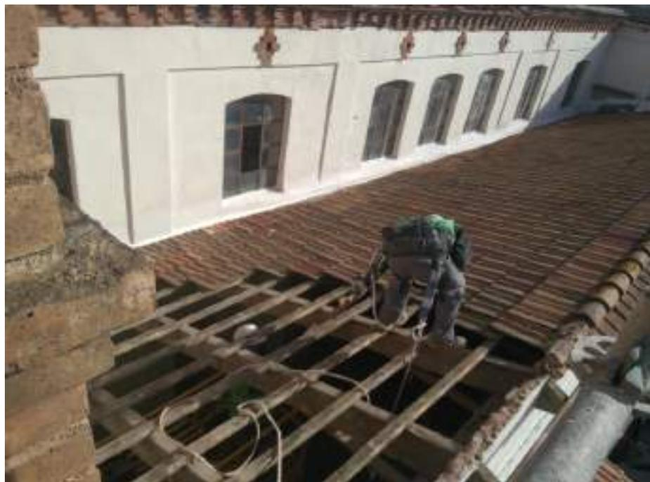
Ilustración Diario de Obra 62 - Retirada de tejas Cubierta 34. Fuente propia.
