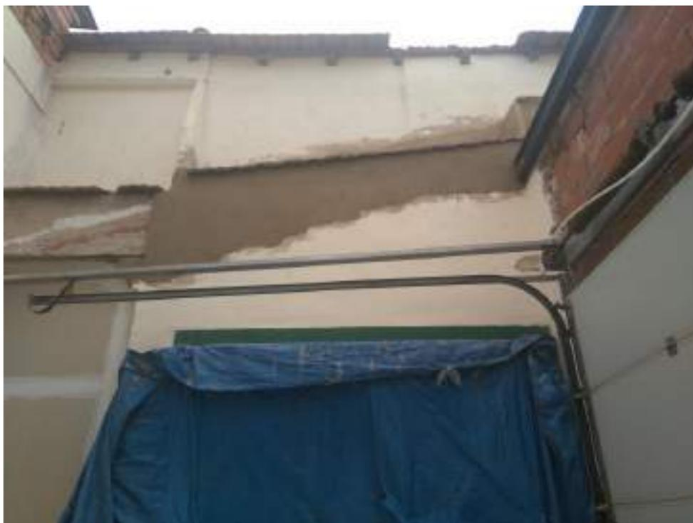
**Ilustración Diario de Obra 82 - Paramento ejecutado de la C34. Fuente propia.**
