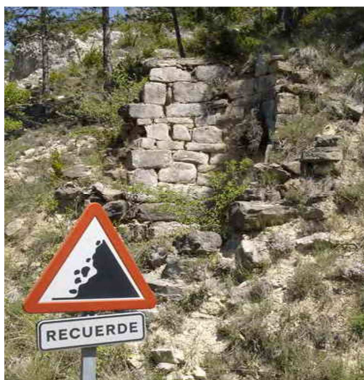
Figura24. Señal de desprendimiento.
