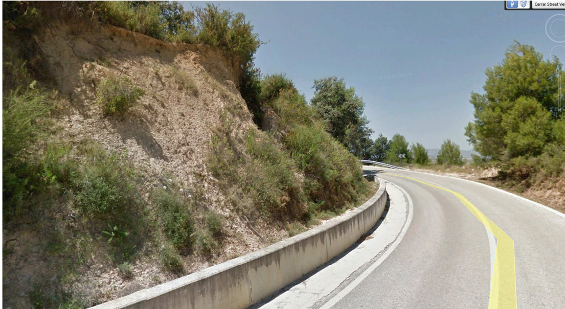
Figura 13. Estratos de arcillas y margas TAP en el talud de la margen derecha
