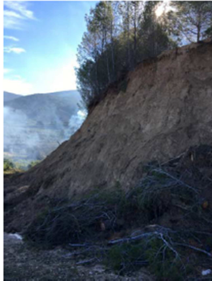
Figura 16. Localización de la toma de muestra N°2: Margas con cementación. Talud de la ladera del margen izquierdo CV-615 PK 4+970.
