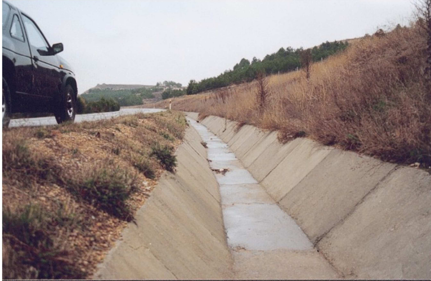
Figura 28. Cuneta trapezoidal al pie de talud.
