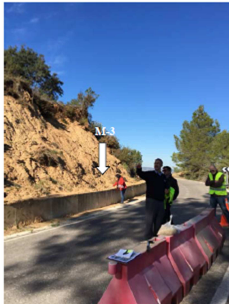
Figura 17. Localización de la toma de muestra N°3: Arcillas. Talud de desmonte, margen derecho de la CV-615, PK 4+990.
