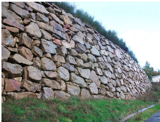
Figura 30. Muro de escollera.
