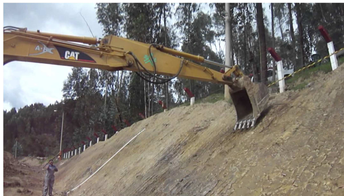
Figura 32. Perfilado de un talud con maquinaria.
