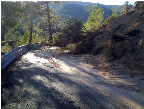
Figura 1. Situación del deslizamiento del talud sobre la CV-615.
