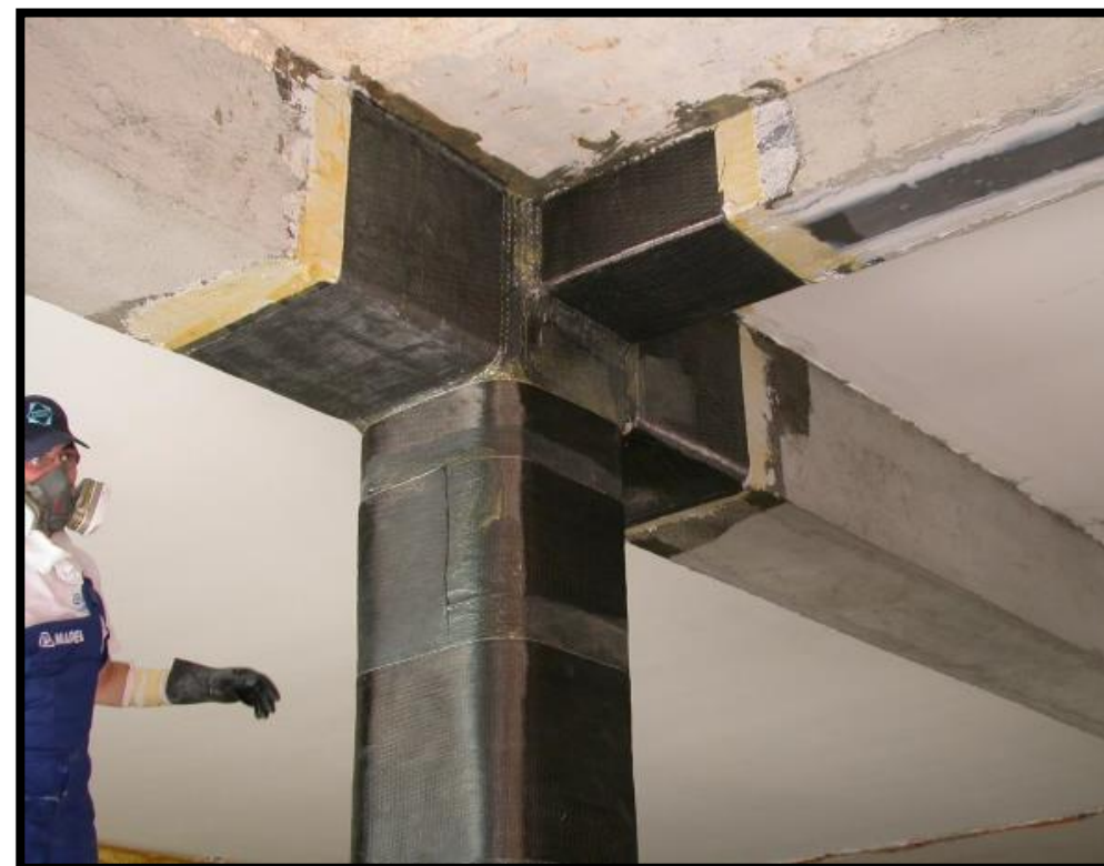
Detalle e imagen de confinamiento mediante cintas FRP de fibra de carbono. MAPEI Spain .S.A
