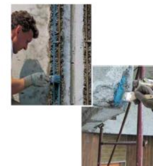
Proceso pasivación armaduras. MAPEI Spain. S.A
