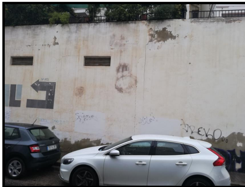
Grietas en fachada unión pilar-muro
