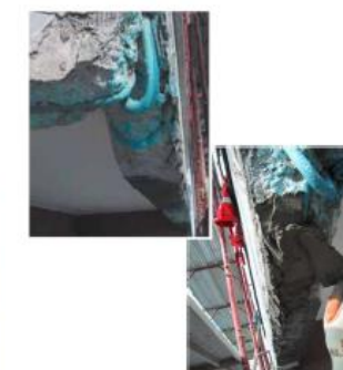
Proceso pasivación armaduras. MAPEI Spain. S.A
