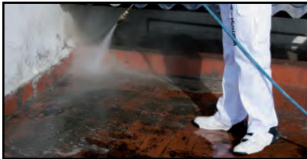
Limpieza manchas humedad en pavimento. www.pinturaselartista.com
