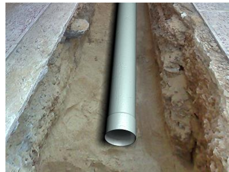
Detalle instalación saneamiento PVC enterrada. www.generadordeprecios.info
