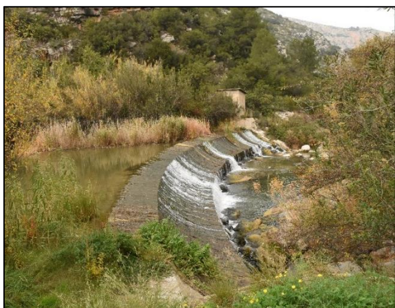
Fotografía 48. Azud El Morú . Tomada el 03-12-2016
