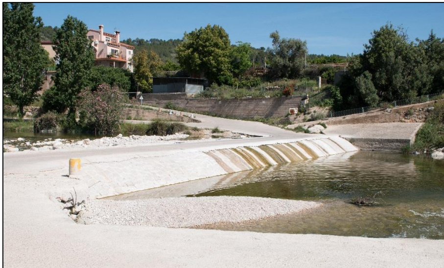
Fotografía 51. Azud de Canals Alts. Tomada el 08-05-2017
