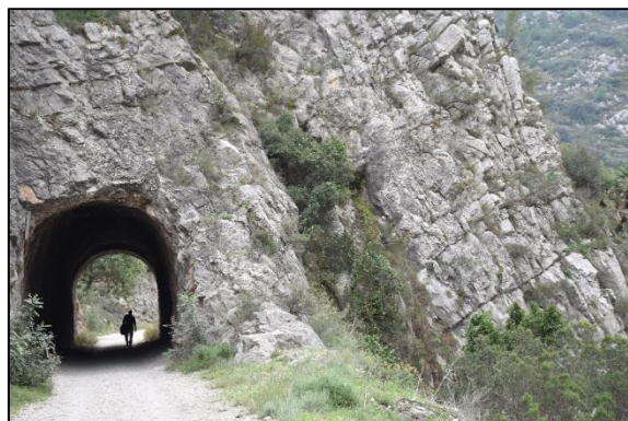
Fotografía 62. Túnel situado cerca del azud el Morú, salida. Tomda 08-05-2017
