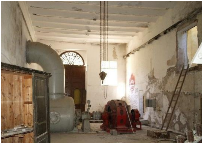
Fotografía 33: Sala de turbinas, antes de ser robada. Fuente: (Cervera et al., 2010)
