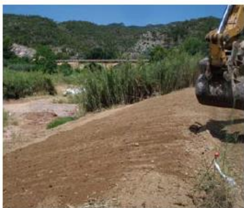
Fotografía 29. Se cubre con tierra el geotextil con la finalidad de prolongar su durabilidad. Fuente: DGA (MAGRAM)-TRAGSA
