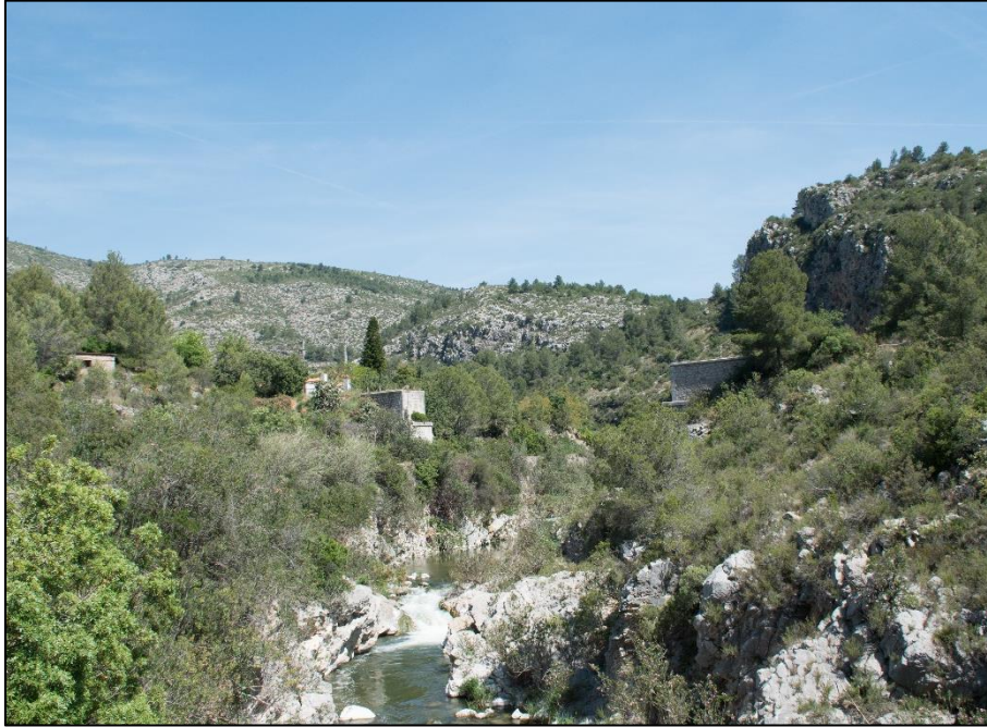
Fotografía 65. Puente desmantelado a unos 650 m aguas abajo del azud La Reprimala. Tomado 08-05-2017
