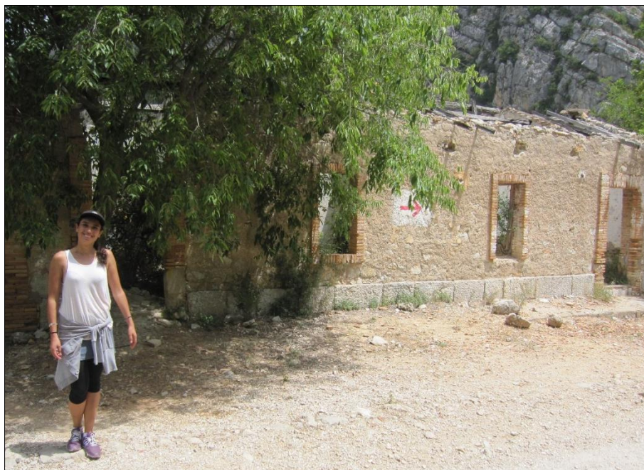
Fotografía 18. De las viviendas de los vigilantes del ferrocarril. Tomada 03-07-2015
