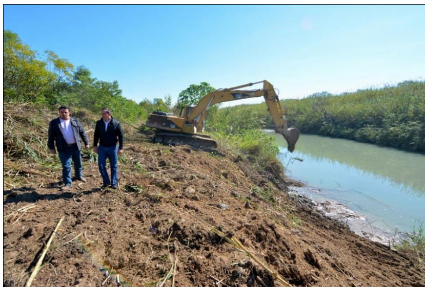
Fotografía 10: Desbroce de la vegetación de ribera mediante el uso de maquinaria pesada.
