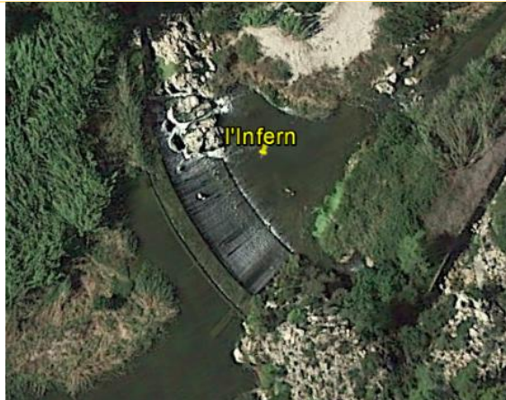
Fotografía 20. Azud l’Infern. 2da Fuente: Google Earth
