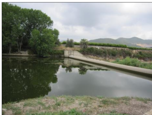
Fotografía 57. Parte superior del azud de En Carròs. Tomada el 07-12-2016
