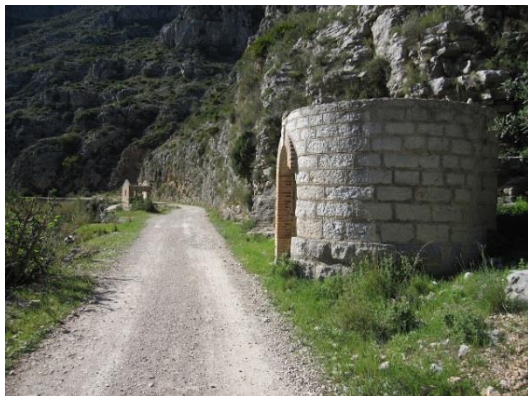
Fotografía 69. Depósito de agua. Tomada 03-07-2015
