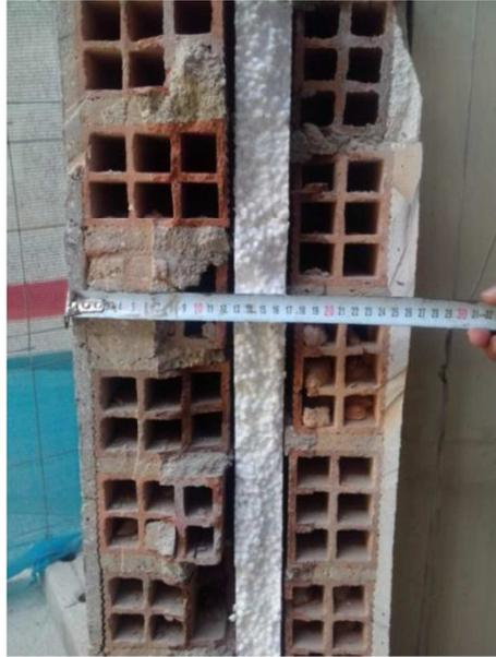
Figura 7. Detalle de la composición de la fachada. Fuente: CIEMAT
