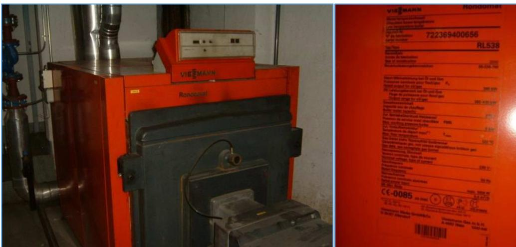
Figura 15. Imagen de Caldera 02 de climatización Modelo PAROMAT-TRIPLEX RL 532. P nominal 380KW. Fuente: CIEMAT
