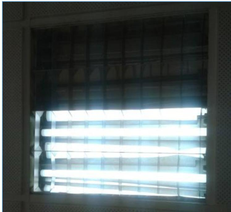
Figura 21. Imagen de la luminaria de 2 tubos en los pasillos. Fuente: CIEMAT
