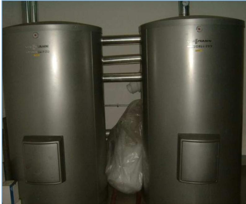
Figura 14. Imagen de los Depósitos de acumulación de ACS. Fuente: CIEMAT
