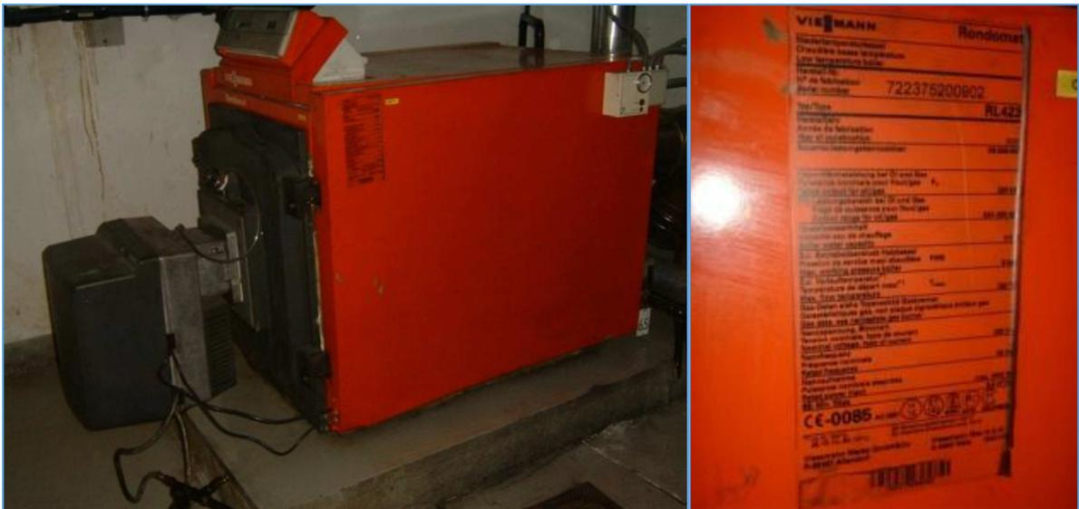
Figura 16. Imagen de Caldera 02 de climatización Modelo PAROMAT-TRIPLEX RL 423.
