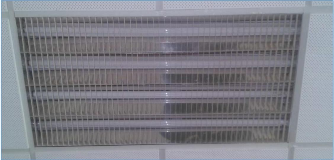
Figura 20. Imagen de la luminaria de 4 tubos en los despachos. Fuente: CIEMAT
