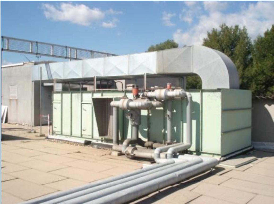
Figura 19. Imagen de la enfriadora por compresión mecánica. Fuente: CIEMAT
