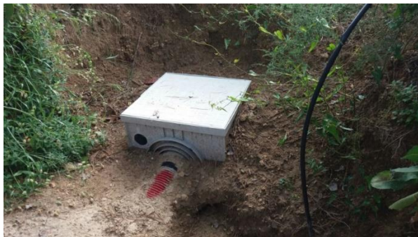
Figura 4.23. Salida del sistema de depuración. Arqueta fuera de la parcela B. Fuente: Elaboración propia (junio 2017)
