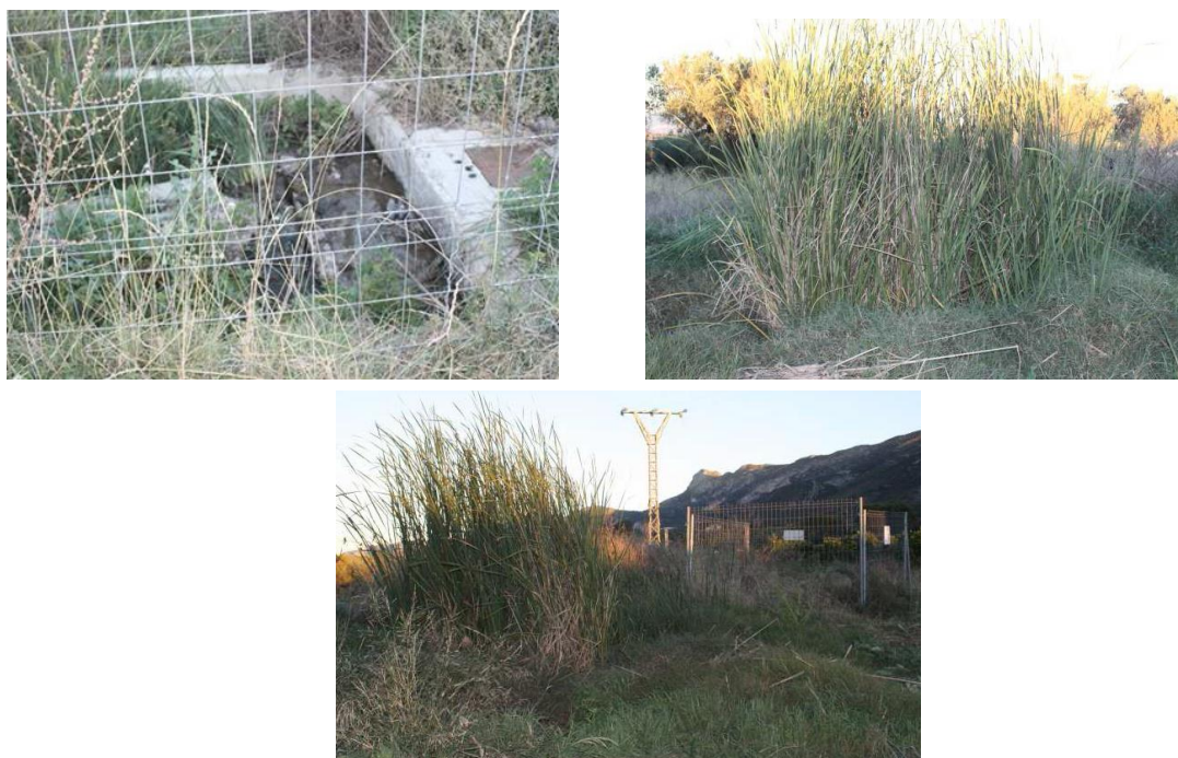
Figura 4.8. De izquierda a derecha, de arriba abajo: tanque Imhoff de la EDAR previa, lecho de gravas de la EDAR previa y vista conjunta de la EDAR previa. Fuente: Trabajo Final de Máster "Evaluación de los servicios ecosistémicos proporcionados por los humedales artificiales. Aplicación al humedal artificial de Carrícola (Valencia)". Blanca de la Cruz Vicente (2015).
