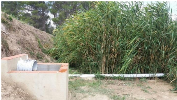
Figura 4.21. Arqueta A4, entrada HAFSSV. Fuente: Elaboración propia (junio 2017).
