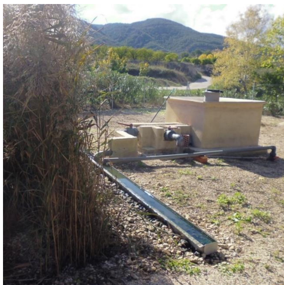
Figura 4.18. Arqueta A1 de entrada al HAFSSH. Fuente: Elaboración propia (noviembre 2016) .
