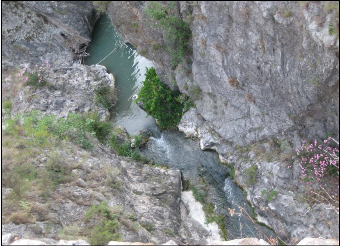
Foto 21. Entre rocados circula, aguas abajo de la obra, el río Penáguila.
