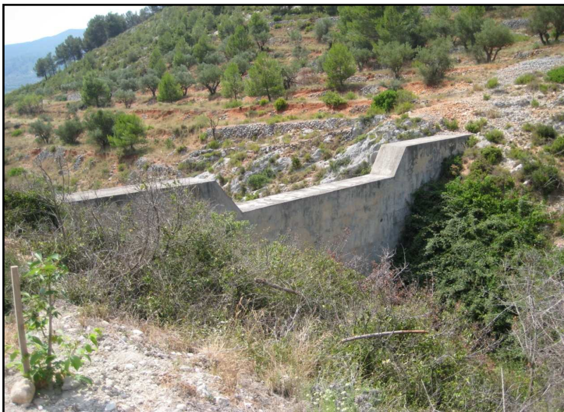
Foto 1. Dique Barranco Basiets. Aguas arriba.
