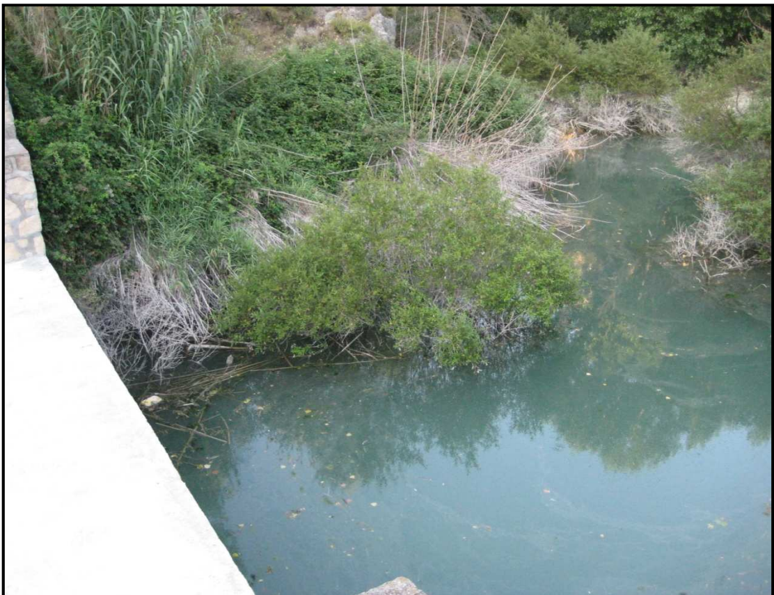
Foto 22. Aguas arriba de la obra. Detalle del agua retenida y vegetación de ribera. Río Penáguila.
