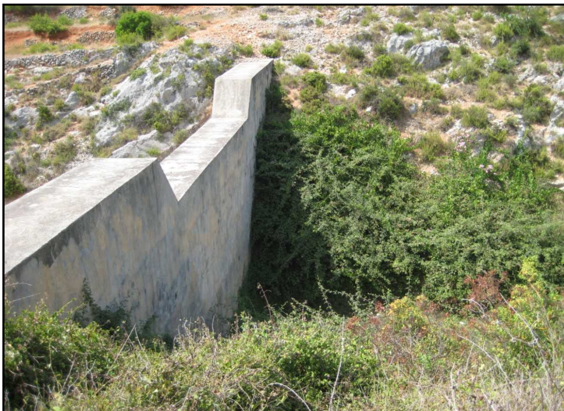
Foto 2. Dique Barranco Basiets.
