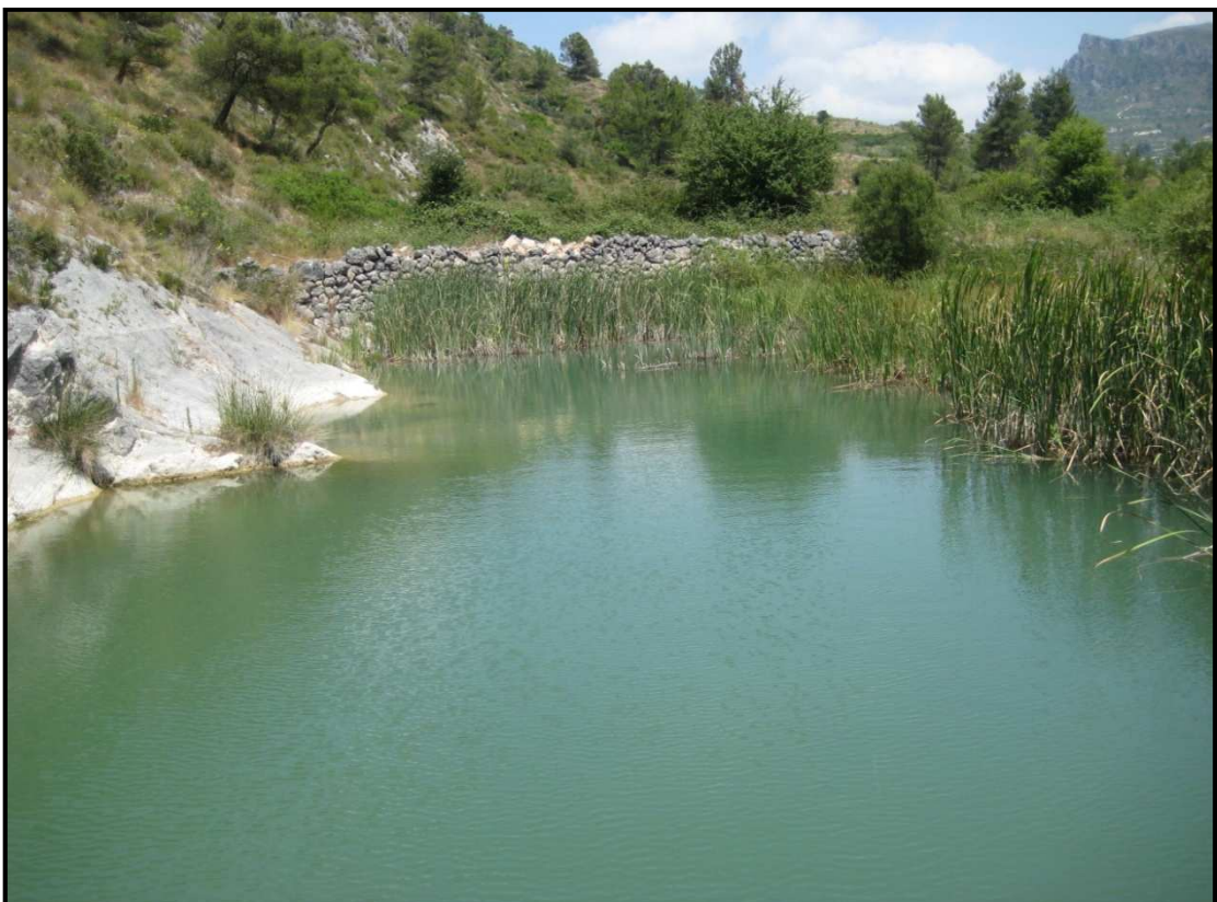
Foto 16. Aguas arriba retención de agua. Tramo medio del barranco de la Encantada.
