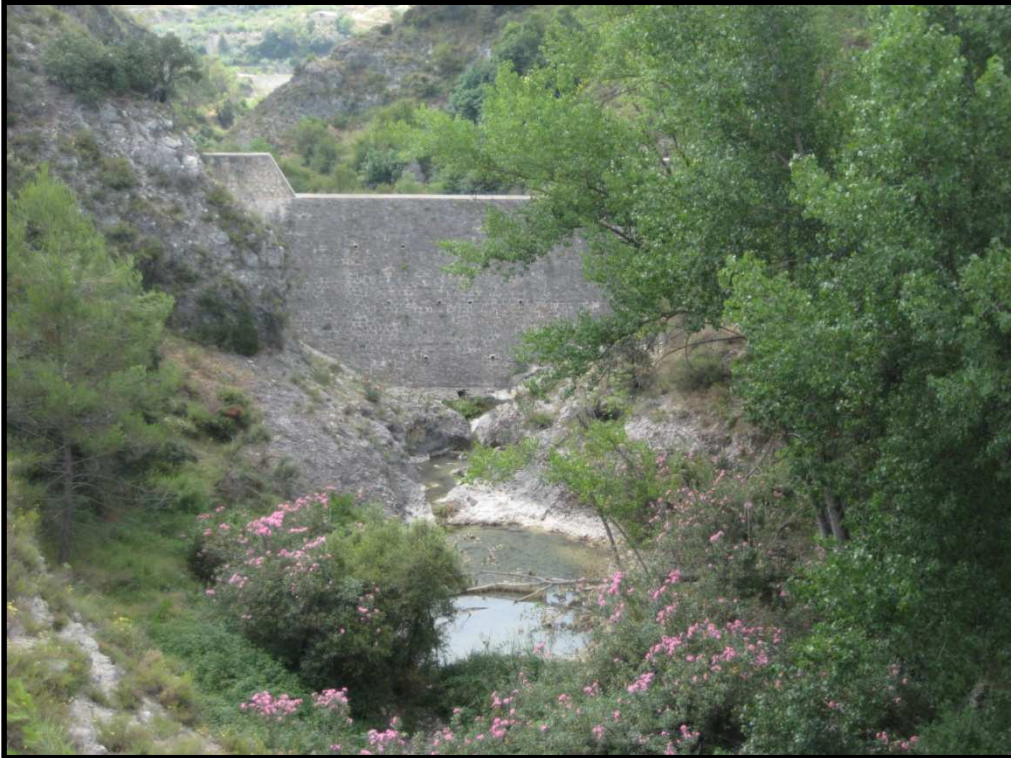
Imagen 6. Hidrotecnia vista desde aguas abajo. Densa vegetación.
