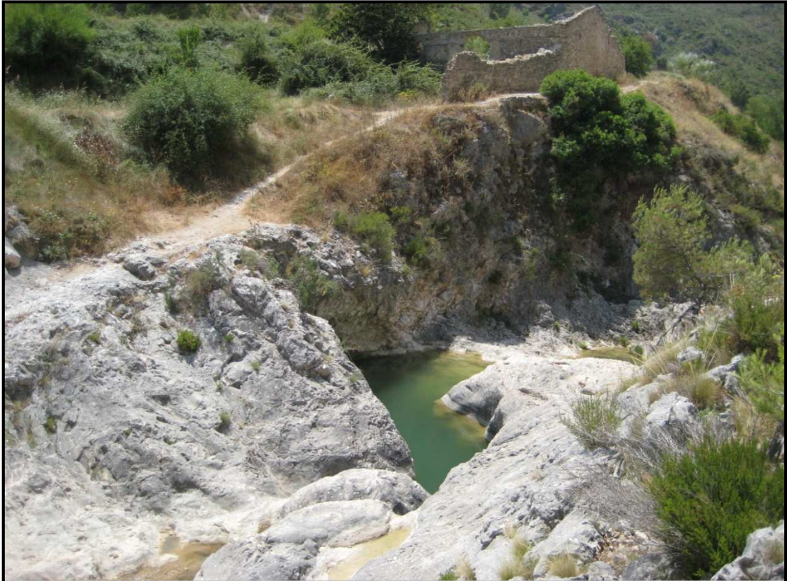
Foto 15. Aguas abajo del dique. Tramo medio del barranco de la Encantada.
