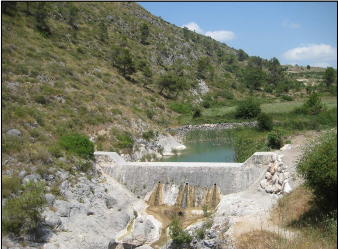
Foto 13. Vista completa del dique en el tramo medio del barranco de la Encantada.
