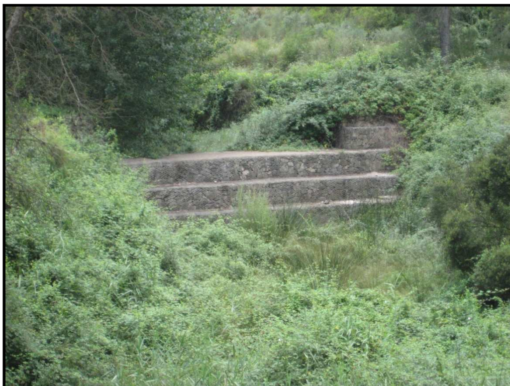
Imagen 16. Hidrotecnia vista desde aguas abajo. Abundante vegetación.
