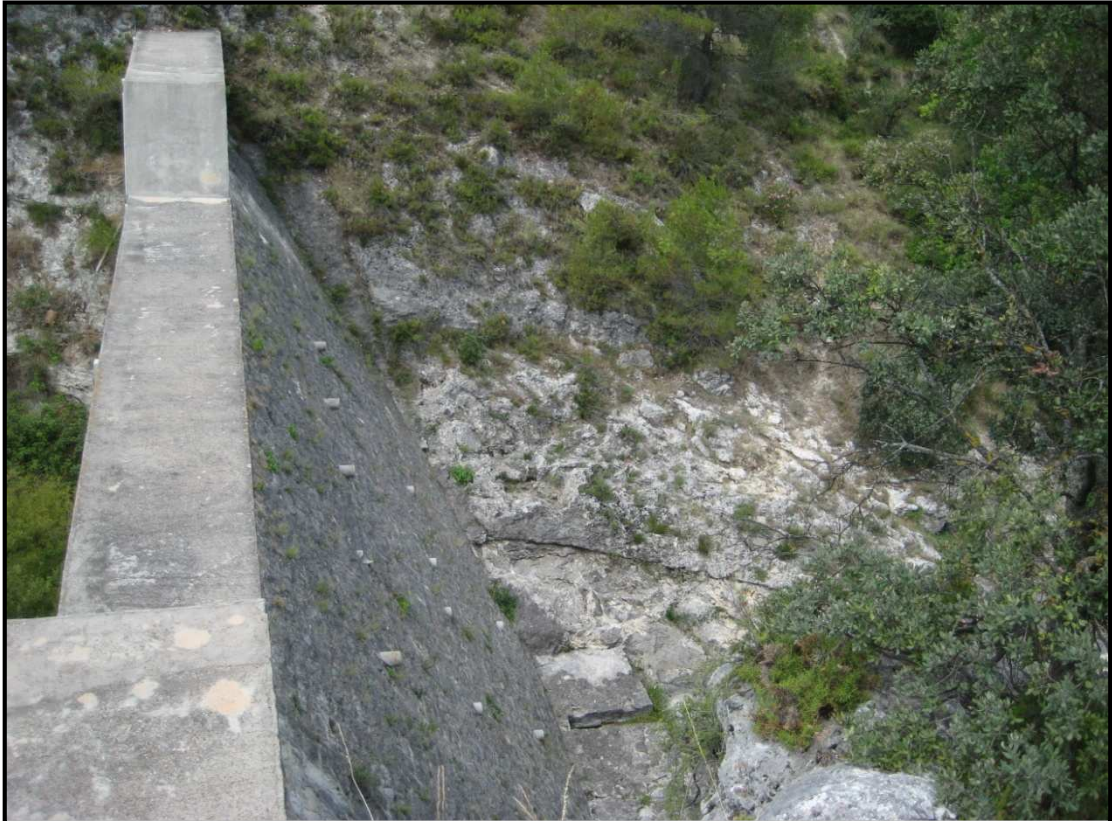
Foto 11. Vista desde las alas. Detalle de mechinales. Tramo alto del barranco de la Encantada.
