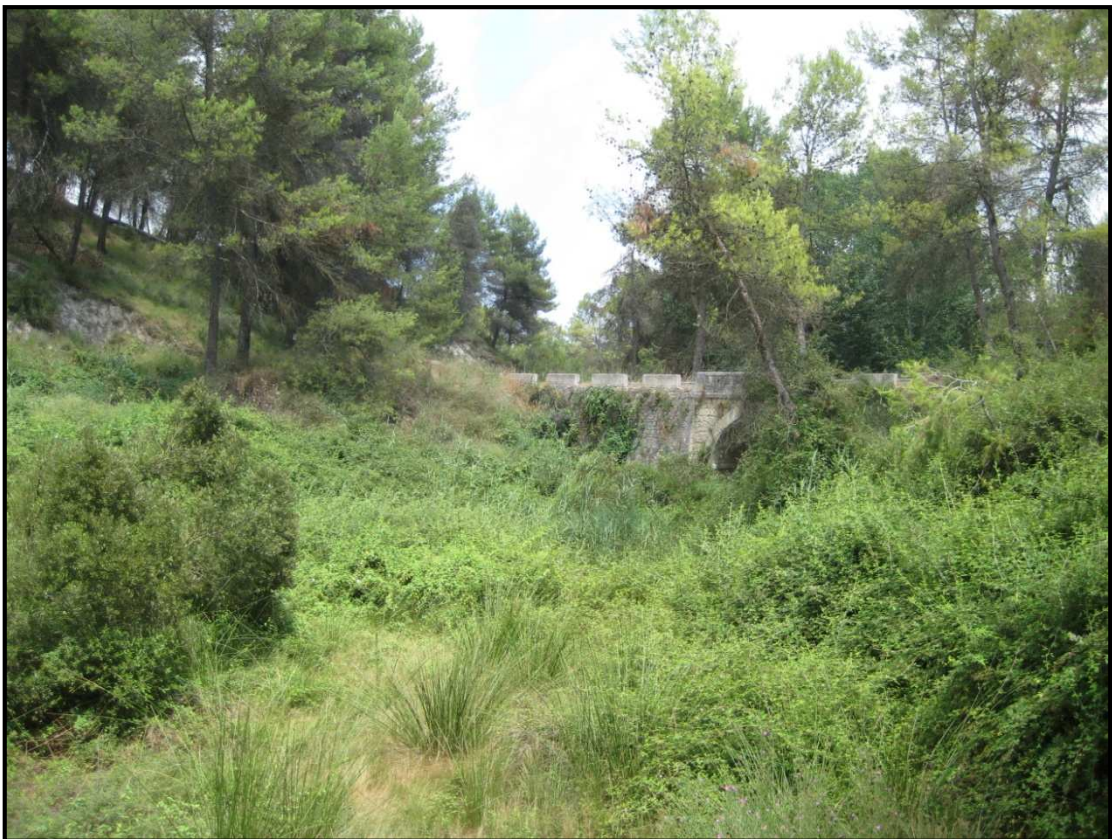
Foto 30. Cauce cubierto por una densa vegetación. Barranco de Azufre.
