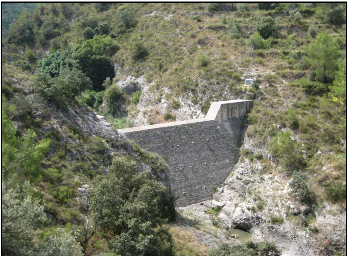
Foto 10. Dique integrado en el medio. Tramo alto del barranco de la Encantada.
