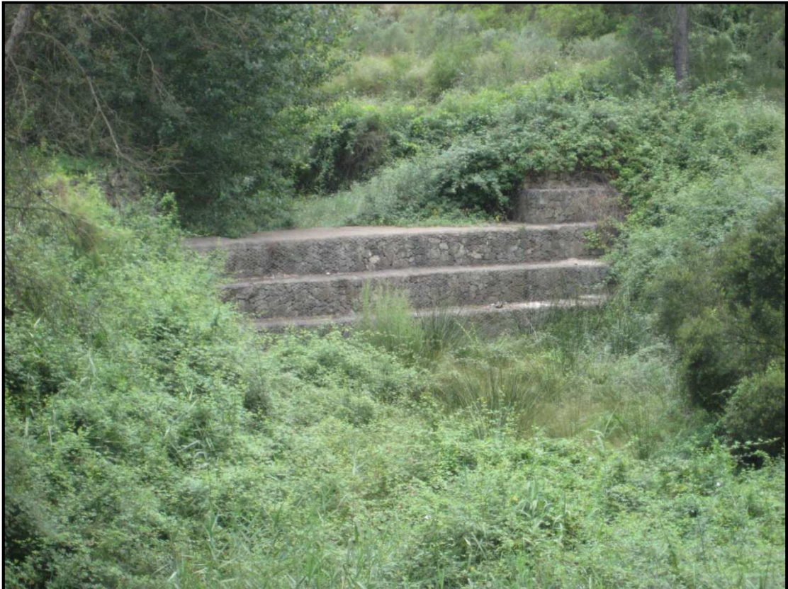
Foto 27. Vista general desde aguas abajo del dique en el barranco de Azufre.
