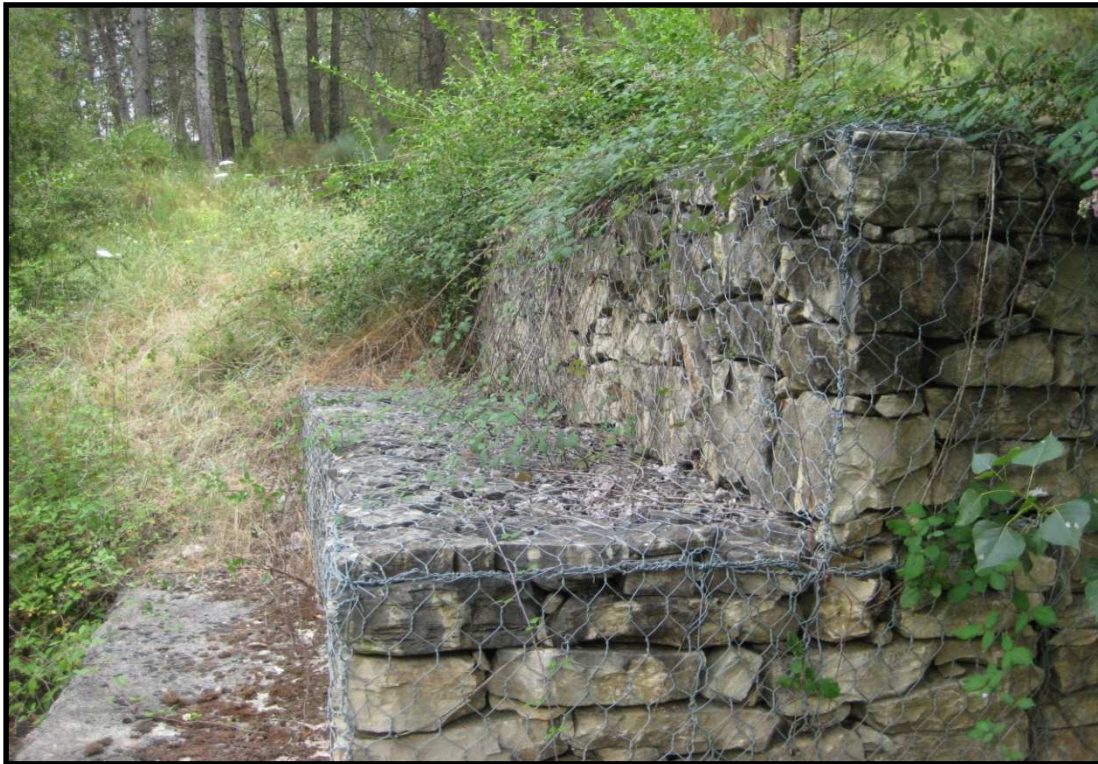
Imagen 17. Detalle del escalonado y mallado de la hidrotecnia.
