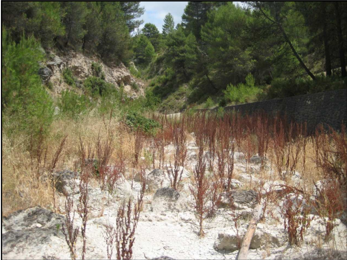
Foto 25. Detalle del lecho aguas abajo. Río Molinar.
