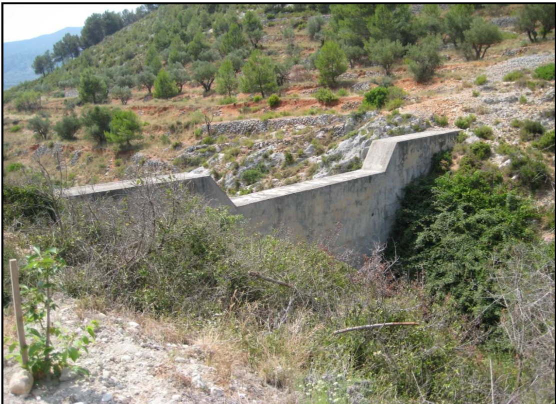
Imagen 4. Hidrotecnia. Vista del vertedero y las alas.
