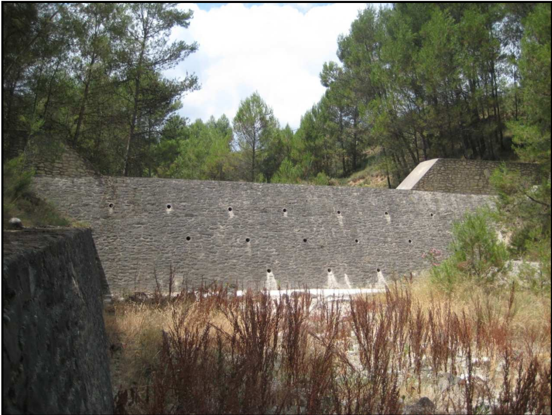
Imagen 13. Hidrotecnia vista desde aguas abajo.
