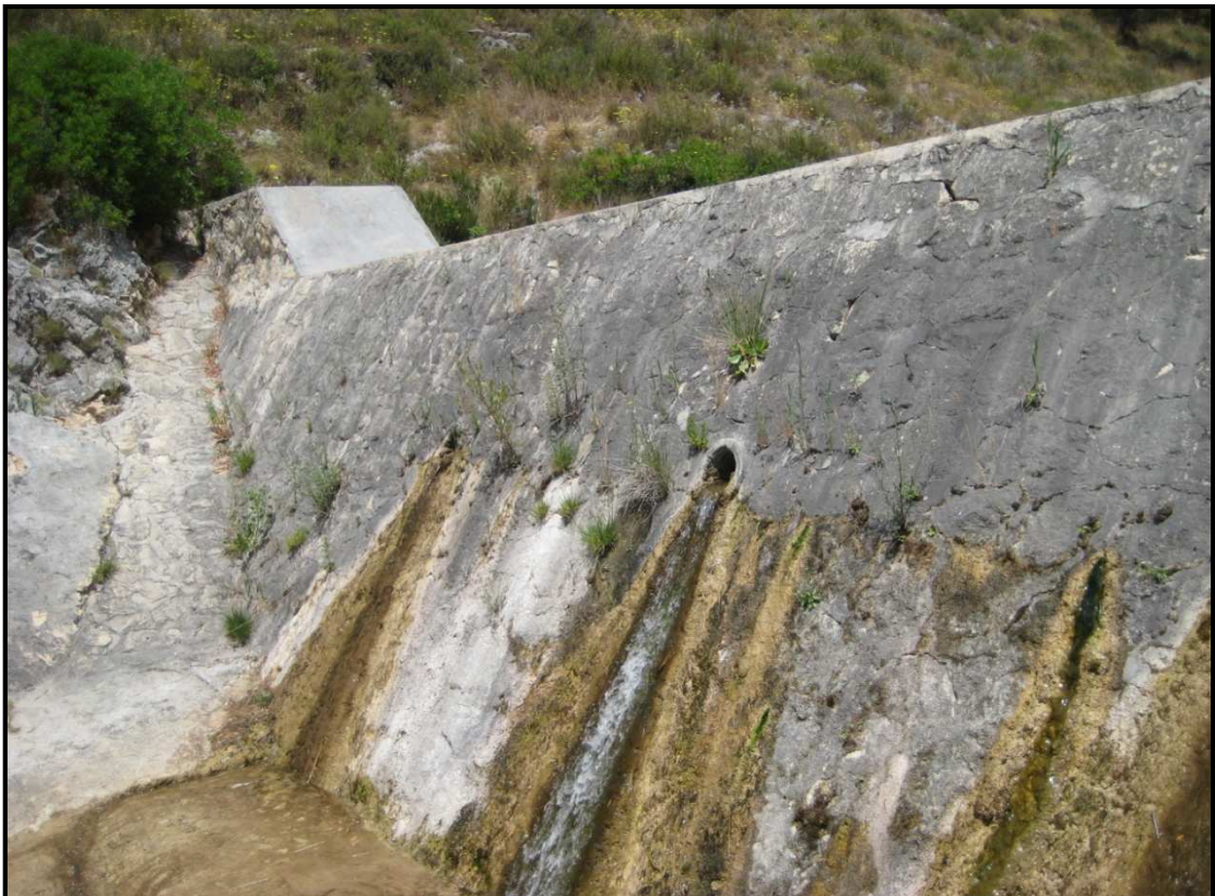
Foto 14. Detalle aguas abajo de mechinales y ala. Tramo medio del barranco de la Encantada.
