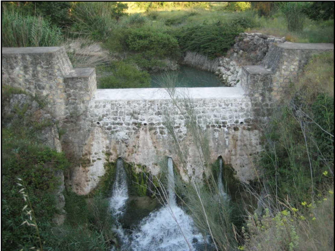
Foto 19. Vista de aguas abajo del dique en el río Penáguila.
