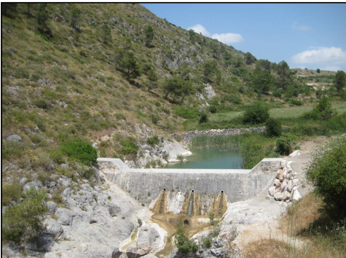
Imagen 9. Hidrotecnia vista desde aguas abajo.
