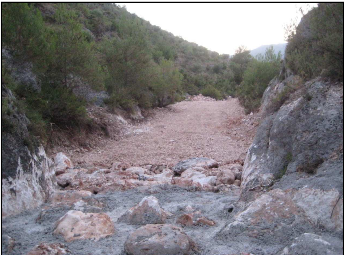
Foto 8. Lecho del cauce aguas abajo. Barranco de les Foyes.
