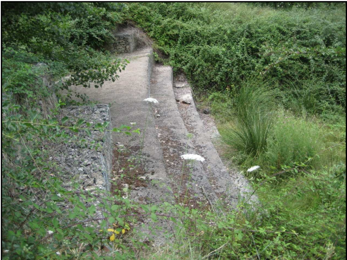
Foto 28. Vista desde el lateral de los gaviones. Barranco de Azufre.
