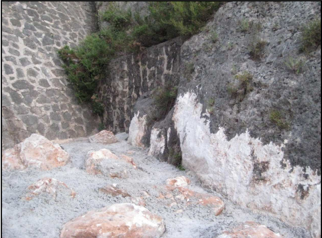
Foto 7. Detalle del encachado remodelado recientemente. Barranco de les Foyes.
