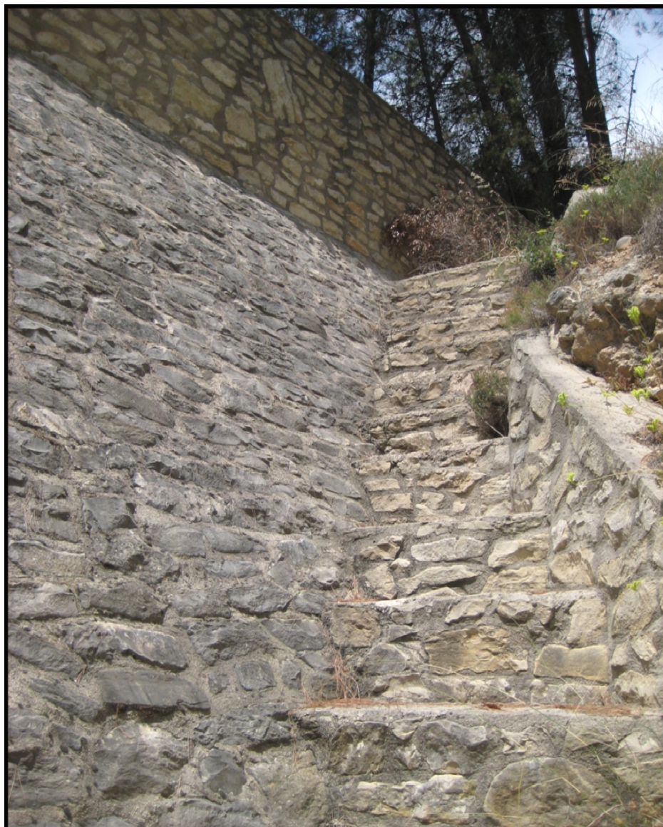
Imagen 15. Escaleras laterales que dan acceso a la obra.
