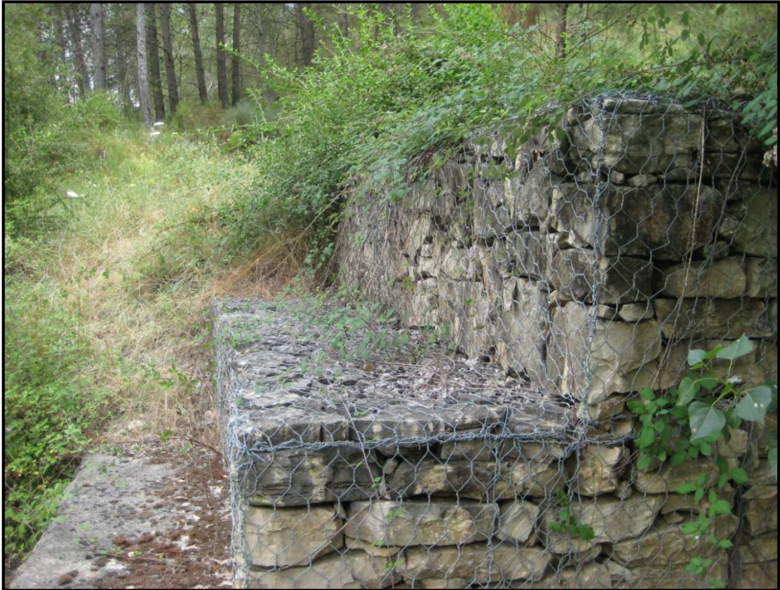
Foto 29. Detalle de gaviones. Barranco de Azufre
