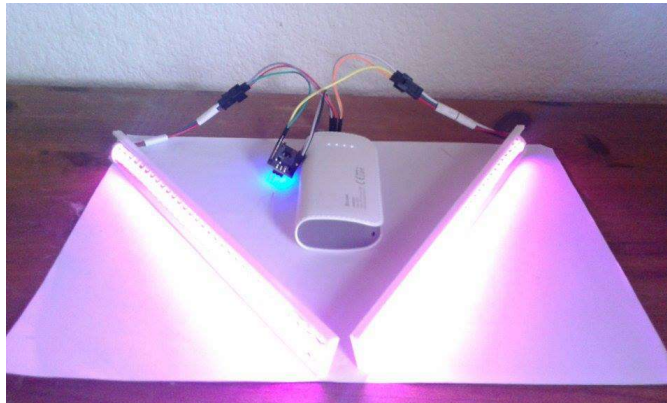
Ilustración 34: Test. Comprobando el abastecimiento de alimentación de la batería.
