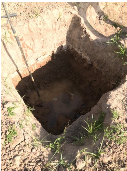
Figura 2. Lugar de instalación del lisímetro.
