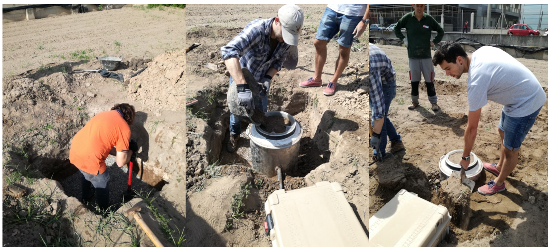
Figura 3. Asentamiento del lisímetro (aporte de grava, aporte arena fina, nivelación)
