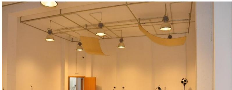
Ilustración 3.1: Primeros difusores instalados, de 3 m<sup>2</sup> cada uno.
