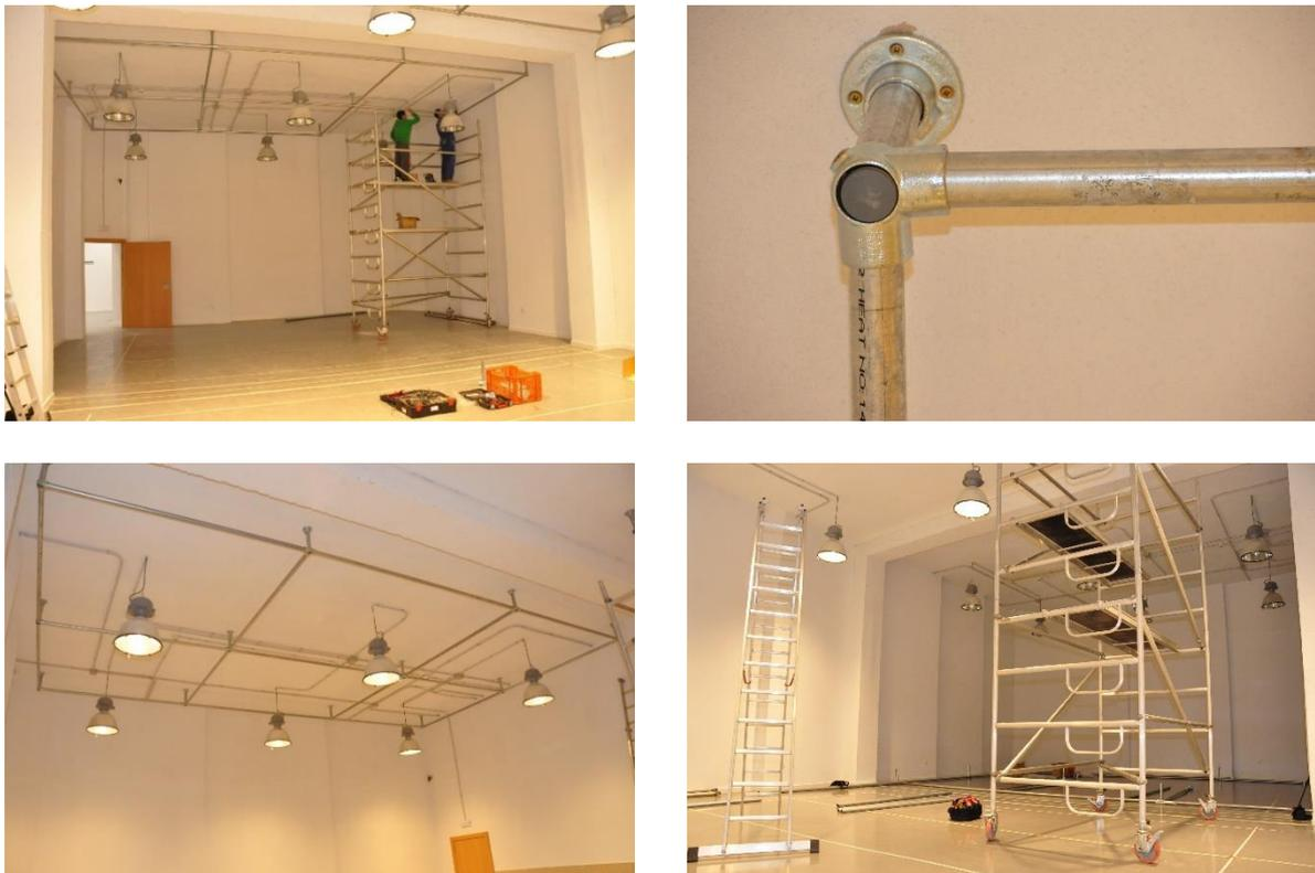
Ilustración 2.12: Montaje y detalles de la estructura metálica.
