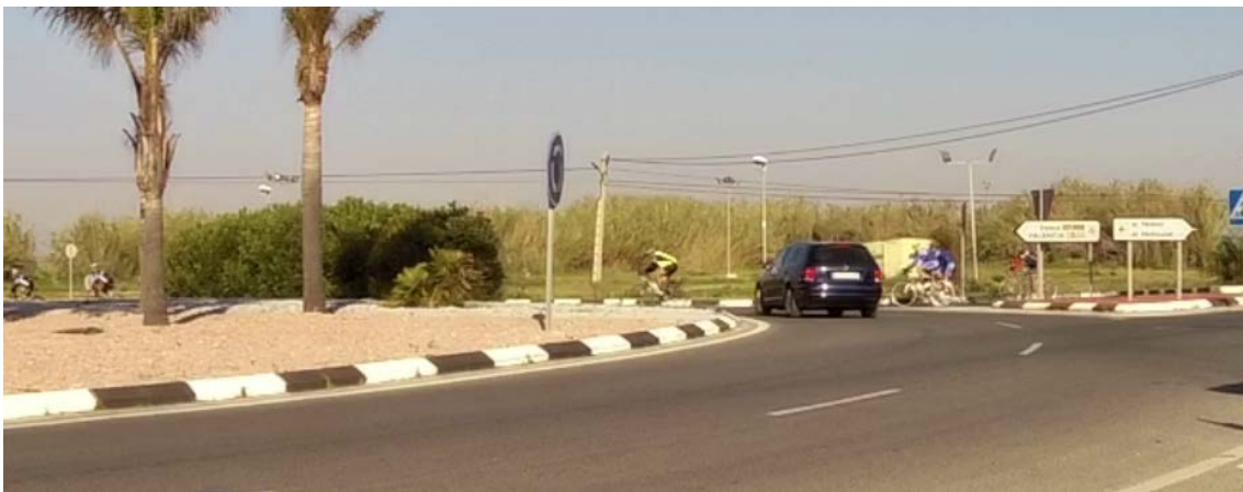
Fig. 320 Conflicto A9 de la glorieta G26 (8/4/2017).
