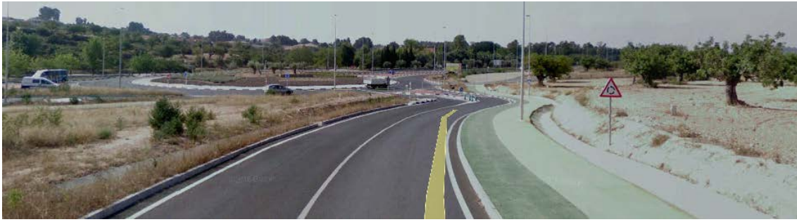
Fig. 109 Marcas viales en calzada de separación del carril bici.
