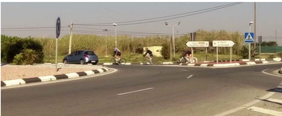
Fig. 324 Conflicto A15 de la glorieta G26 (8/4/2017).
