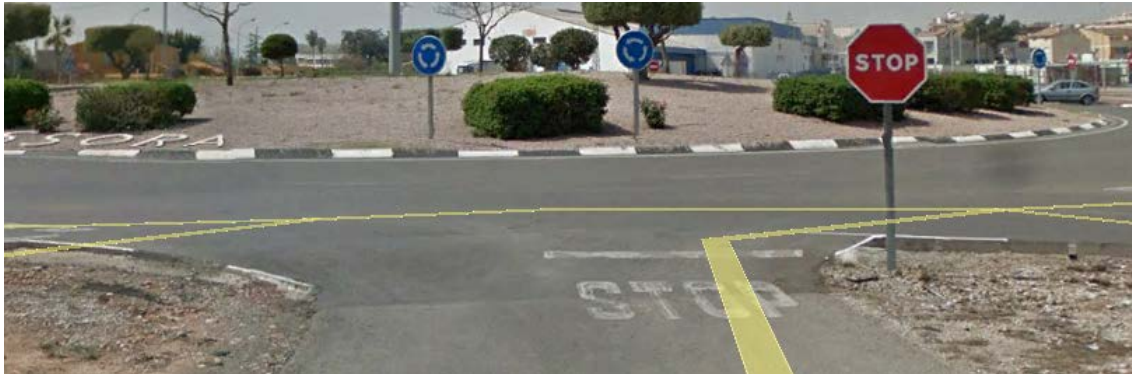
Fig. 105 Ramal 7 de la glorieta G1, entrada E7 con STOP.
