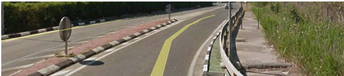
Fig. 333 Zona limitada por bordillo en la salida S4 de la glorieta G26.
