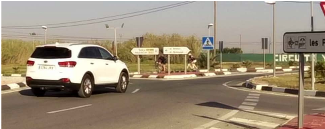
Fig. 321 Conflicto A10 de la glorieta G26 (8/4/2017).
