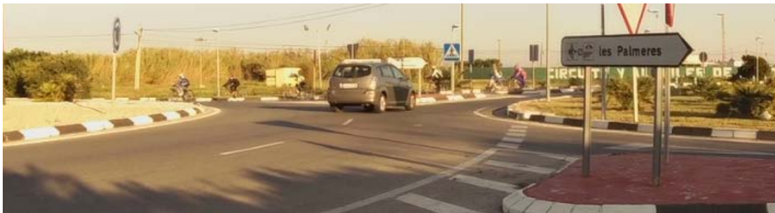
Fig. 315 Conflicto A1 de la glorieta G26 (8/4/2017).
