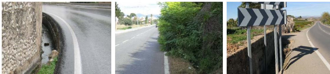
Fig. 29 Escalón lateral (izquierda) y obstáculos (centro y derecha) en la red (Corb, 2017).
