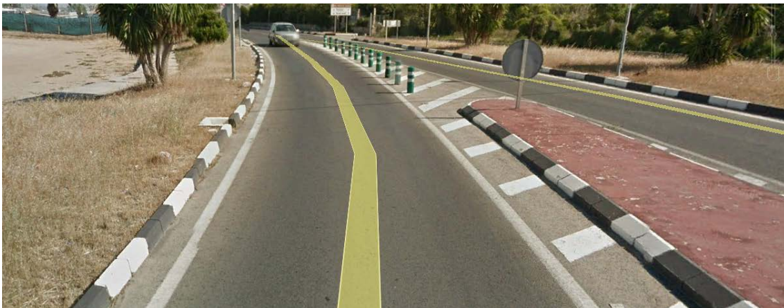
Fig. 325 Zona de aproximación de la entrada E1, lugar donde se produce el conflicto A27 de la glorieta G26.
