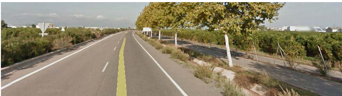
Fig. 110 Acequia y naturaleza como separación del carril bici.
