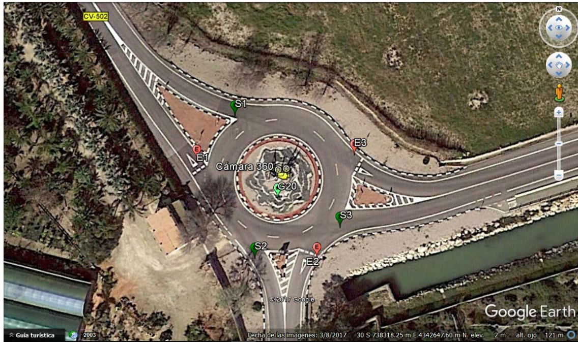
Fig. 160 Glorieta G20 grabada y con posible ubicación de cámara 360.
