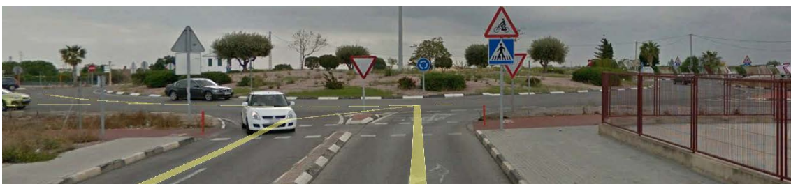
Fig. 106 Glorieta G1 con acera en entrada y salida del ramal 2.
