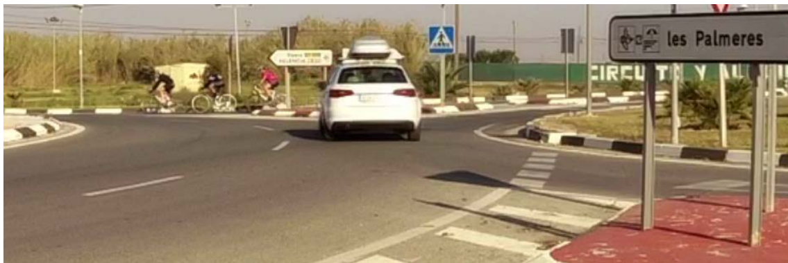
Fig. 322 Conflicto A11 de la glorieta G26 (8/4/2017)
