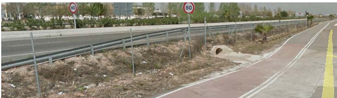
Fig. 108 Valla metálica de separación del carril bici.
