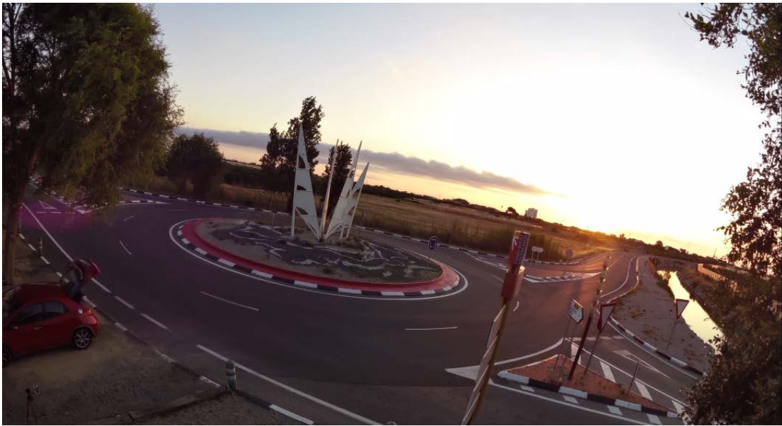
Fig. 260 Vista cenital completa de la glorieta G20 desde virb en altura.
