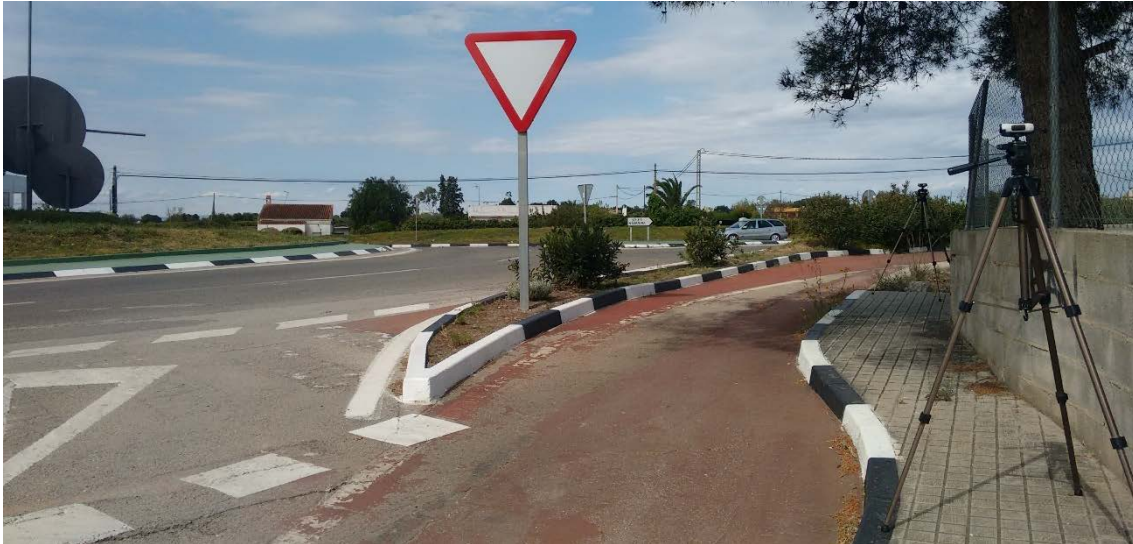
Fig. 218 Colocación de la Cámara A y B en la glorieta G15 (5/4/2017).
