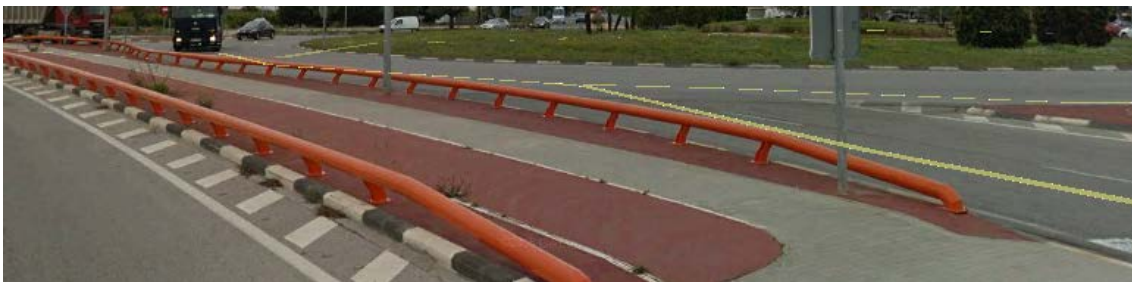
Fig. 115 Barrera de seguridad coloreada como separación del carril bici.
