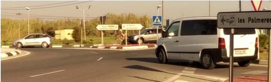
Fig. 319 Conflicto A8 de la glorieta G26 (8/4/2017).
