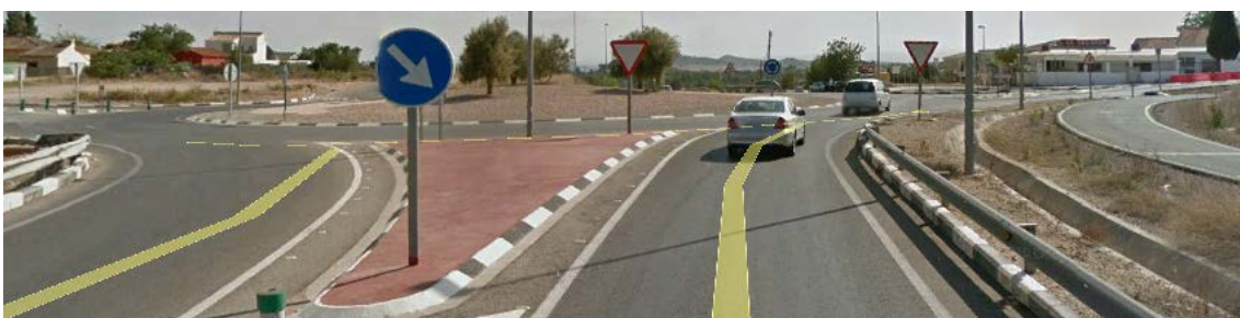
Fig. 116 Bordillo en isleta separadora de carriles.
