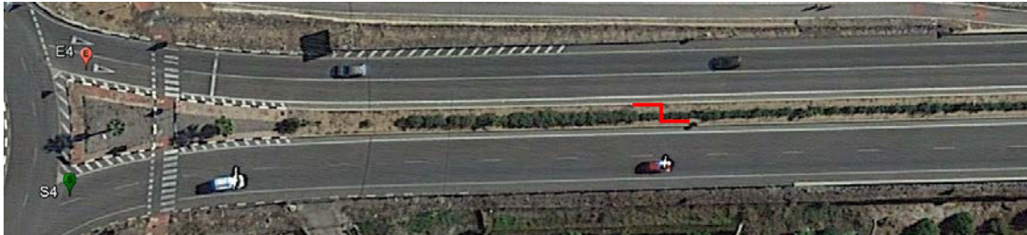
Fig. 107 Mediana en ramal 4 de la glorieta G1.
