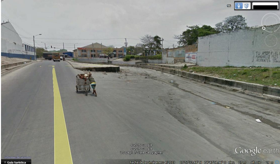
Figura 24. Ramal de desagüe carrera 21.
