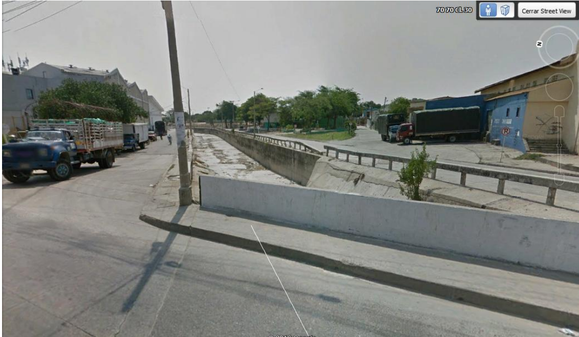
Figura 27. Vista general tramo inicial canal de desagüe.
