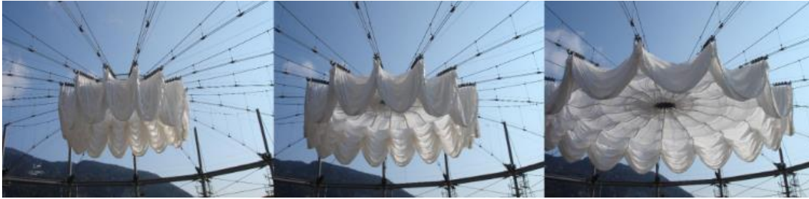
Figura 31. Ejemplo de cubierta de lona retractil en Kufstein (Australia)
