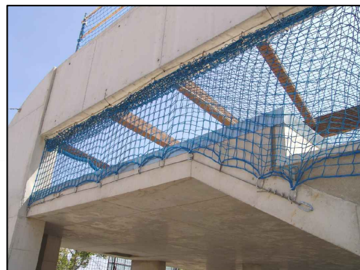
Red en huecos del prefabricado
