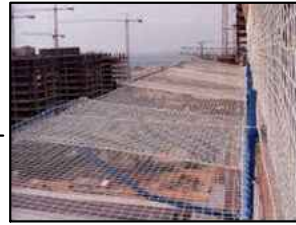
Redes de seguridad perimetrales en cubierta
