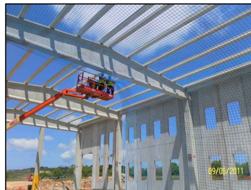
Red montajes cubierta
