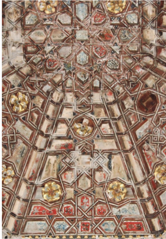
Fig. 3.11. Techumbre de la Capilla de Santo Domingo de la Iglesia del mismo nombre, Santa Cruz de La Palma (Islas Canarias). Construida en la segunda mitad del siglo XVI. Faldón menor y detalle de la rueda de 8 del almizate.
