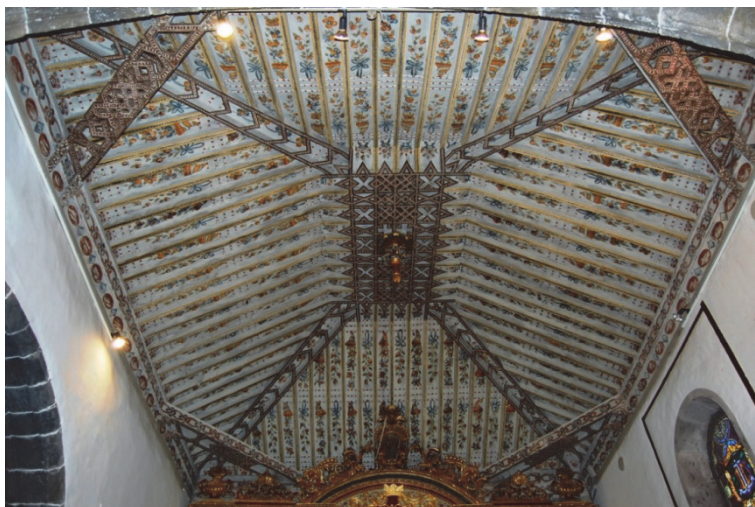
Figura 3.6. Techumbre de la Capilla Mayor de la Iglesia del Dulce Nombre de Jesús, La Guancha (Tenerife, Islas Canarias). Carpintería de egunda mitad del s. XVIII, repintado por José Gascón en 1988. Armadura de cuatro faldones con almizate.
