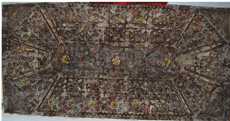
Figura 3.4. Cubierta de la Capilla del Cristo atado a la columna de la Iglesia del antiguo Convento de Santo Domingo, Santa Cruz de La Palma (Islas Canarias). 1554-1567. Armadura de limas moamares.
