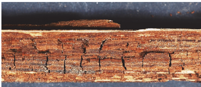
Figura 4.1. Madera atacada por hongos de pudrición, con el característico cuarteado resultante.
