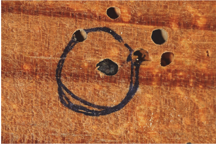
Figura 4.2 y 4.3. Anobium Punctatum o carcoma común. Tamaño y aspecto de sus galerías y daño de la madera (resulta interesante la presencia de uno de estos insectos dentro de la galería señalada).
