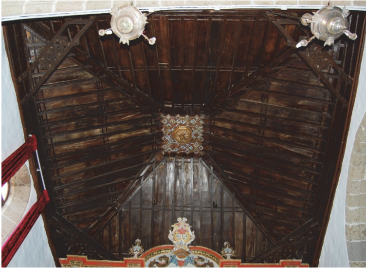
Figura 3.5. Techumbre de la Capilla de Nuestra Señora del Rosario de la Iglesia de San Juan Bautista, San Juan de la Rambla (Tenerife, Islas Canarias). Segunda mitad del siglo XVIII. Armadura de cuatro faldones con el mástil cubierto por un mínimo trabajo de lacería y un pequeño pinjante.
