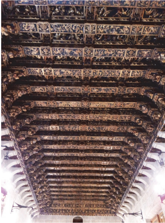
Figura 1.2. Alfarje de la Cámara Dorada del Consulado del Mar, Lonja de la Seda, Valencia (su lugar de origen fue la antigua Casa de la Ciudad, derribada a lo largo del siglo XIX, y trasladado a esta nueva ubicación en torno a 1921). Es obra de Joan del Poyo (1418-1428).
