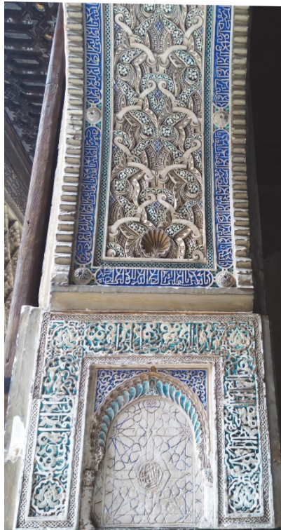
Figura 2.3. Decoración realizada con yeso con aplicación de esmalte en los fondos, realizando figuras geométricas y/o epigrafía árabe. Reales Alcázares, Sevilla (periodo de construcción durante el dominio musulmán, siglos X-XIII).
