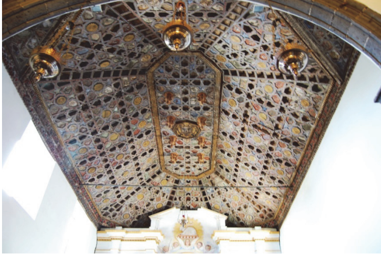
Figura 1.5. Artesonado ochavado del Presbiterio del Santuario del Santísimo Cristo de los Dolores, Tacoronte (Tenerife, Islas Canarias). La construcción se finaliza en torno a 1664 y se policroma un año después, en 1665.
