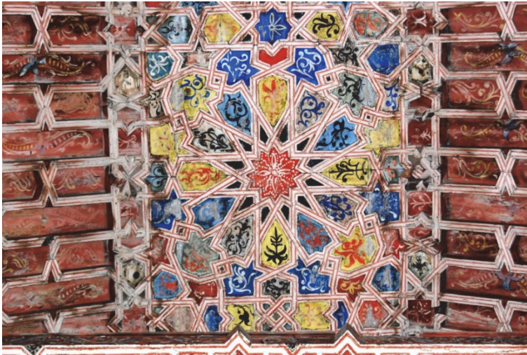
Figura 3.12. Detalle de una de las ruedas de lazo (de 12) en el almizate de la nave central en la Iglesia del Salvador, Santa Cruz de La Palma (Islas Canarias).
