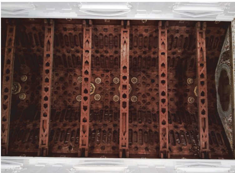
Figura 2.4. Armadura de par y nudillo de la iglesia del Convento de Santa Paula, Sevilla. Ejecutado por Diego López de Arenas (1623).
