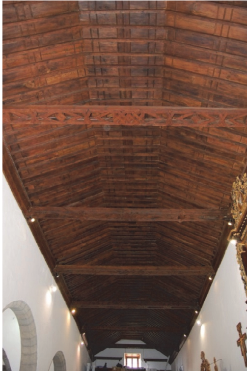
Figura 4.12. Artesonado de la nave principal de la Iglesia de San Francisco, Puerto de la Cruz (Tenerife, Islas Canarias) después de su restauración. En el transcurso de la misma fue eliminado el durmiente policromado o solera, fechado en torno a los inicios del siglo XVIII.
