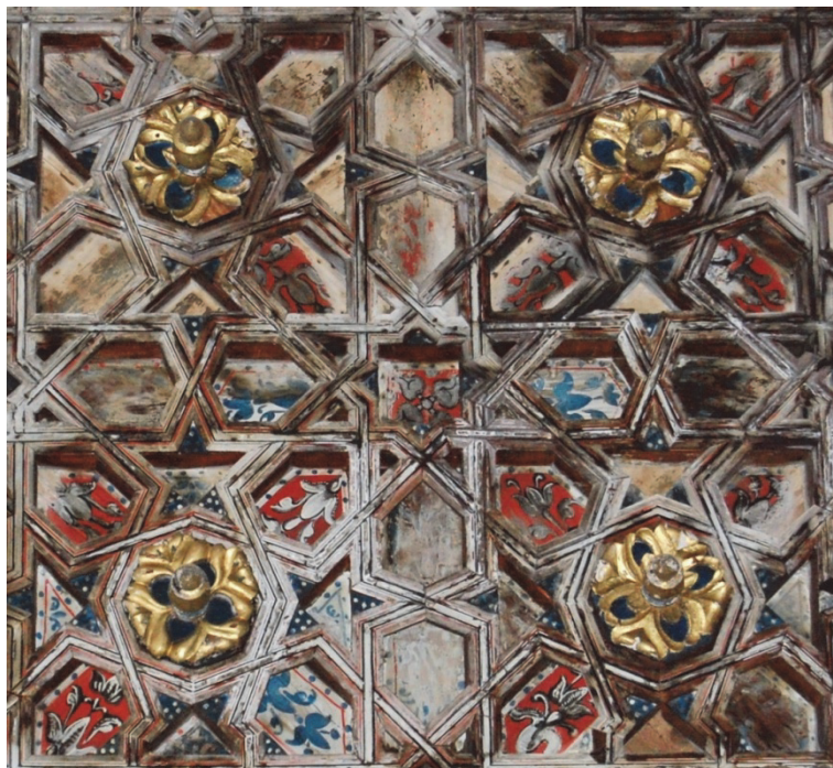
Figura 3.13. Labores de la lacería en el faldón mayor de la Capilla del Cristo atado a la columna en la Iglesia de Santo Domingo, Santa Cruz de La Palma (Islas Canarias). En el centro se aprecia un lazo de ocho que permite observar, de manera concéntrica y del interior al exterior, la evolución de las estrellas de primer, segundo y tercer cruce.
