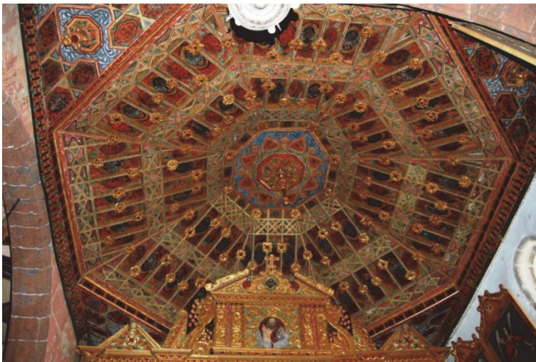
Figura 3.3. Techumbre de la Capilla de Nuestra Señora del Rosario en la Iglesia de Santa Catalina mártir de Alejandría, Tacoronte (Tenerife, Islas Canarias). Carpintería de finales del s. XVI y policromado y dorado de 1698. Armadura a lima bordón nones.
