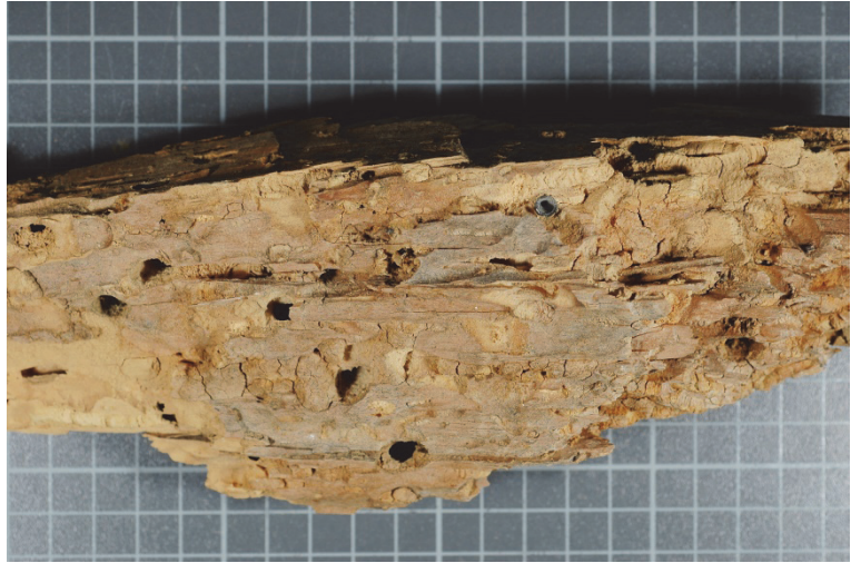
Figura 4.4 y 4.5. Hylotrupes Bajulus o carcoma gigante. Tamaño y aspecto de sus galerías y daño de la madera.
