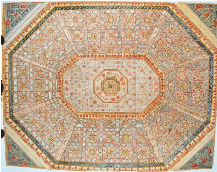
Figura 3.7. Techumbre de la Capilla de Animas de la Iglesia de la Inmaculada Concepción, La Laguna (Tenerife, Islas Canarias). 1650 aprox. Armadura de ocho faldones con almizate.
