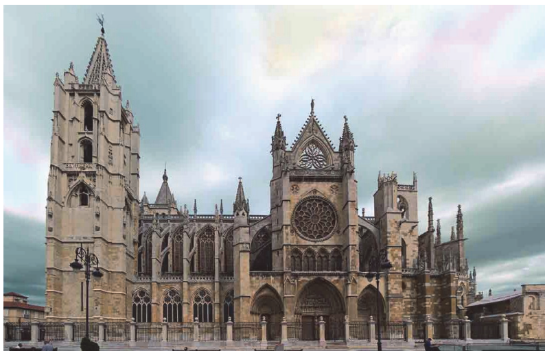
Figura 2.1. Exterior de la Catedral Gótica de León (1221).
