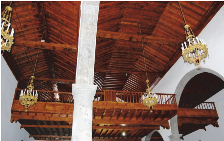
Figura 3.1. Armaduras de parhilara en las naves laterales, y de par y nudillo en la nave central. Santuario del Santísimo Cristo en Tacoronte (Tenerife, Islas Canarias).
