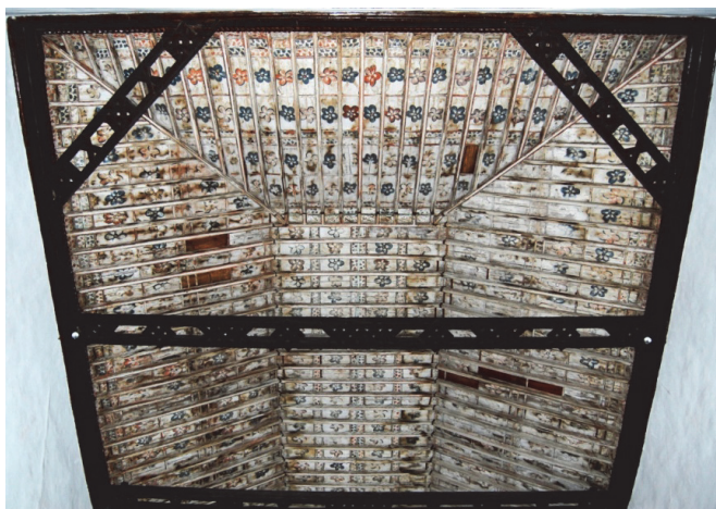
Figura 3.8. Detalle del artesonado de la nave central de la Iglesia del Antiguo Convento de Santo Domingo, La Orotava (Tenerife, Islas Canarias). Finales del s. XVII. Los cuadrales y tirantes son doblados y con profuso trabajo lacérico.
