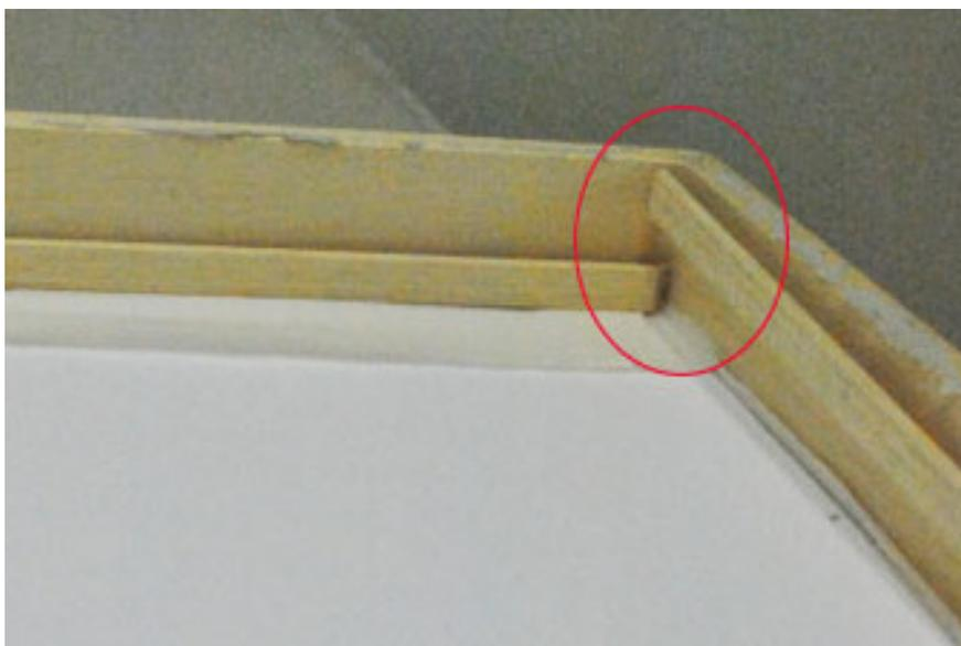
Fig. 61. Detalle de elementos separados en el interior de la obra.
