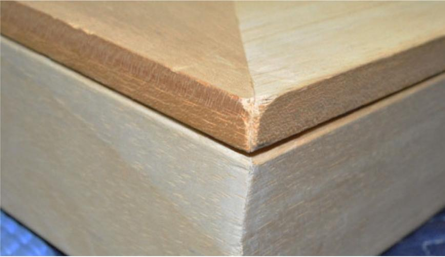
Fig. 63. Detalle de la esquina tratada con limpieza superficial a base de goma de borrar y lijado extrafino para eliminar astillas.
