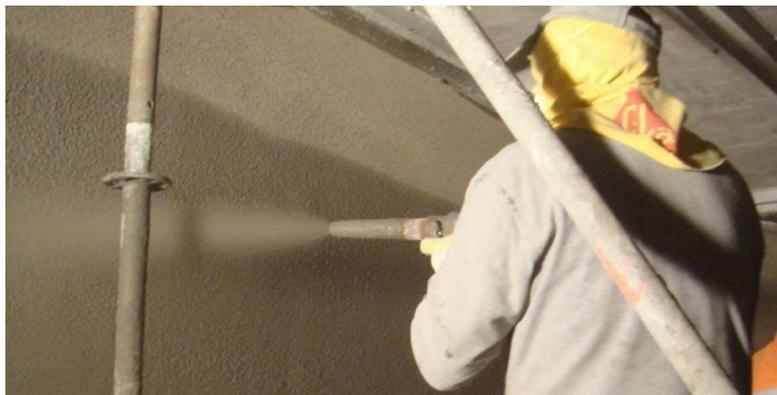
Fig. 1.5 Aplicación de revestimiento superficial de protección. Sika (2017).
