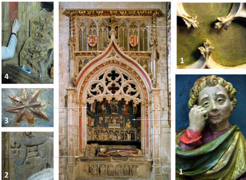
Fig. 3.4. Sepulchro de Villaespesa , 1418-1422, Catedral de Tudela (Navarra, España). (1) Superficie texturizada con gradina, (2) anagrama, (3) motivo aplicado con forma de estrella, (4) Medición de pH y conductividad de la superficie. © Gobierno de Navarra.
