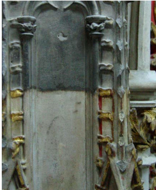
Fig. 2.2. Gruesa capa de suciedad adherida a la superficie de la jamba del Sepulcro de Villaespesa 1420-1422, Catedral de Tudela (Navarra, España). © Gobierno de Navarra.
