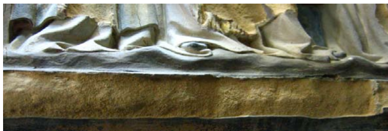
Fig. 2.3. Deplacación de policromía. Sepulcro de Villaespesa 1420-1422, Catedral de Tudela (Navarra, España). © Gobierno de Navarra.
