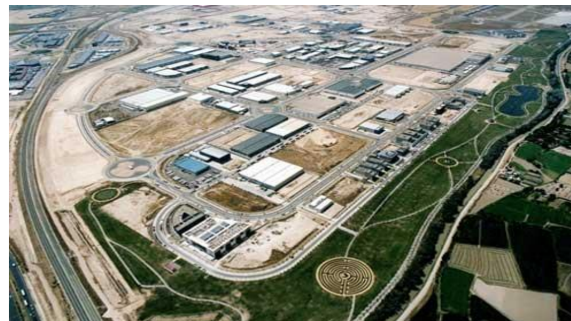
Ilustración 8. Imagen aérea de Zaragoza Plaza, durante su construcción.
