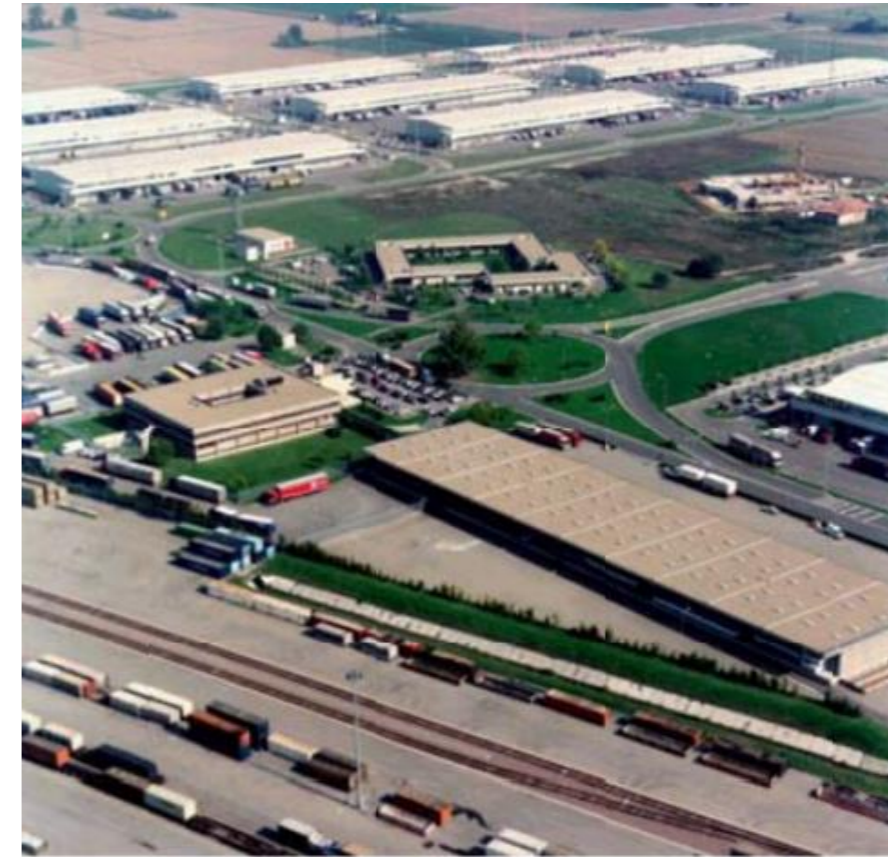
Ilustración 7. Vista aérea del interpuerto de Bolonia.
