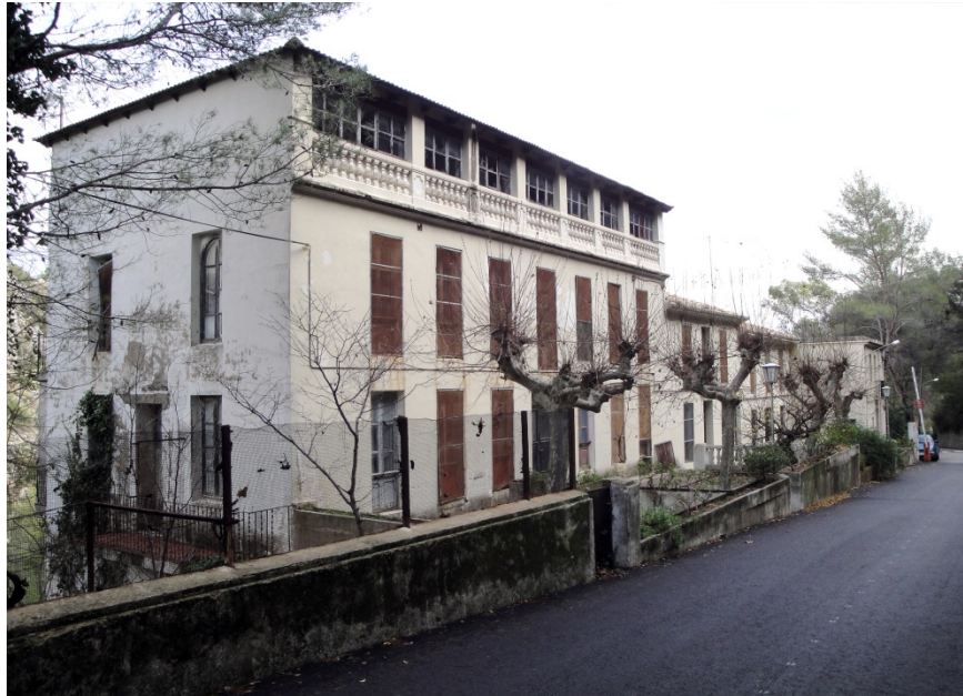
Img. 156: Casas para el Personal del Sanatorio de Fontilles. Estado actual. 3ª Fase—Edificio Izquierda; 2ª Fase—Edificios centrales; 1ª Fase—Portería derecha (fondo).
