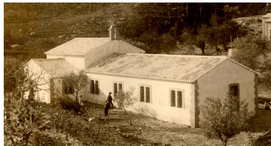
Img. 33: Pabellón de La Purísima. Estado actual.
