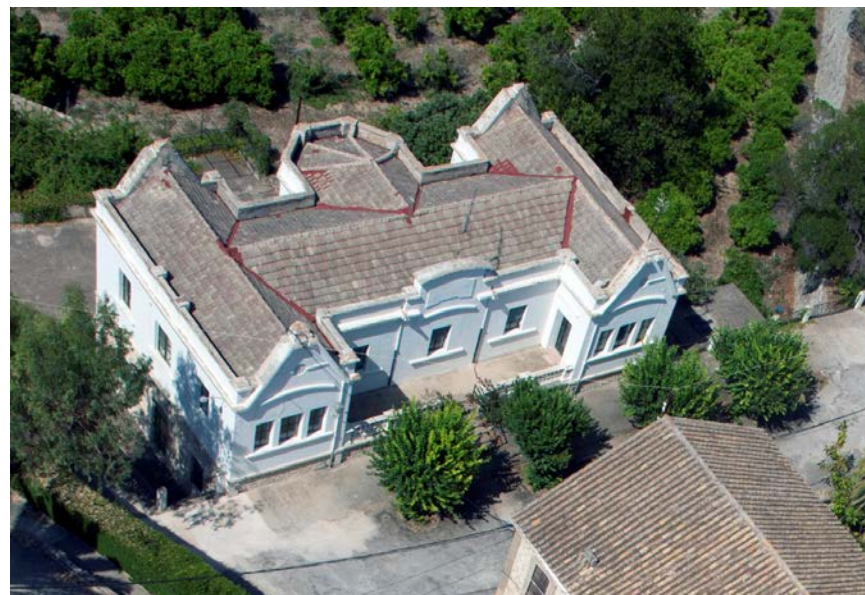
Img. 216: Vista aérea de la Clínica. Cubierta original (huella de teja plana esmaltada). Fotografía aérea mediante UAV (Unmanned Aerial Vehicle). Julio 2015.
