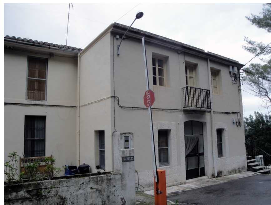
Img. 153: Casa del Portero. Estado actual en uso.
