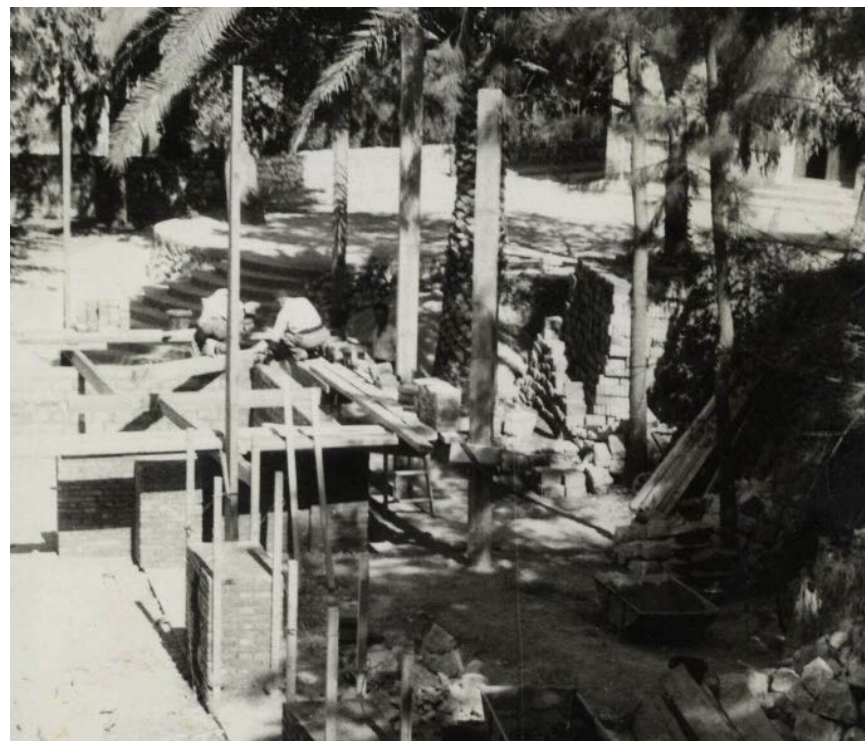
Img. 114: Proceso ejecución Teatro. Cimentaciones y estructuras Fase 3. Año 1958. 355
