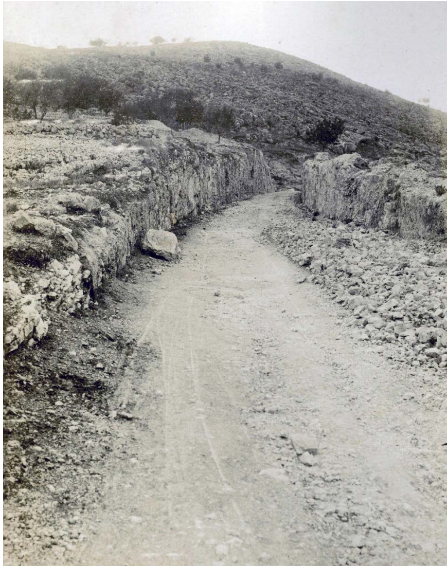
Img. 25: Ejecución de un desmonte de carretera de Fontilles. Fotógrafo Isidro Laporta. 96
