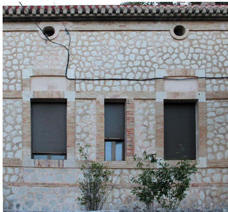
Img. 200: Ventanales alzado este. Huecos originales y modificados. Estado actual.
