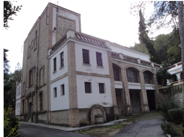
Img. 106: Pabellón de Baños. Salón de Actos. Teatro (Fase 3). Estado actual.
