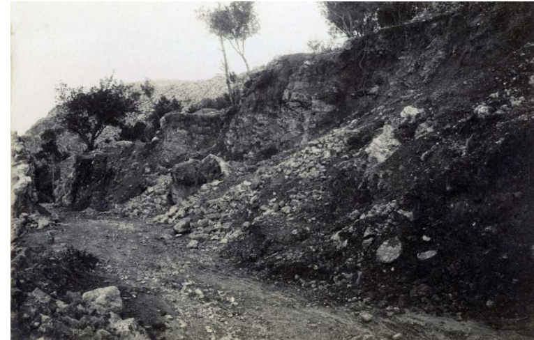
Img. 19: Construcción de los accesos en los terrenos de Fontilles. Década 1900. 72
