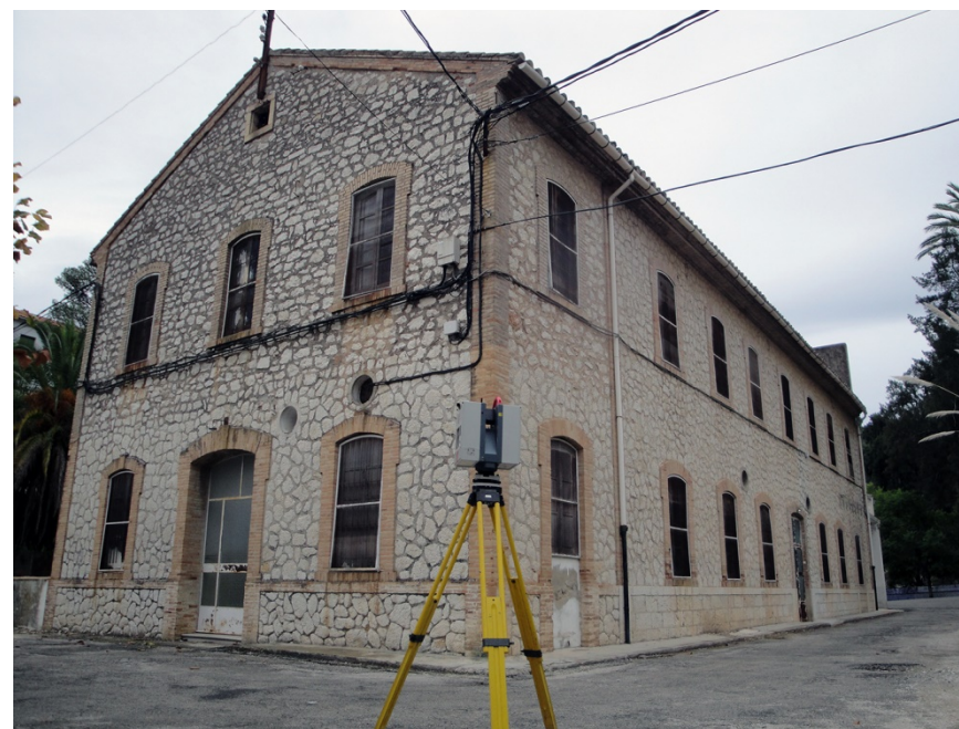
Img. 120: Pabellón Central. Pabellón de Comedores. Laboratorios y Clínica. Proceso de levantamiento mediante Scanner Láser. Estado actual.
