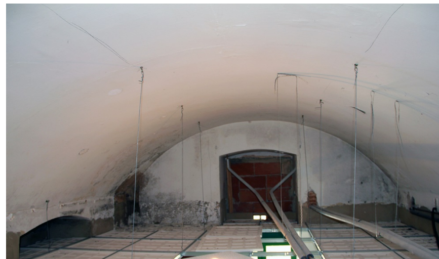
Img. 230: Estructura horizontal de bóveda tabicada. Estado actual.
