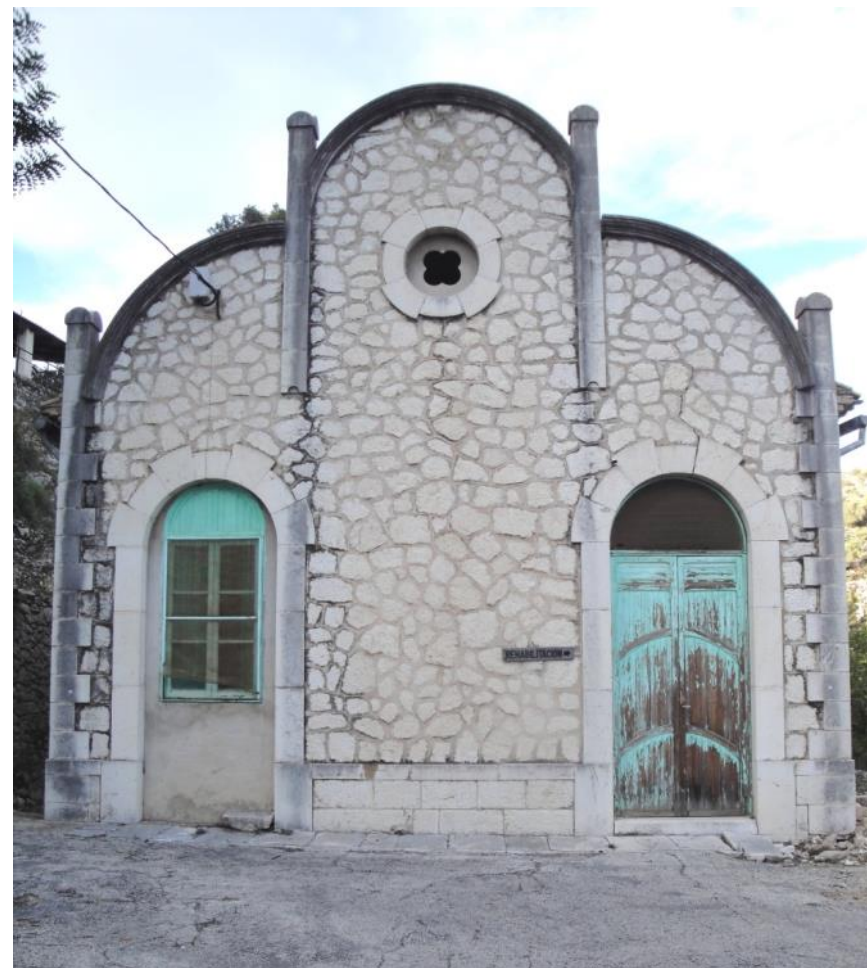
Img. 245: Fachada principal de la Enfermería de Mujeres. Estado actual.
