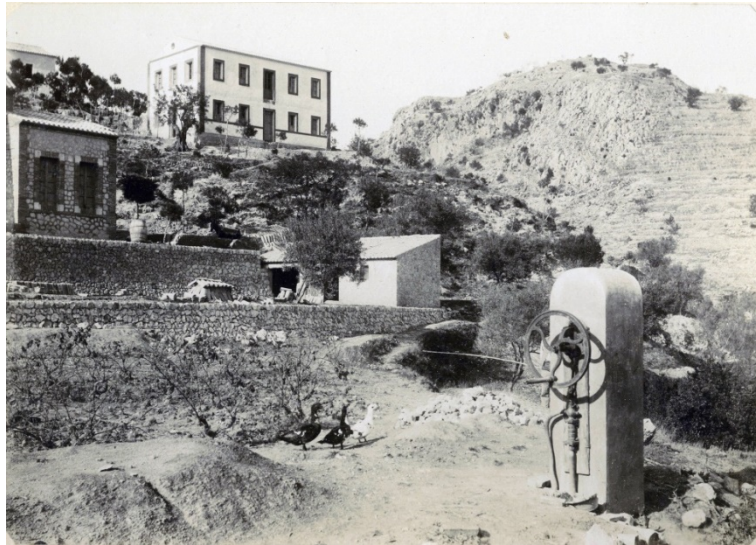
Img. 29: Vista general del Sanatorio. Instalación Bomba de agua. Fotógrafo Isidro Laporta. Década 1900. 118
