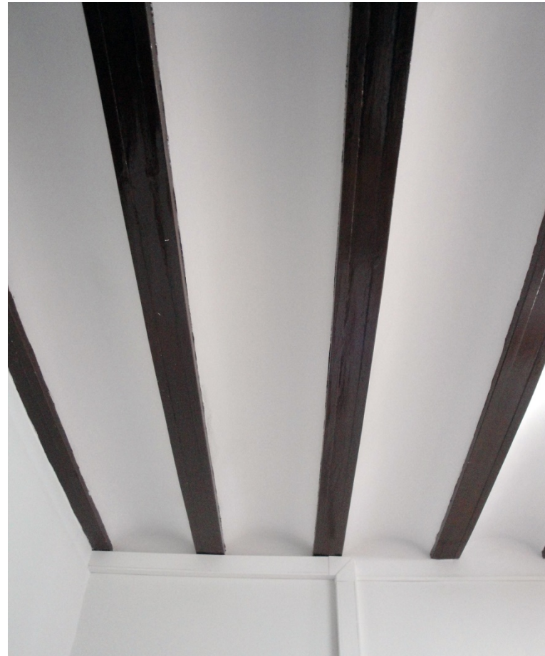
Img. 323: Forjado de revoltón cerámico del Pabellón de Administración.
