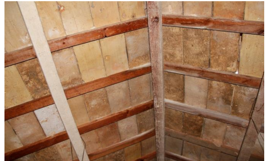
Img. 269: Estructura de cubierta. Correas, parecillos y entabicado de rasilla cerámica.
