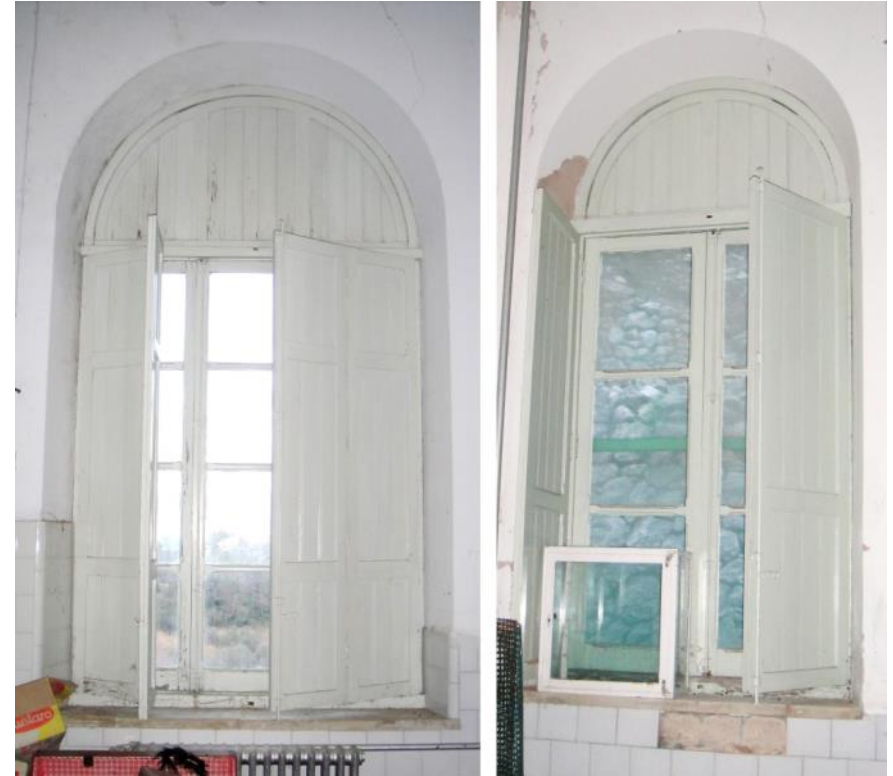
Img. 276: Ventana tres hojas y fraileros de cuatro hojas, orientación Este; Ventana dos hojas y contraventana, orientación Oeste.
