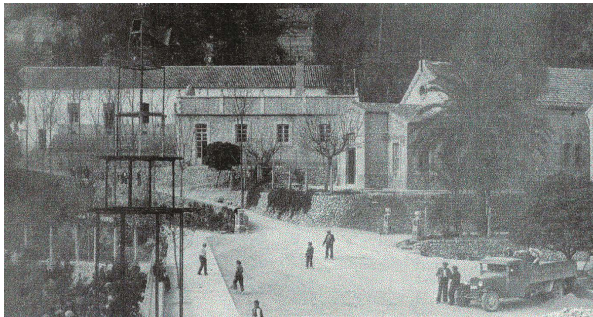
Img. 161: Vista general del Sanatorio. Al fondo Pabellón de Lavandería y Pabellón de Desinfección. Década 1920-30. 480
