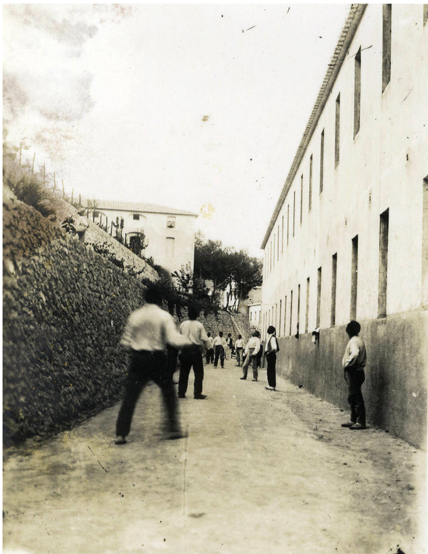
Img. 74: Fachada posterior Pabellón de San Rafael. Enfermos jugando a la pelota valenciana. 234
