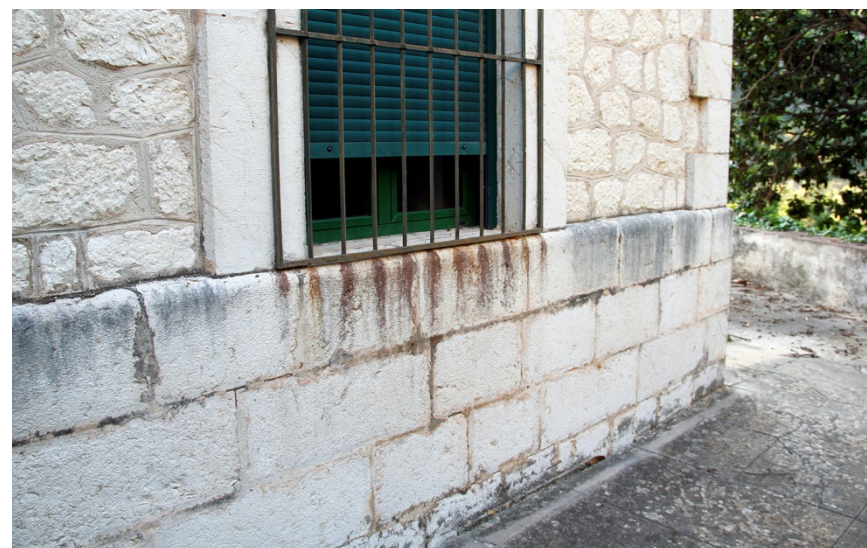
Img. 242: Lesiones por escorrentía, manchas y agentes bióticos. Muro orientación este.
