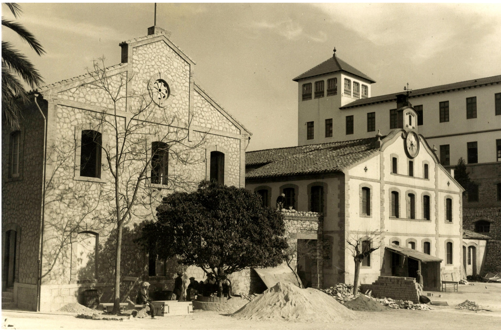
Img. 46: Pabellón central y Pabellón de La Purísima. Reforma integral década 1940. Sustitución sistema estructural y unificación de fachadas. 151
