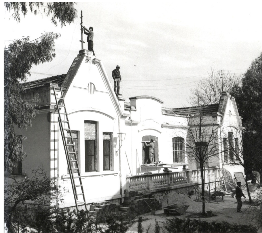
Img. 146: Clínica-Laboratorio. Pabellón de Voluntarios. Reforma integral interior década 1940. 426
