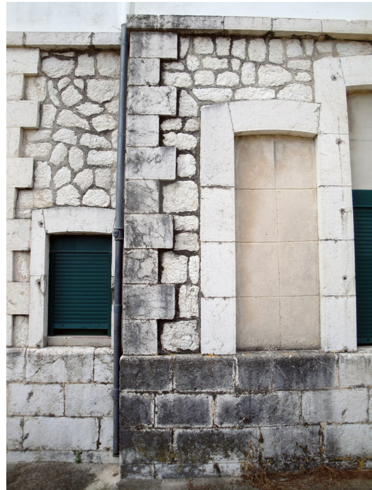
Img. 228: Cerramientos planta baja. Mampostería y Sillería. Estado actual.
