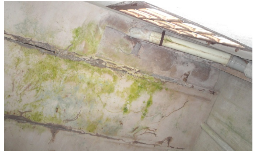
Img. 118: Forjado Hormigón Armado. Estado actual. 2014
