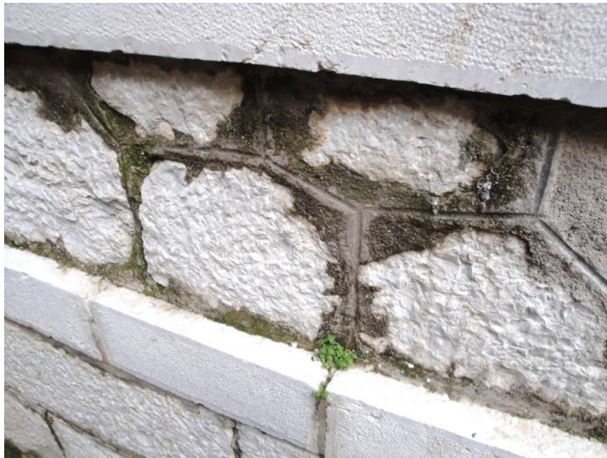
Img. 303: Ataque por agentes bióticos en juntas. Zona bajo alfeizar de ventana. Orientación Oeste
