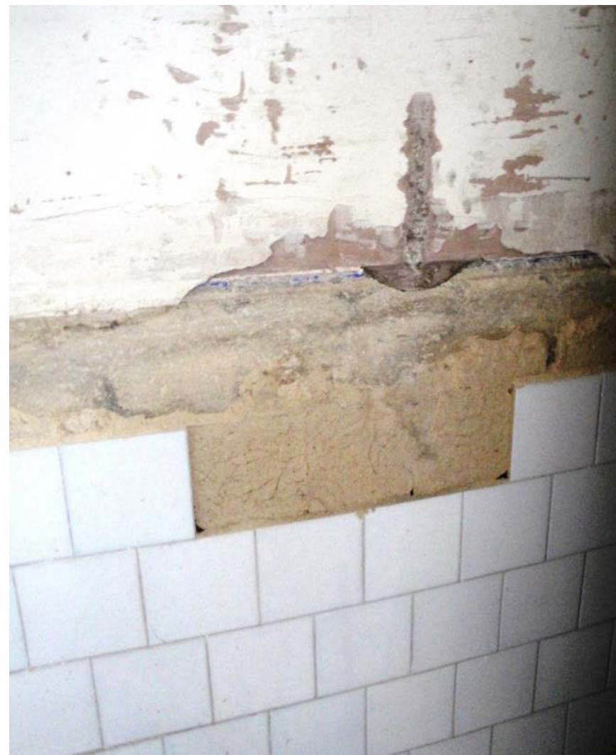
Img. 271: Cata revestimientos interiores. Zona inferior enfoscado de mortero maestreado para colocación de azulejo vidriado 15x15cm. Zona superior enlucido de yeso pintado.
