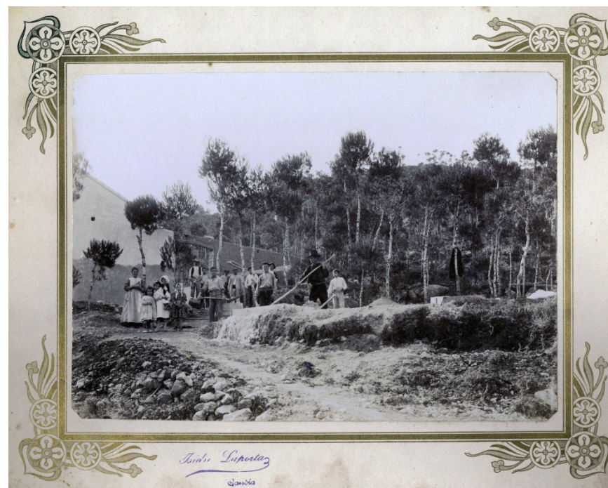
Img. 57: Entrada principal Casa de Labor. Trabajadores durante las obras. 187
