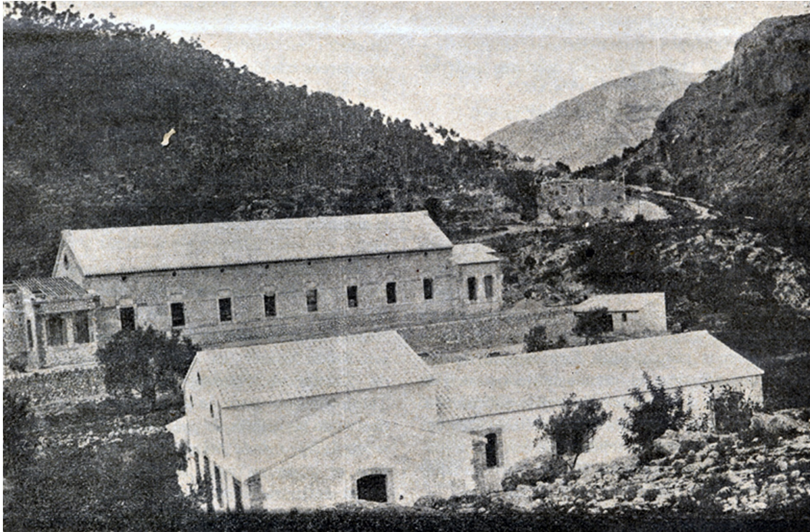
Img. 27: Vista general construcciones del Sanatorio. Pabellón Virgen de los Desamparados durante la ejecución de las cubiertas. Segundo semestre del año 1906. 107
