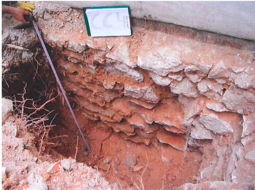
Img. 356: Calicata de cimentación corrida bajo muro CC4, Pabellón Central.
