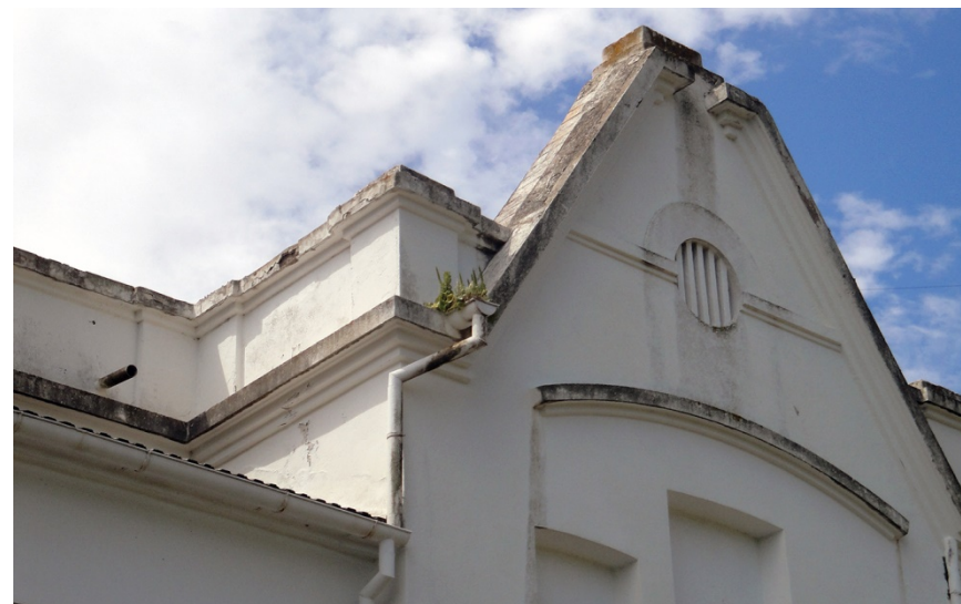
Img. 241: Lesiones por escorrentía y agentes bióticos. Muro orientación norte.
