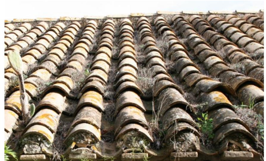
Img. 291: Falta de mantenimiento. Presencia de suciedad y agentes bióticos en los ríos.
