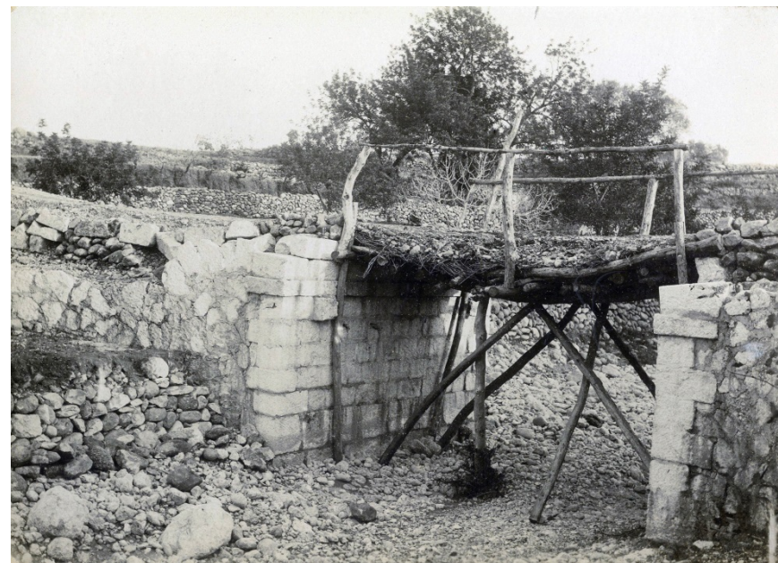
Img. 24: Ejecución de un puente en la carretera de Fontillos. Fotógrafo Isidro Laporta. 94
