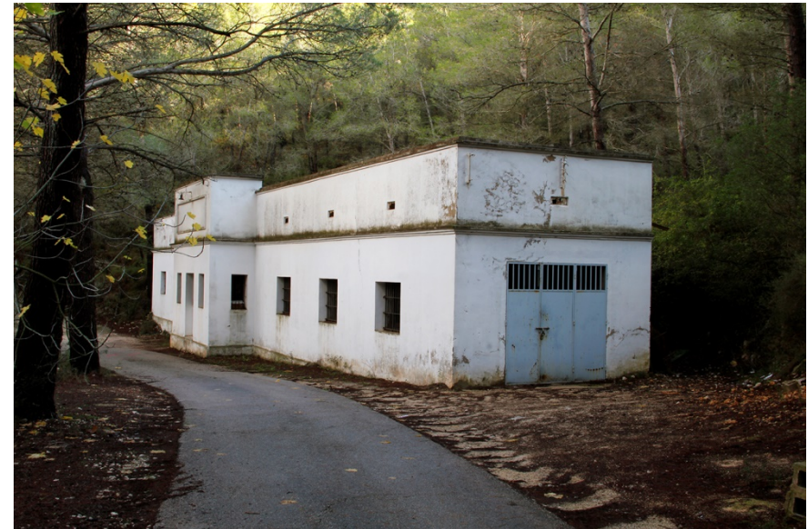
Img. 172: Vista exterior de la Penitenciaría y su entorno. Estado actual.
