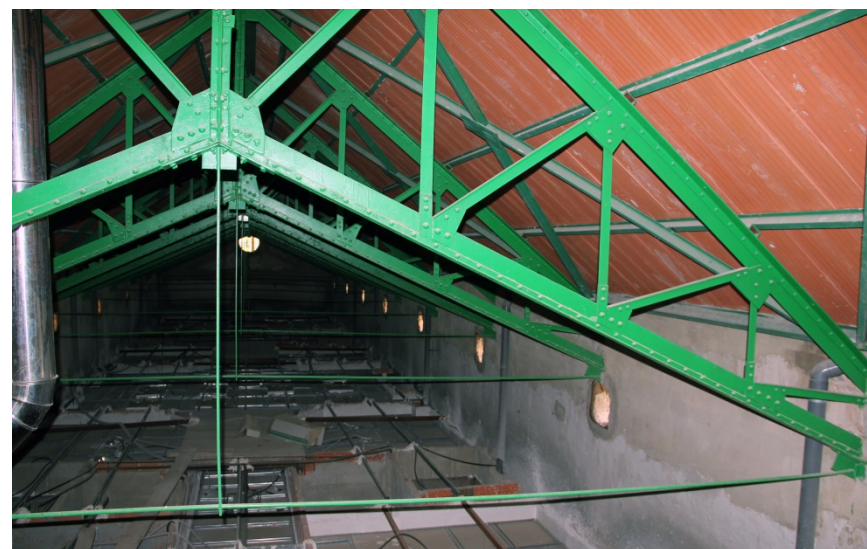
Img. 193 : Estructura metálica y sistema constructivo cubierta. Estado actual.
