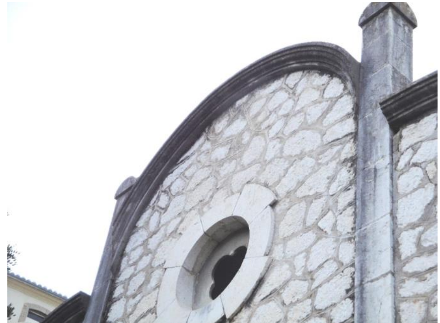
Img. 281: Moldura de directriz curva, pináculos y óculo de la fachada principal.
