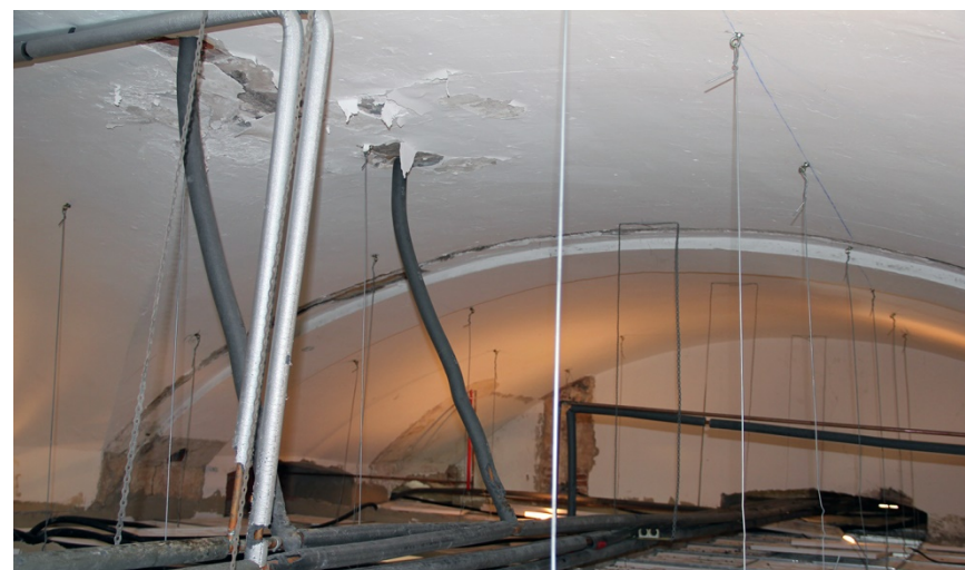
Img. 231: Estructura horizontal de bóveda tabicada. Estado actual.
