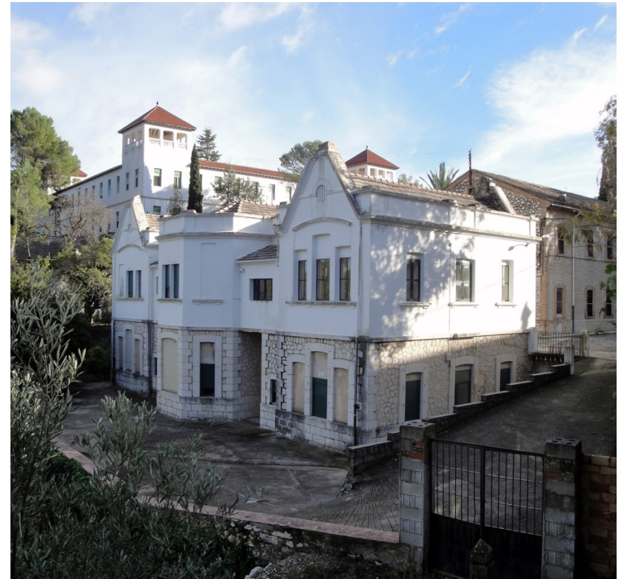
Img. 145: Clínica-Laboratorio. Pabellón de Voluntarios. Estado actual.
