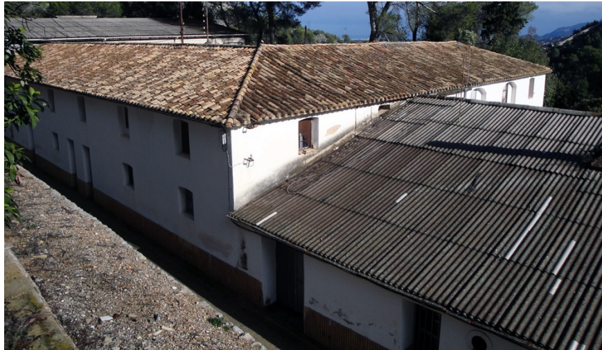
Img. 60: Estado actual Pabellón de Servicios, Casa de Labor, actuales Garajes y Talleres.
