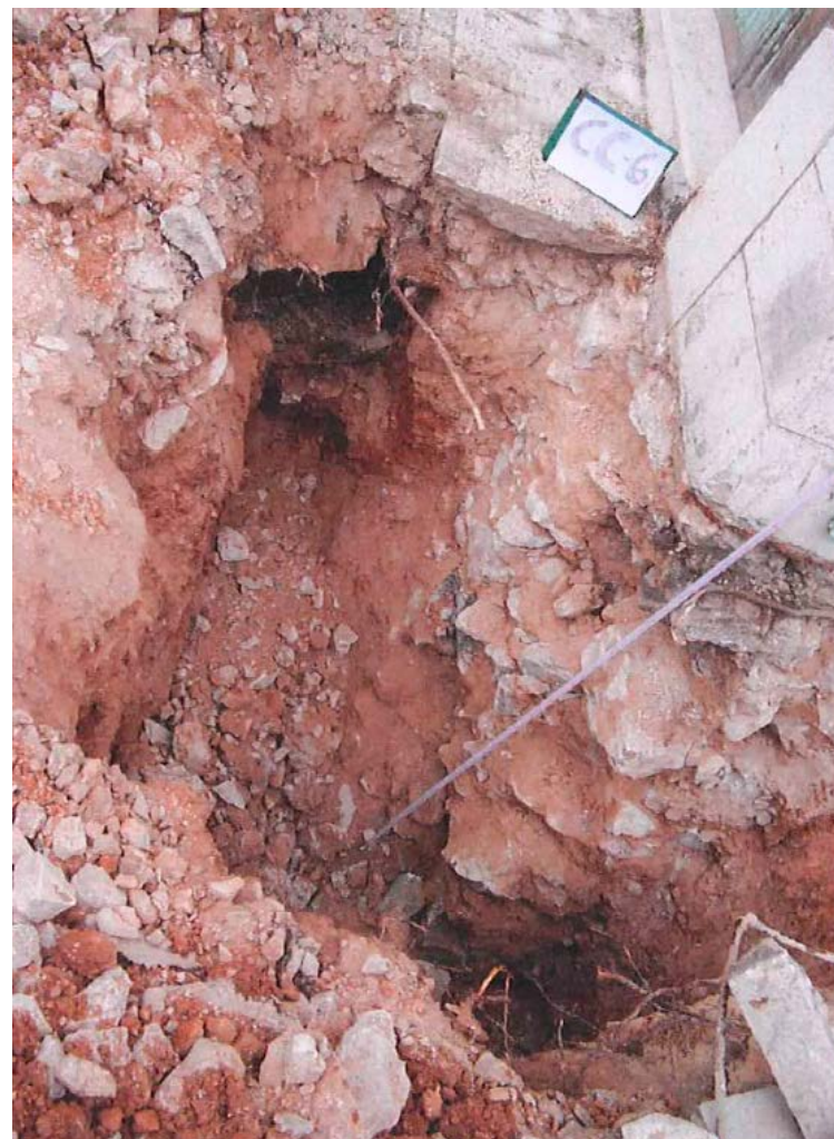
Img. 358: Calicata de cimentación CC6. Esquina Sureste Enfermería de Mujeres.
