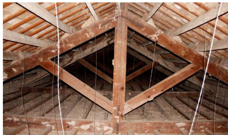
Img. 265: Estado actual cubierta a dos aguas. Cercha de madera.
