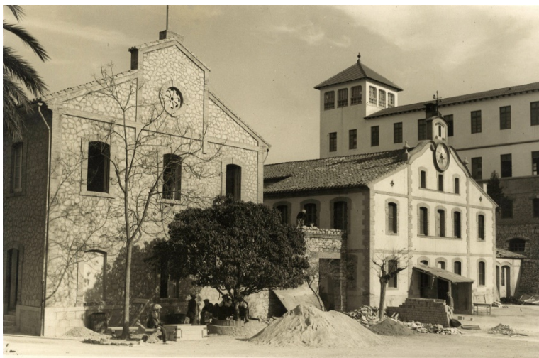
Img. 124: Reforma integral Pabellón Central y Pabellón de La Purísima. Ejecución núcleo escalera y unificación fachadas principales. Década 1940. 383
