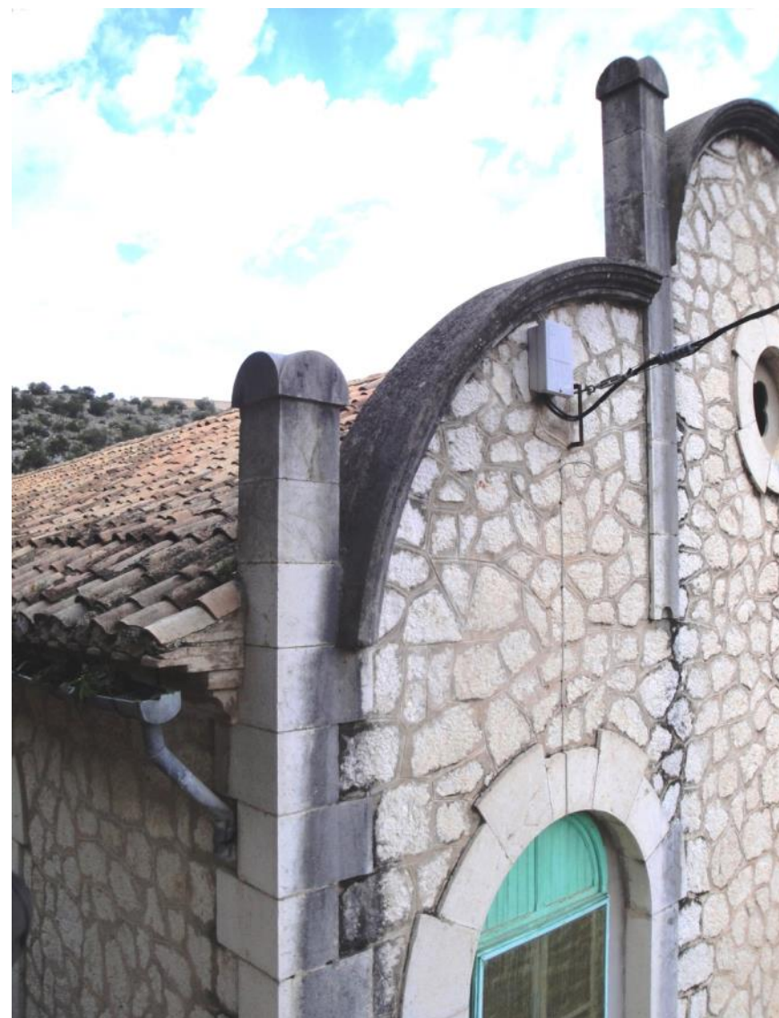
Img. 283: Moldura curva, pináculo, encuentro con alero.
