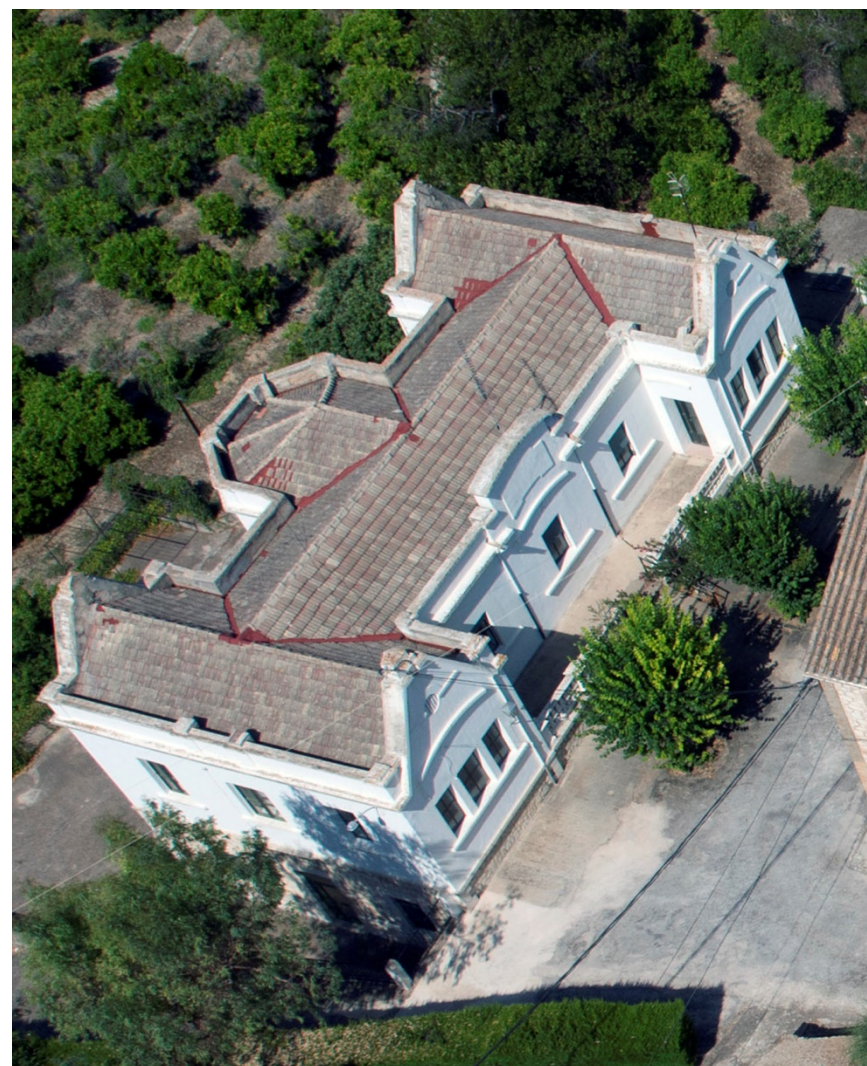
Img. 239: Vista aérea de la Clínica. Cubierta original (huella de teja plana esmaltada). Fotografía aérea mediante UAV (Unmanned Aerial Vehicle). Julio 2015.
