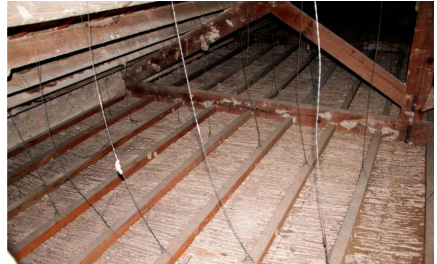
Img. 272: Intradós falso techo de cañizo y yeso. Subestructura de madera y tirantes.
