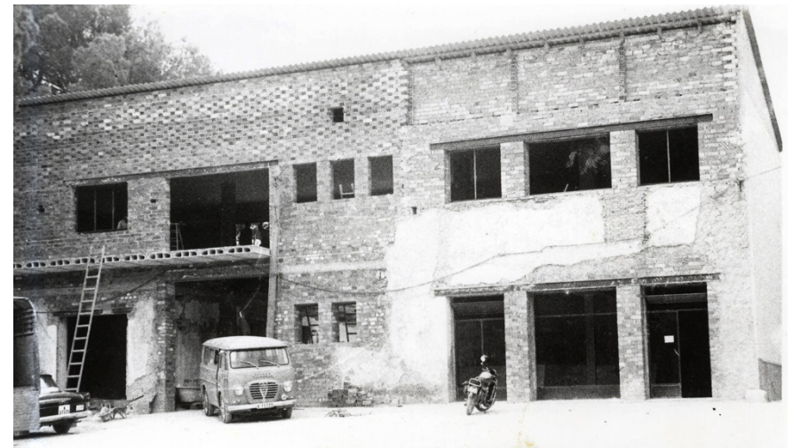
Img. 62: Ejecución fase 3. Pabellón de Servicios. Casa de Labranza. Año 1963. 194
