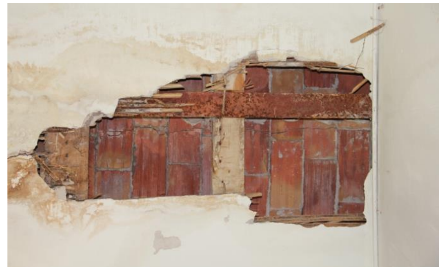
Img. 270: Cata sobre falso techo de cañizo del volumen añadido. Estructura metálica.
