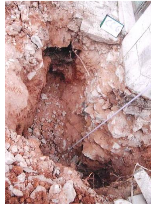
Img. 264: Cata cimentación CC-6. Esquina Sureste. Enfermería de Mujeres. SEG. S.A. 2007.
