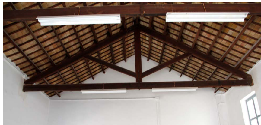
Img. 325: Estructura de cubierta de la Lavandería-Ropería-Costurero. Estado actual.
