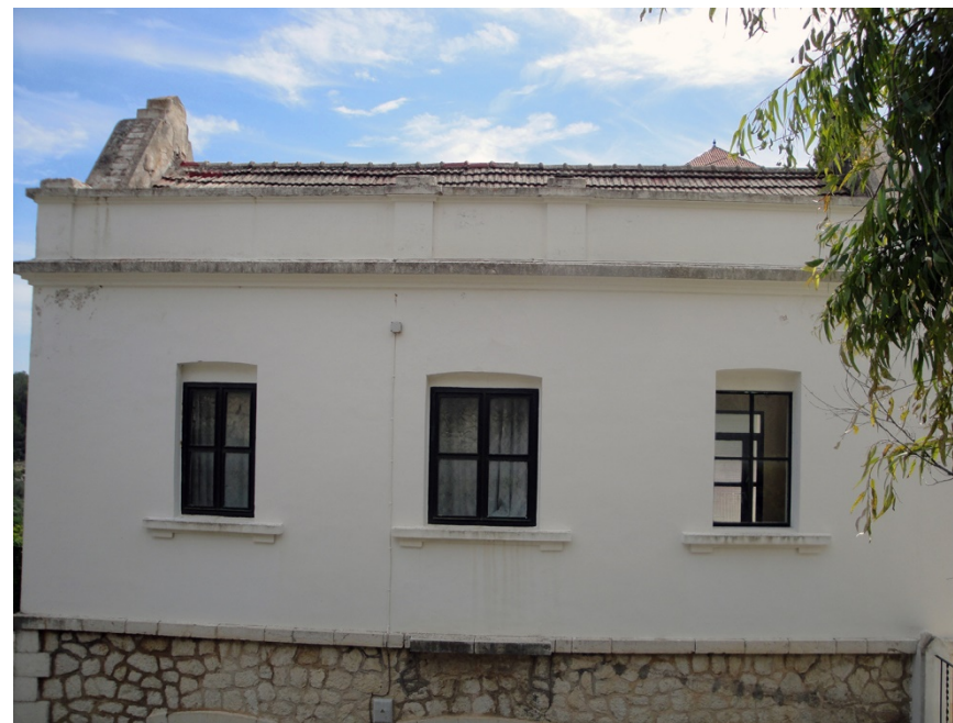
Img. 229: Muro de mampostería revestida. Planta superior. Fachada Oeste. Estado actual.
