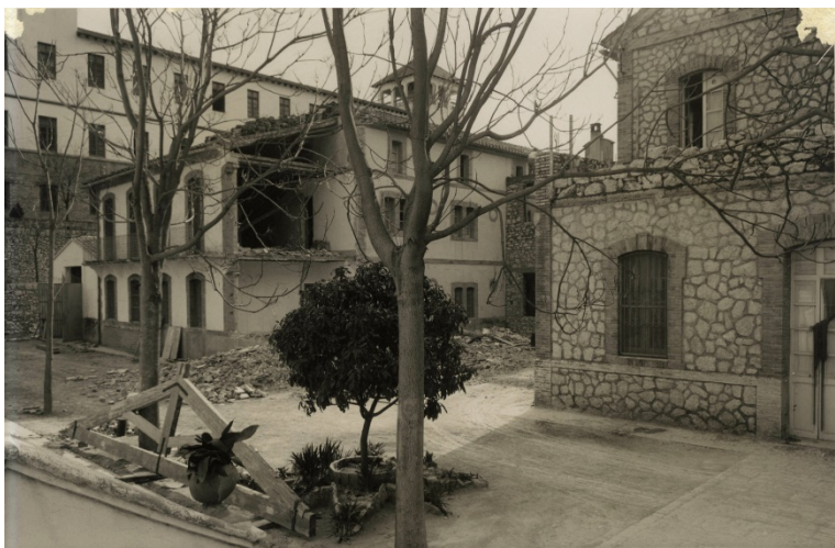
Img. 125: Modificaciones volumétricas edificaciones. Sobreelevación terraza. 384
