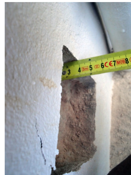
Img. 342: Espesor medio de revestimiento.
