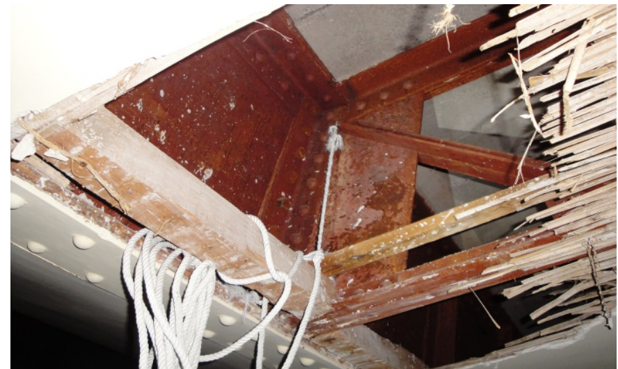
Img. 119: Estructura Metálica. Estado actual. 2014
