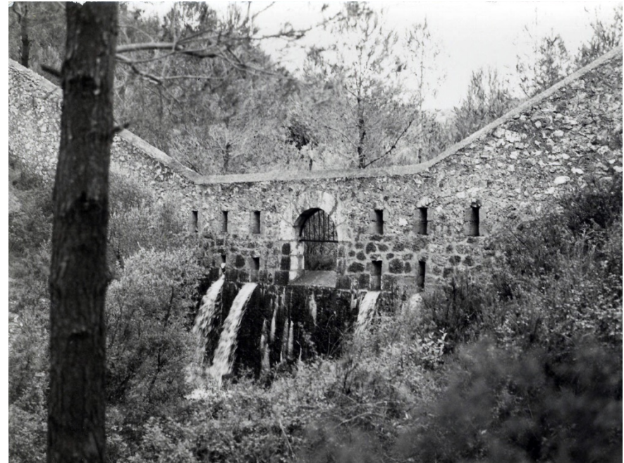
Img. 149: Tramo de Muralla con paso de rambla de agua. En la actualidad está en ruina. 430
