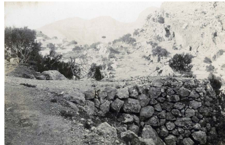
Img. 20: Ejecución de un terraplén de carretera de Fontilles. Fotógrafo Isidro Laporta. 73
