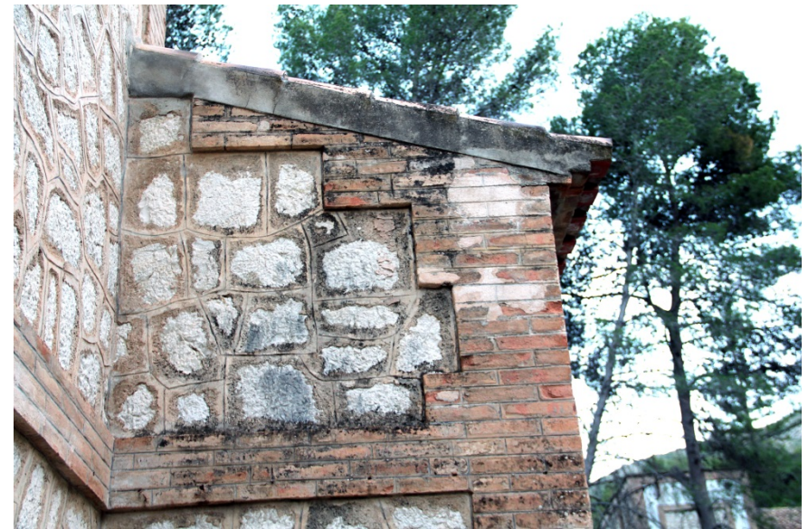
Img. 206: Lesiones por escorrentía y agentes bióticos. Muro orientación norte.
