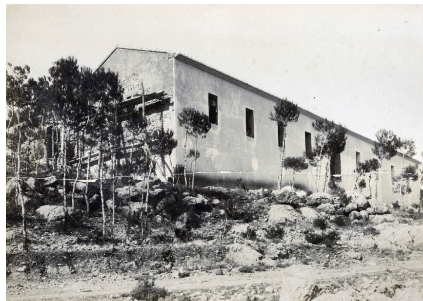
Img. 54: Casa de Labranza. Ejecución de revestimientos. Año 1908. 178
