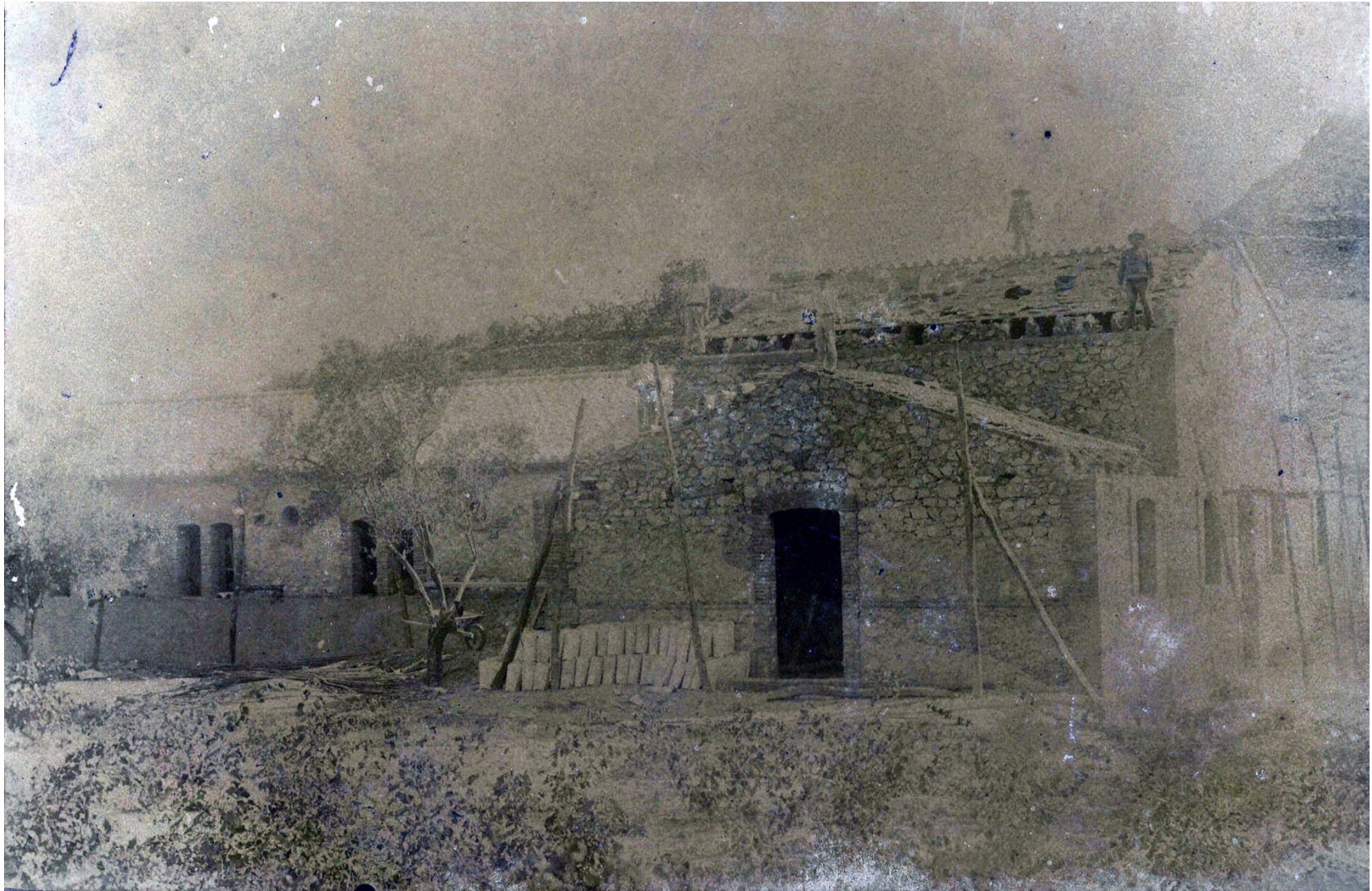
Img. 36: Proceso de construcción del Pabellón de La Purísima. Ejecución de la cubierta. Fotógrafo de Valencia, Leopoldo Simó. Año 1906. 133
