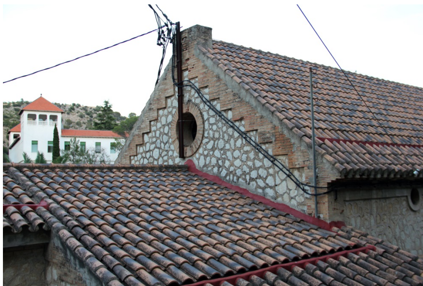
Img. 203: Remate superior muro hastial norte. Estado actual.
