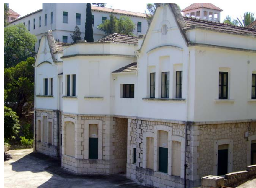
Img. 227: Estado actual de la Clínica-Laboratorio.
