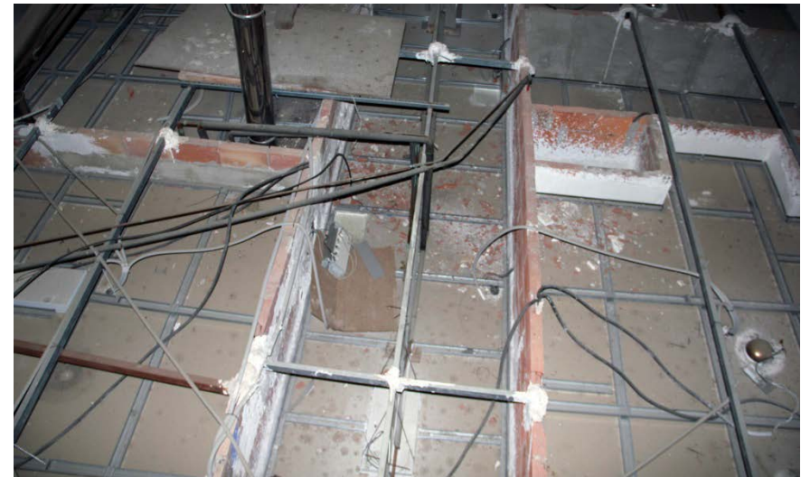
Img. 199: Tabiquería cerámica LH7 y falso techo de yeso laminado.
