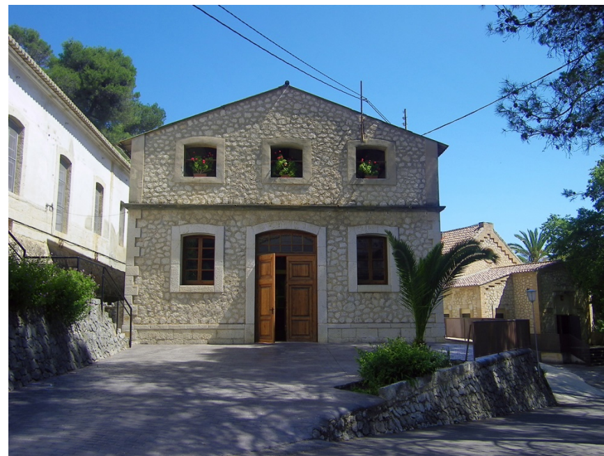
Img. 171: Fachada principal del Pabellón de Desinfección. Actual Aula de Formación.
