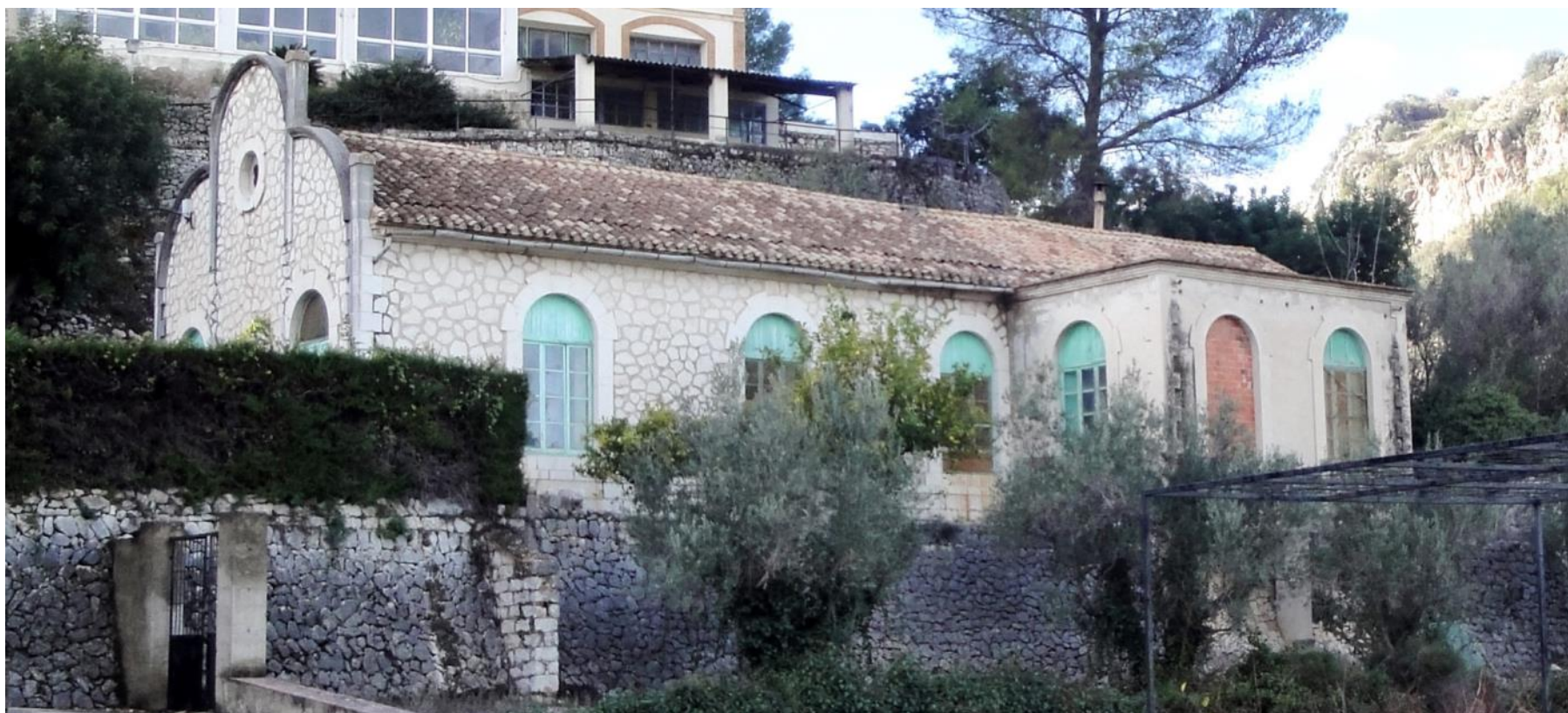
Img. 258: Vista general de Enfermería de Mujeres. Estado actual.
