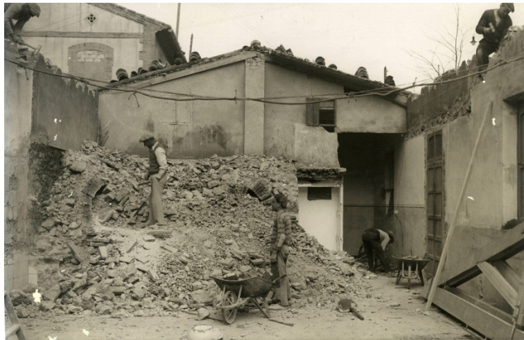
Img. 131: Demolición Horno del Pabellón de La Purísima. Zona cocinas. 390
