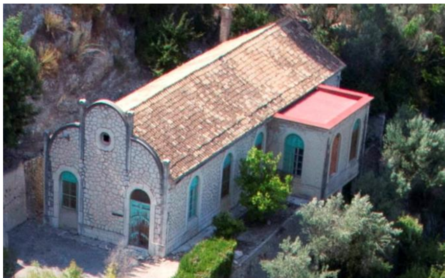
Img. 244: Pabellón de Enfermería de Mujeres - Pabellón de Rehabilitación. Fotografía aérea mediante UAV (Unmanned Aerial Vehicle). Julio 2015.
