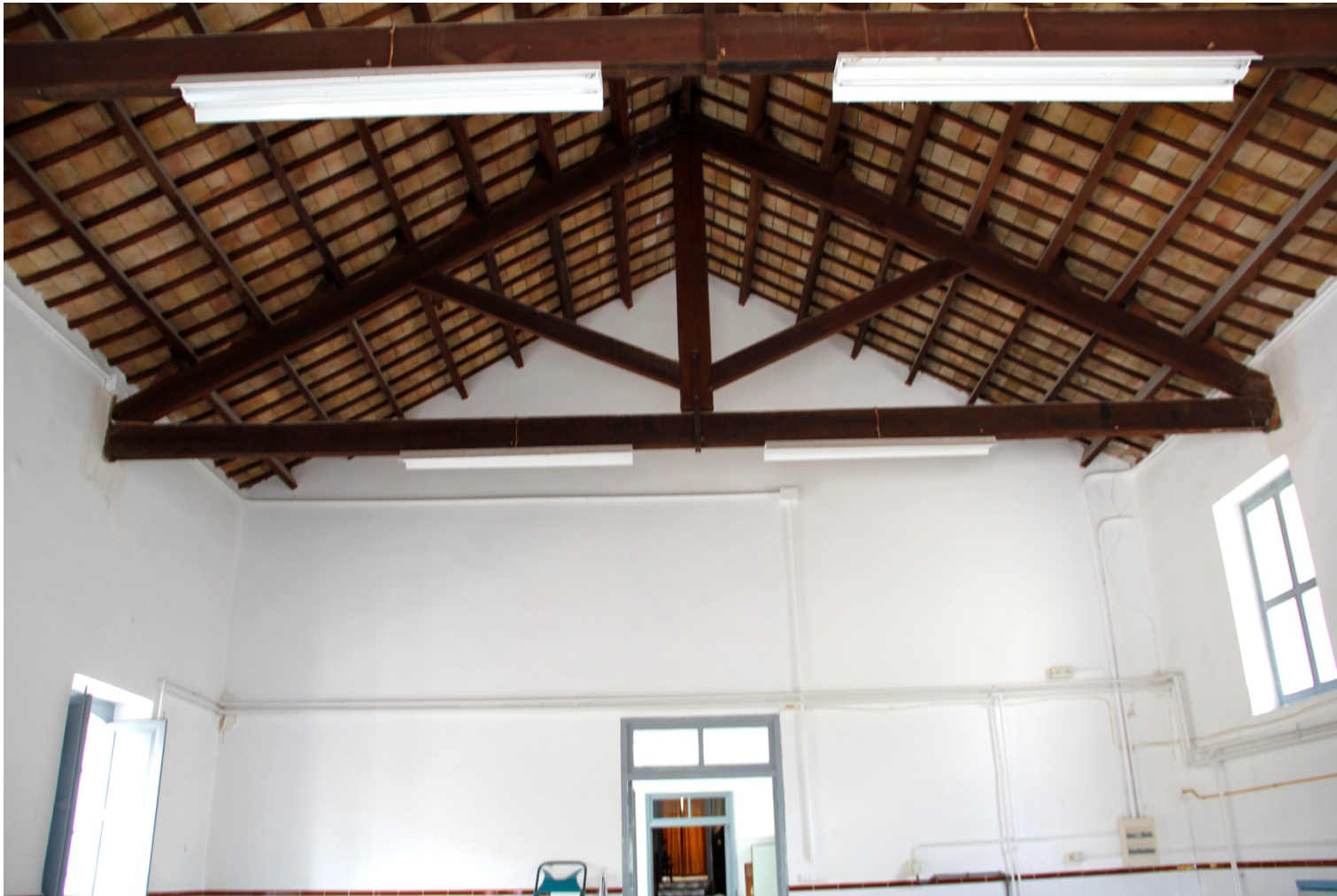
Img. 163: Estado actual de la Lavandería-Ropería-Costurero. Estructura de cubierta.
