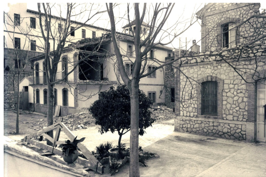
Img. 45. Demolición zona trasera del Pabellón de La Purísima. Década 1940. 150
