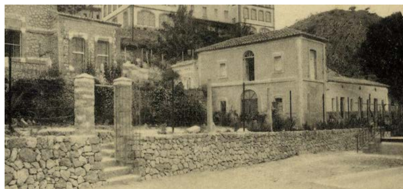
Img. 87: Vista general de Fontilles, principios década 1920. Viviendas de enfermos (derecha). 274
