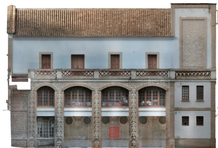
Img. 334: Pabellón de Baños. Fachada Sur. Toma de muestras M1 y M2.
