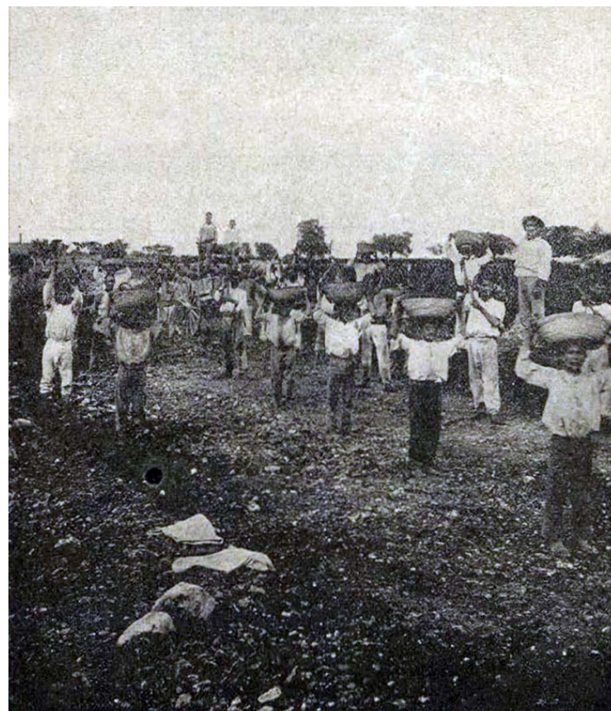
Img. 21: Brigada de trabajadores construyendo la carretera de Fontilles. 1902-1904. 79
