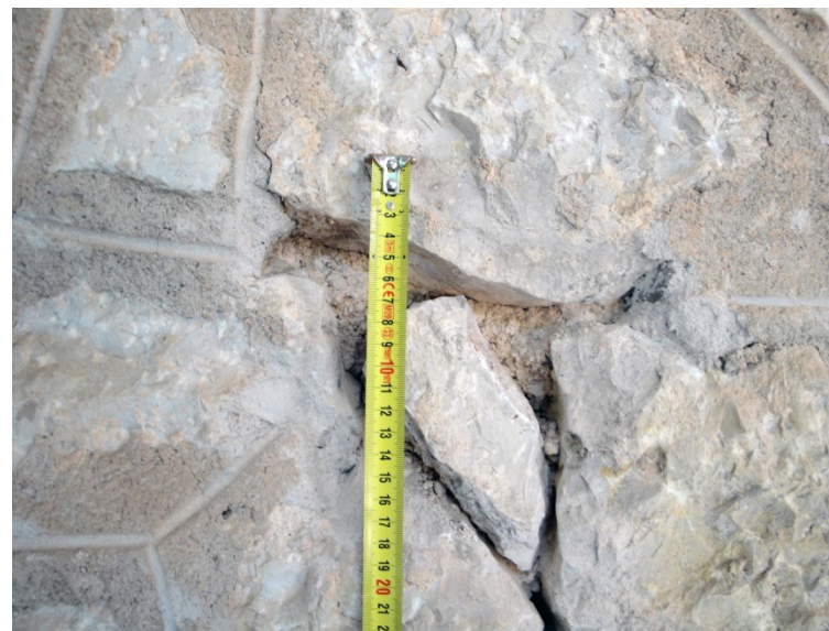
Img. 331: Toma de muestras M1 y M2. Pabellón de Baños, año 1913.
