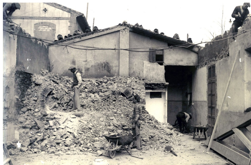
Img. 47: Demolición del Horno de Pan, en el edificio anexo del Pabellón de La Purísima. 1935-1946. 152
