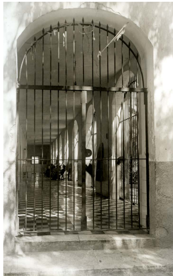
Img. 75: Porche de planta baja. Pabellón de San Rafael. 235
