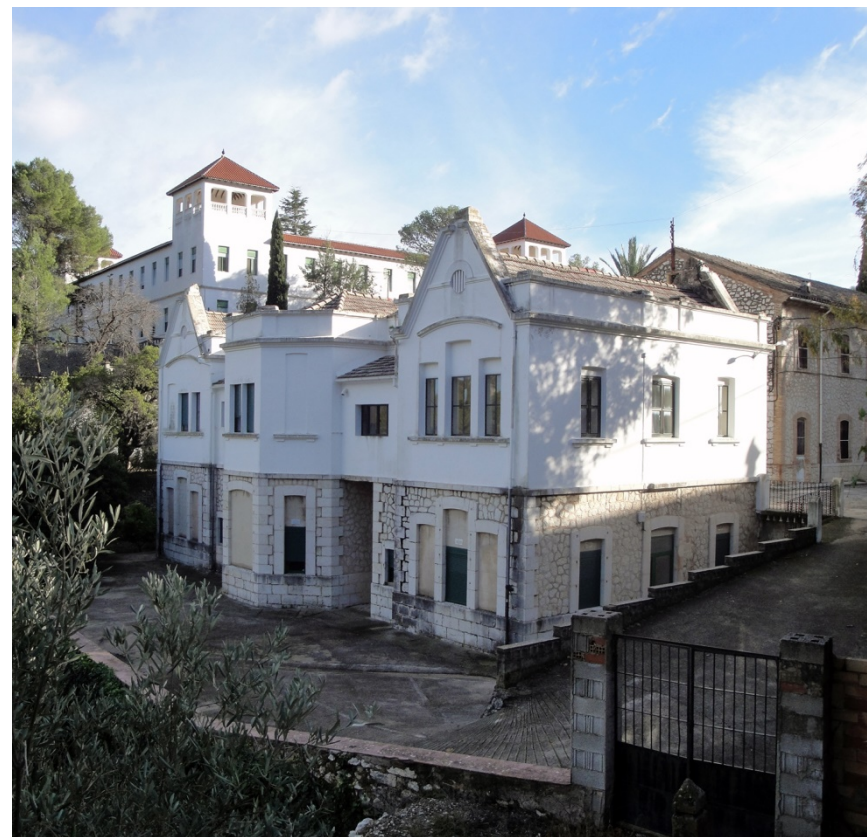
Img. 214: Clínica-Laboratorio. Pabellón de Voluntarios. Estado actual.
