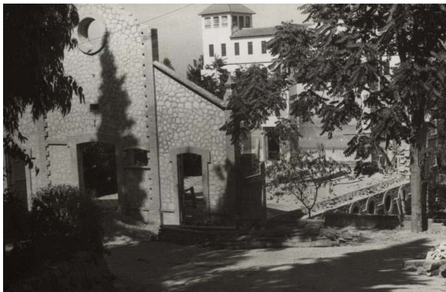
Img. 113: Proceso ejecución Teatro. Estructuras Fase 3. Año 1958.
