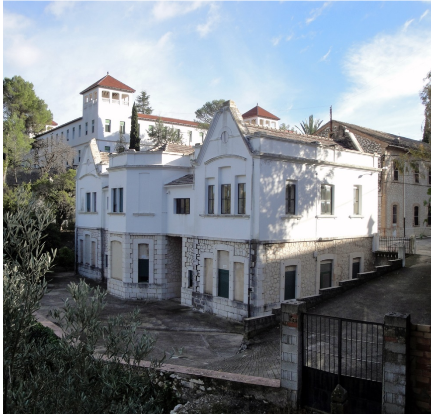
Img. 213: Clínica-Laboratorio. Pabellón de Voluntarios. Estado actual.
