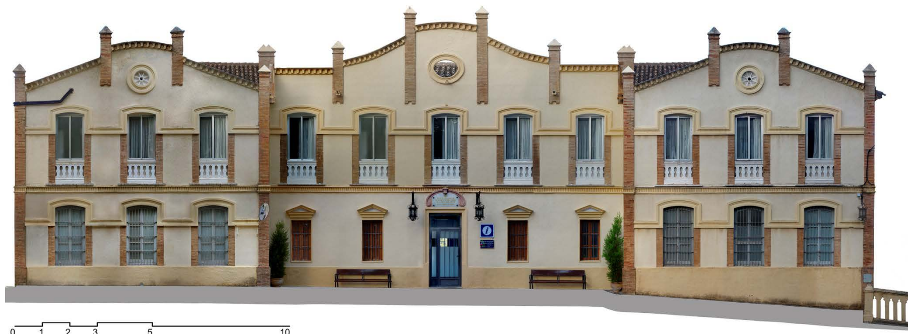
Fig. 31: Fotoplano fachada principal del Pabellón de Administración, Hospedería, Casa de ejercicios. Orientación oeste. Estado actual.
