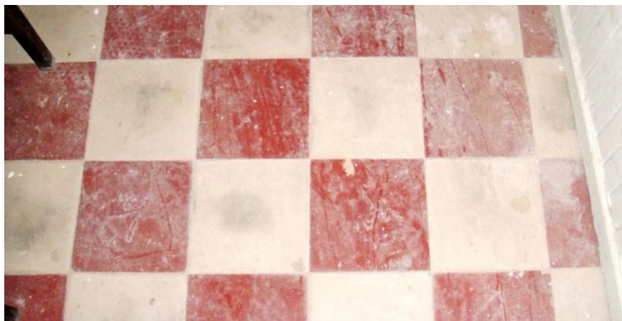
Img. 277: Pavimento hidráulico existente.
