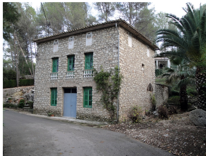
Img. 157: Casa del Practicante. Estado actual.
