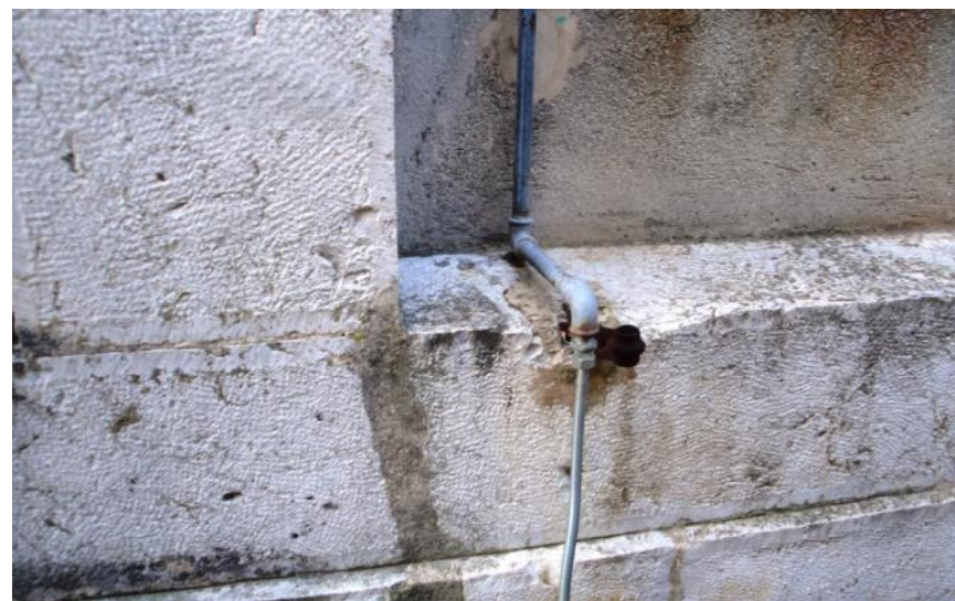
Img. 307: Instalación de fontanería exterior.
