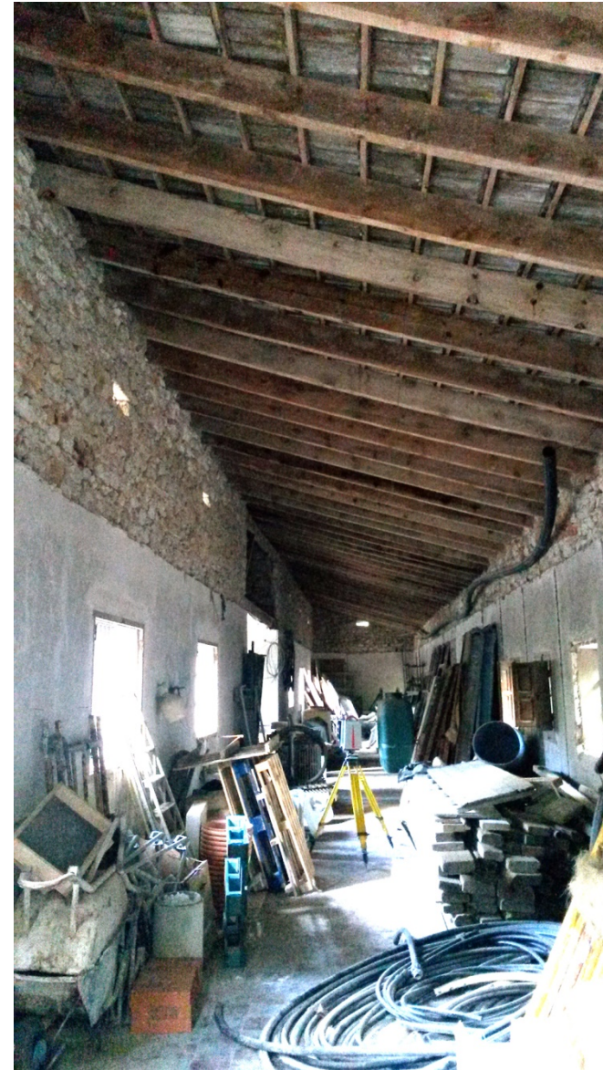
Img. 173: Penitenciaría. Interior. Estado actual.
