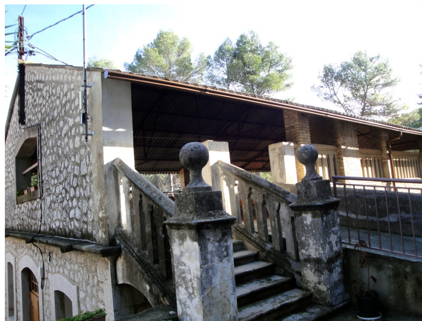
Img. 170: Pabellón de Desinfección. Estructura de cubierta. Estado actual.
