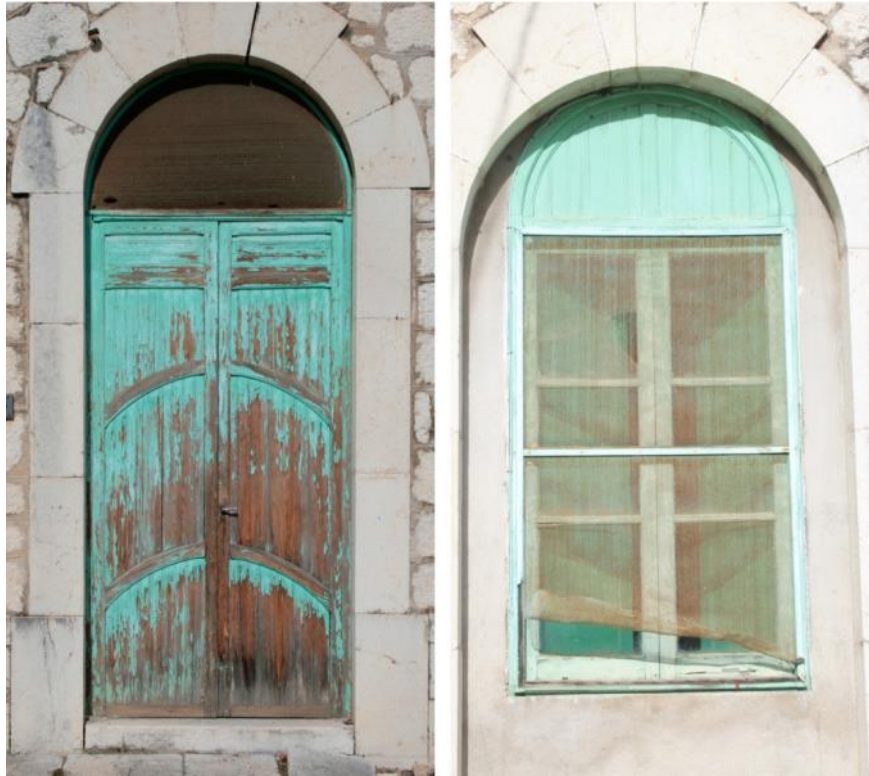
Img. 275: Puerta de acceso principal y ventana tipo. Estado actual.
