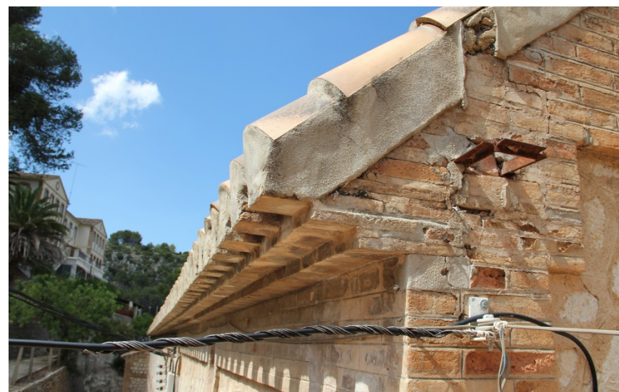
Img. 194 : Alero cerámico de rasilla. Ladrillo de fabricación propia.
