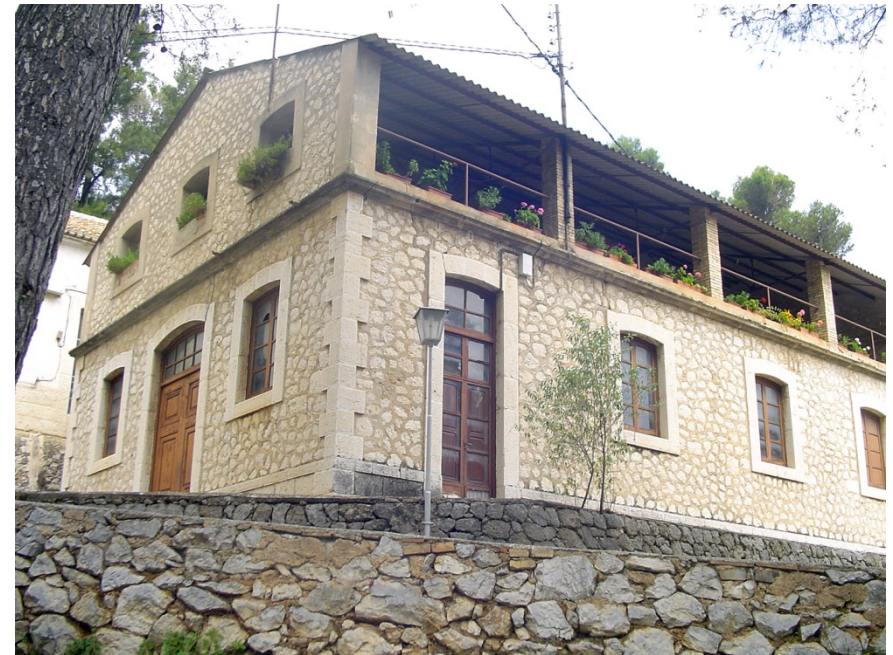
Img. 167: Pabellón de Desinfección. Actual Aula de Formación de Fontilles. Estado actual.
