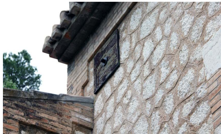
Img. 204: Placa y tensor metálico. Tirante estructural. Estado actual.
