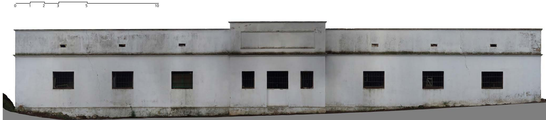
Fig. 104: Fotoplano de la Penitenciaría. Fachada Oeste. Estado actual.
