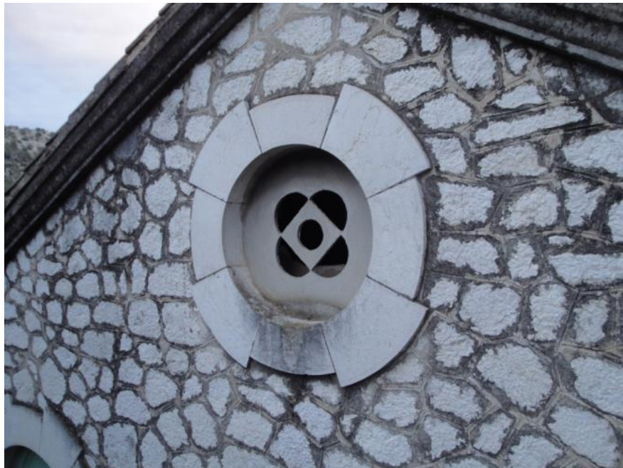
Img. 280: Óculo con recercado de sillería y moldura lobulada.
