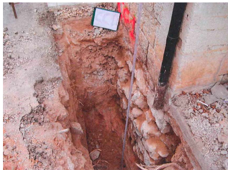
Img. 318: Cata de cimentación CC1. Pabellón Central-Laboratorios. Esquina suroeste.
