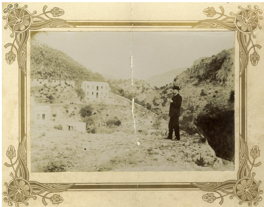
Img. 55: Vista general del Sanatorio de Fontilles. Ejecución Casa de Labor. Año 1907. 180
