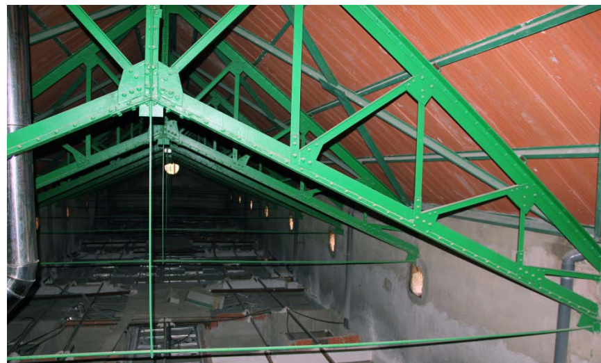
Img. 324: Estructura metálica y sistema constructivo cubierta. Estado actual Pabellón Virgen de los Desamparados de enfermos.
