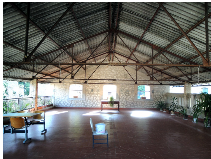
Img. 168: Pabellón de Desinfección. Estructura de cubierta. Estado actual.
