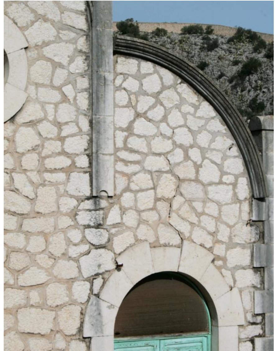
Img. 299: Manchas y lavado por arrastre de partículas. Orientación sur.
