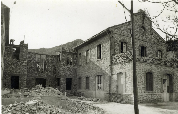
Img. 130: Ejecución nuevo núcleo escalera y estancias para la enfermería y laboratorios. Sobreelevación terraza en fachada posterior. Década 1940. 389
