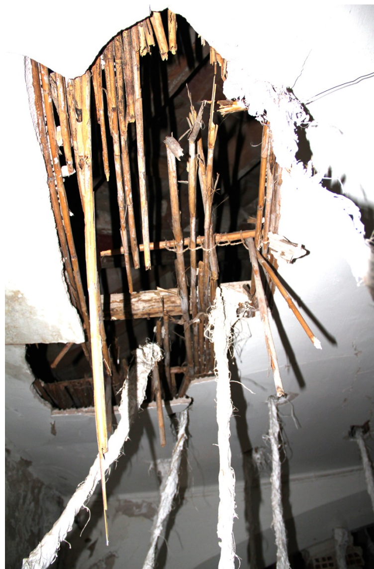
Img. 236: Falsos techos históricos de planta superior de la Clínica. Estado actual
