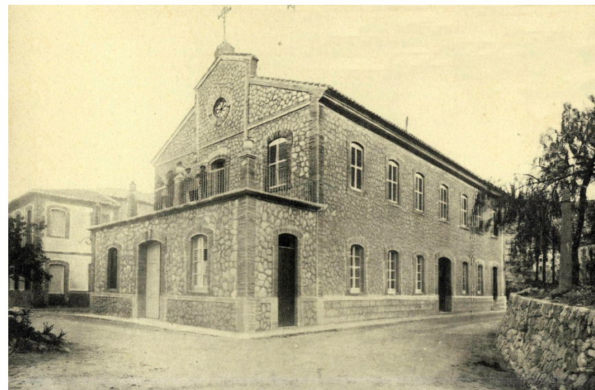
Img. 123: Pabellón Central. Comedores (planta baja), Enfermería (planta 1ª), Farmacia (añadido terraza). 378
