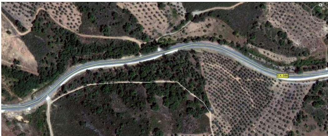
Imagen 5-5. Ubicación Ex-386 altura del ojo 1 Km (Fuente Google Earth)
