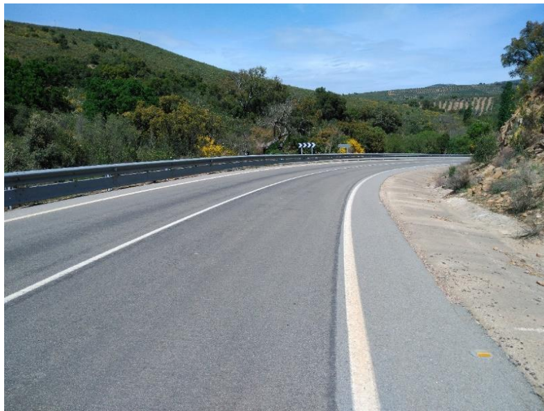
Imagen 5-9. Primer tramo curva a derecha (sentido ascendente)
