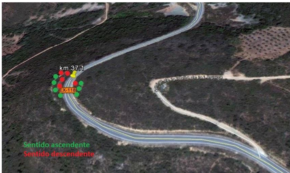
Imagen 4-13. Salidas de vía en el pk 37+100 (elaboración propia)
