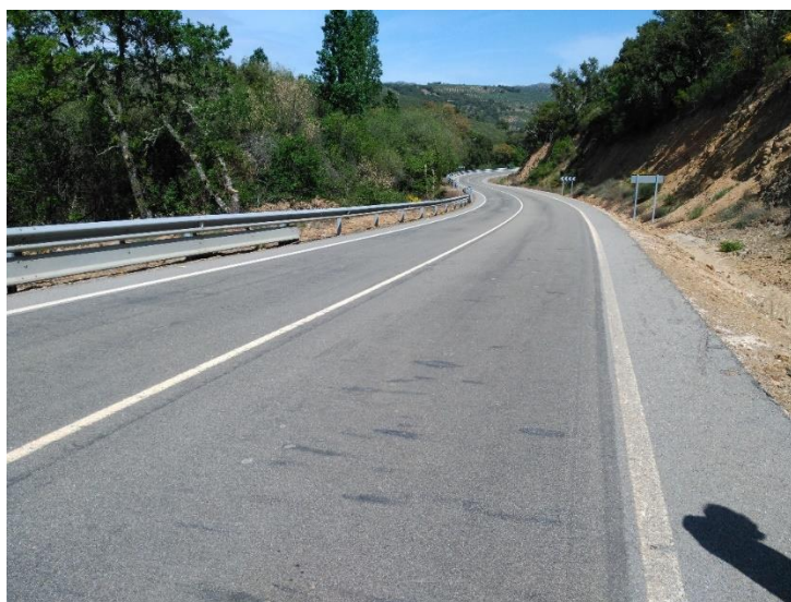
Imagen 5-10. Segundo tramo ligera curva a izquierdas (sentido ascendente)
