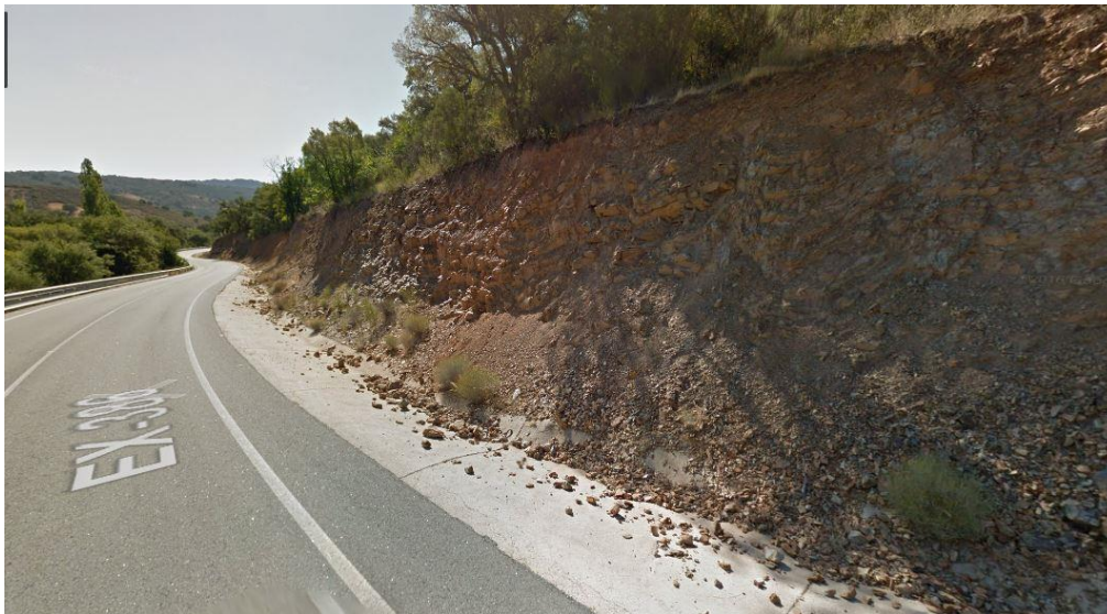
Imagen 5-12. Altura talud desmonte (Fuente Google Maps)
