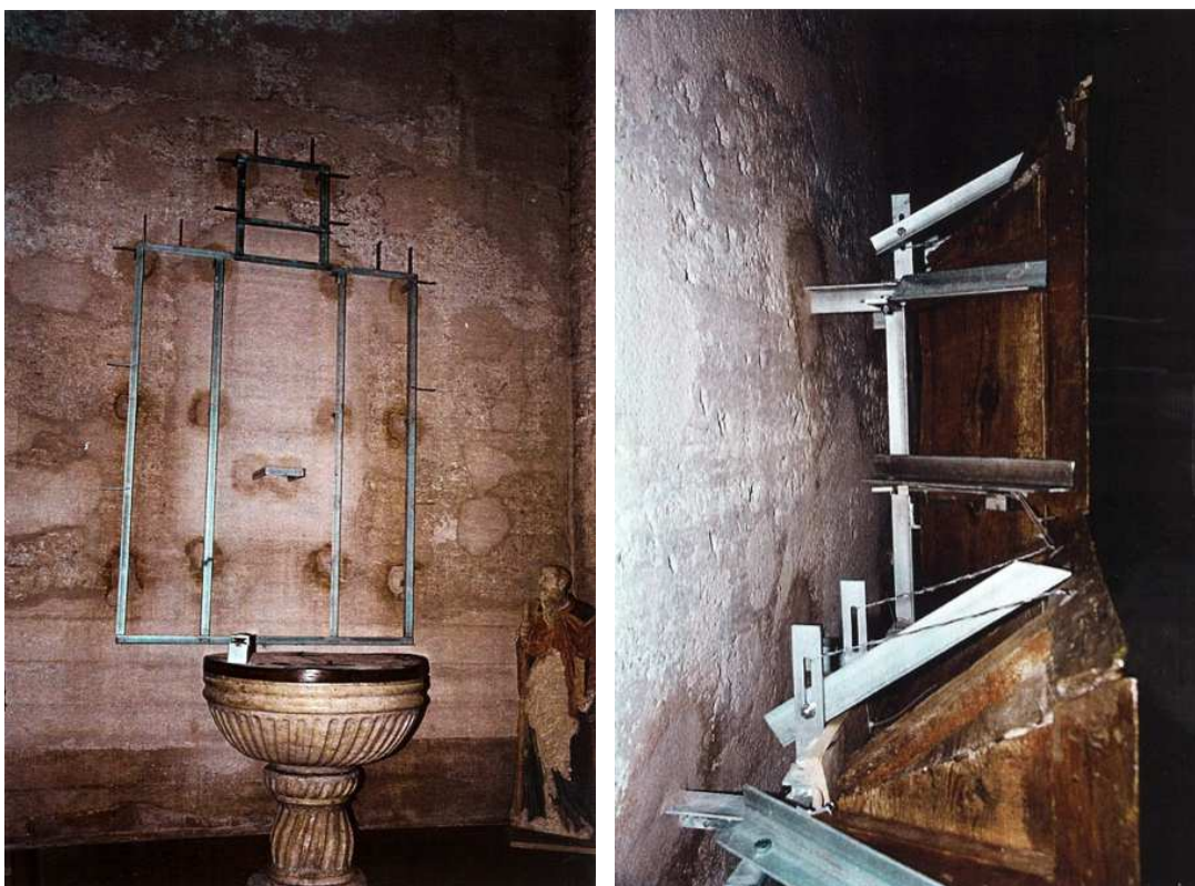
Fig.241. Bastidor de anclaje, previo al montaje del Retablo de Guerau de Castellvert.
