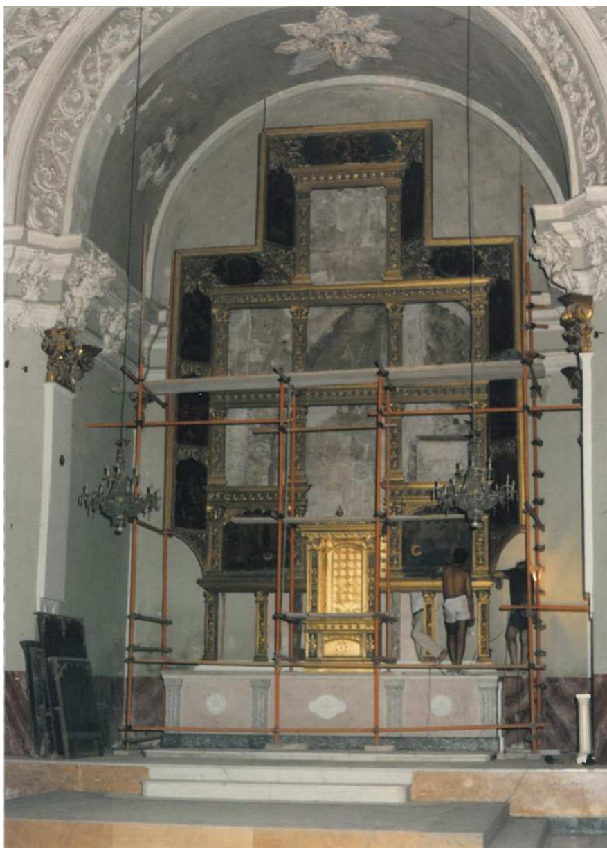
Fig.233. Proceso del desmontaje del Retablo Mayor de San Pedro y San Pablo para la intervención de restauración y rehabilitación del templo, el 3 de Julio de 1986.
