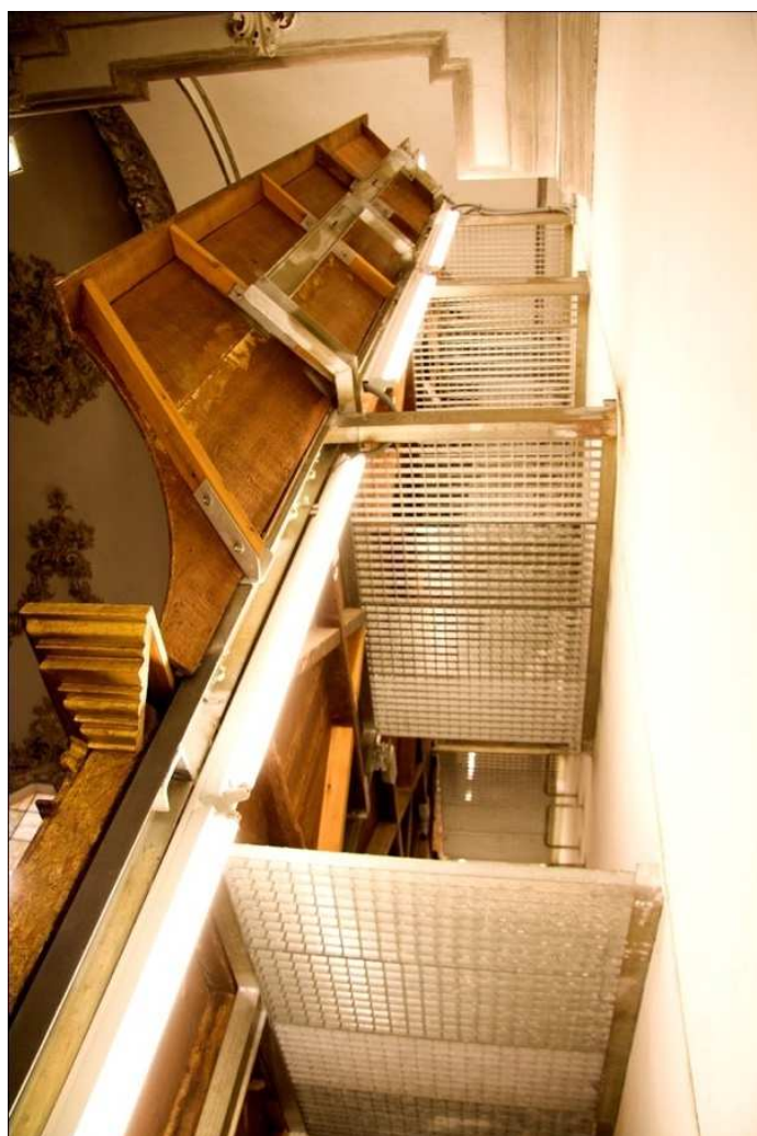
Fig.232. Vista general del anclaje del Retablo Mayor de San Pedro y San Pablo realizado durante la intervención de restauración de la obra entre 1986-95.
