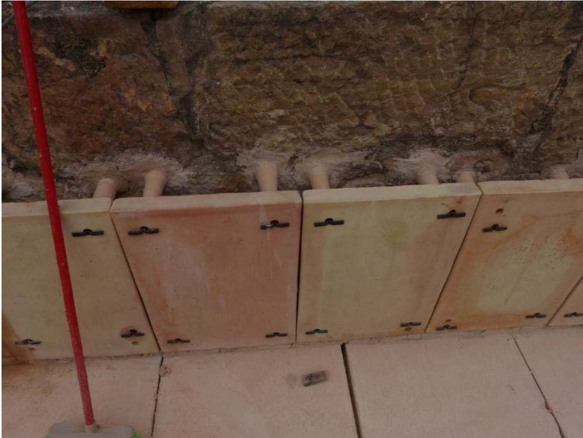
Ilustración 163. Reconstrucción de las parietales tegulae para formar la concameratio .
