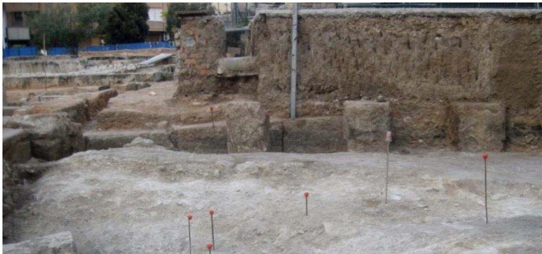
Ilustración 231. Conducción aérea. Acometida. Machones de apoyo saliendo del terraplén.
