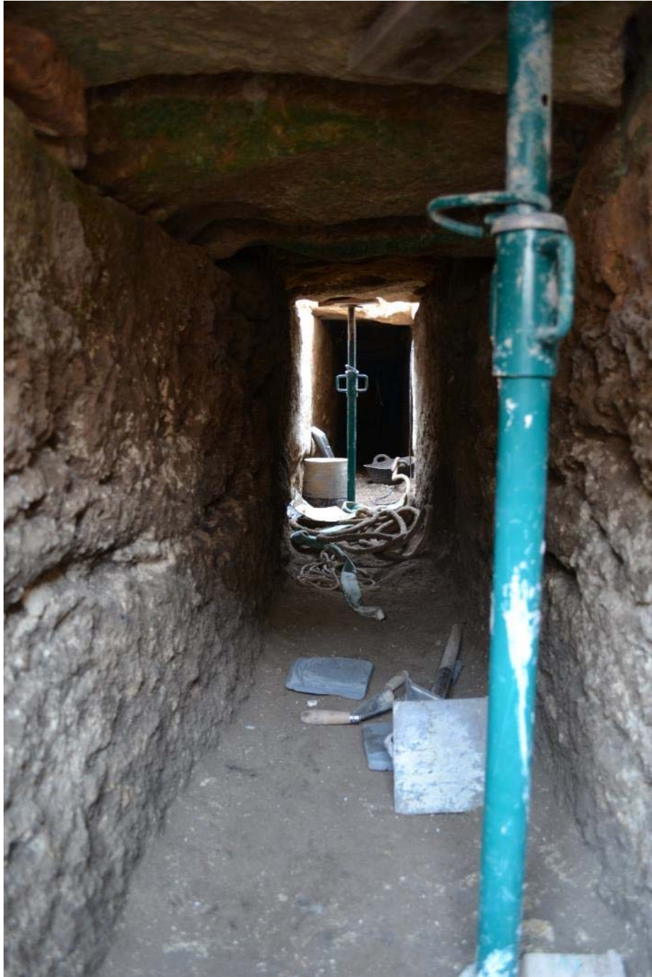
Ilustración 245. Desagüe de la piscina del frigidarium a la cloaca.
