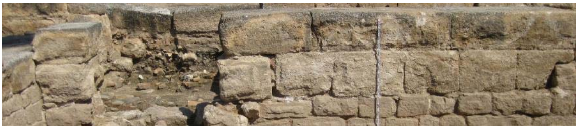
Ilustración 177. Paramento de la cella fornacarii .
