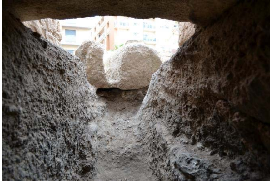
Ilustración 244. Conducción de las aguas de la sala de hornos acometiendo la cloaca.
