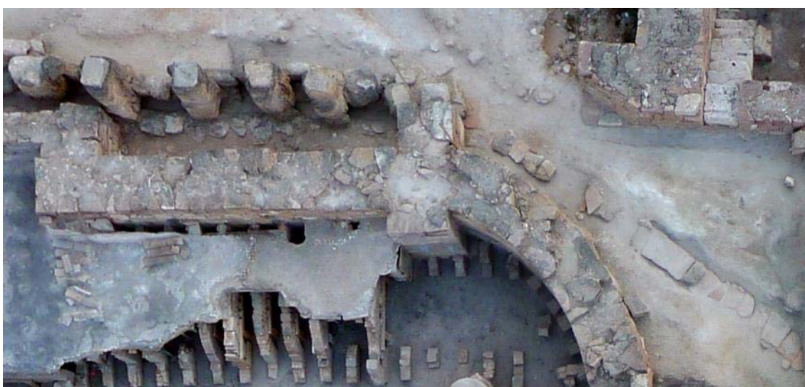
Ilustración 241. Conducto de evacuación a ras de suelo, bajo la conducción aérea de agua limpia.
