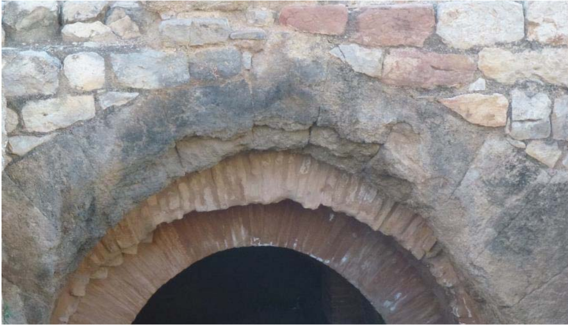
Ilustración 178. Arco de piedra del praefurnium del caldarium .
