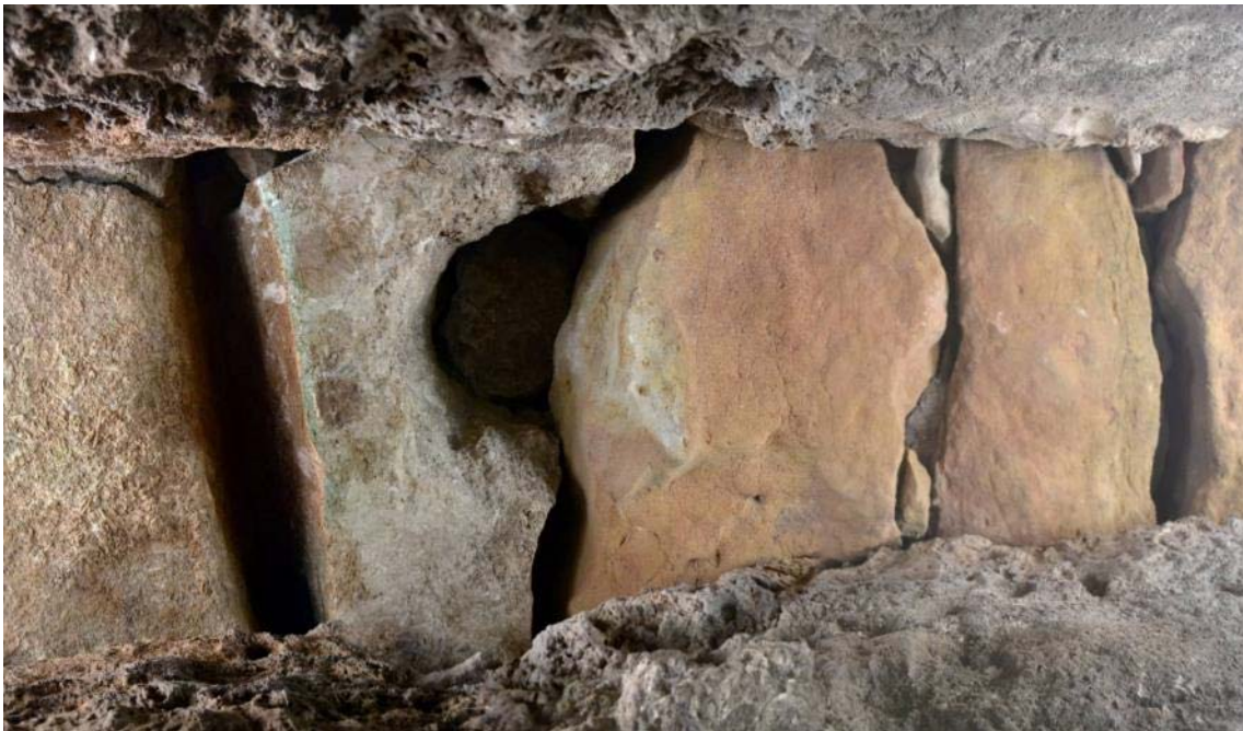
Ilustración 247. Embocadura de las letrinas con la cloaca. Vista cenital de las losas que cubren el conducto. Punto donde cambia el tipo de losas y material de la roca.
