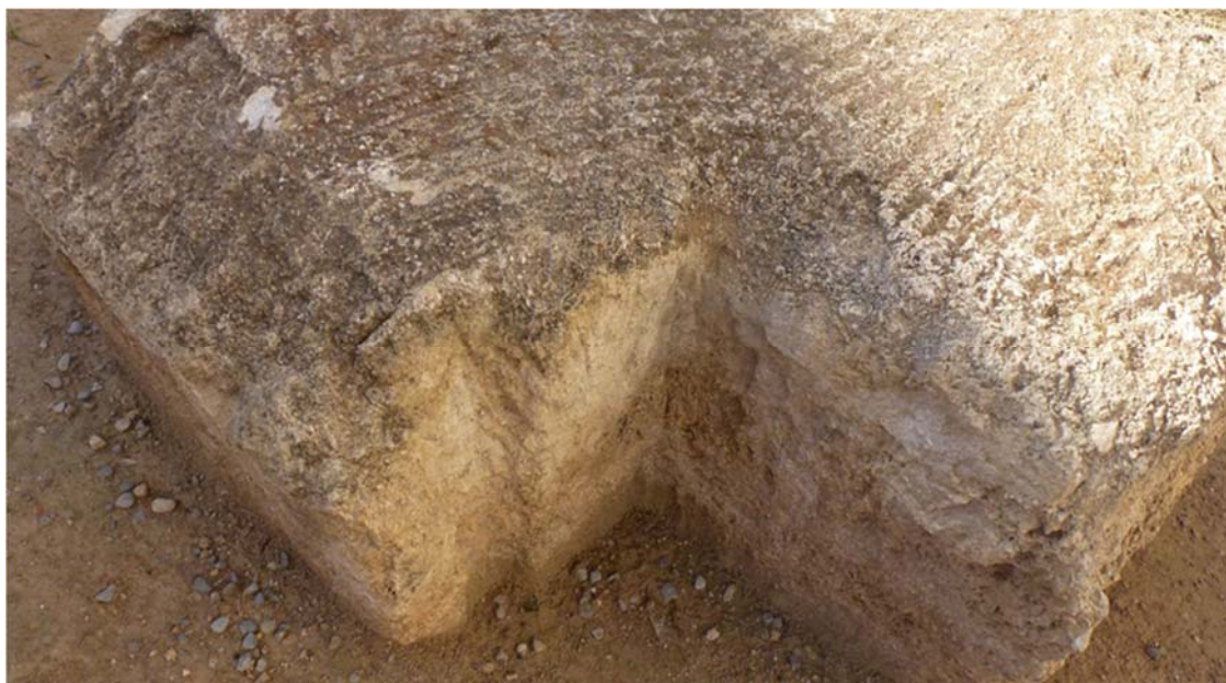
Ilustración 134. Tercera sala termal, caldarium . Detalle del rebaje existente en las piezas que forman las dovelas de la bóveda.
