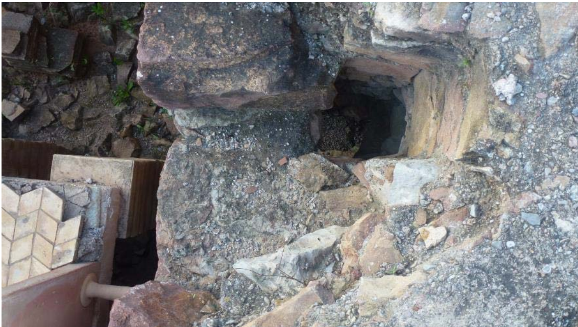
Ilustración 121. Segunda sala termal. Detalle de los conductos de circulación de aire caliente insertados en el muro.
