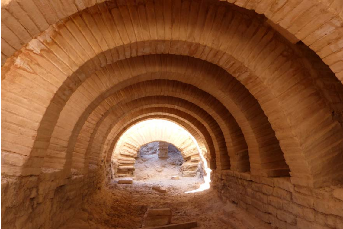
Ilustración 154. Detalle de los arcos de suspensión del caldarium confeccionada con ladrillos cunneatti .
