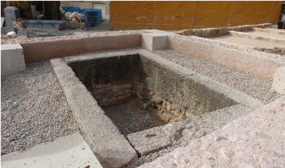
Ilustración 98. Fotografía de la cámara secreta situada en el templo del complejo del santuario oracular al finalizar las obras de la intervención en 2012.
