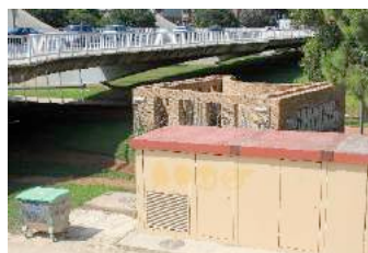
Entorno en el que se encuentra actualmente la obra de Kirkeby, donde diversos elementos han invadido el espacio de la pieza dificultando su observación.
