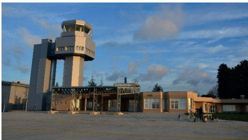
Figura 4. Torre de control y edificios auxiliares. Centro de Investigación Aeroportada de Rozas – CIAR, Castro de Rei, Lugo.
