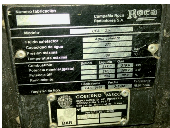
Figura 3. Placa de características caldera de gas
