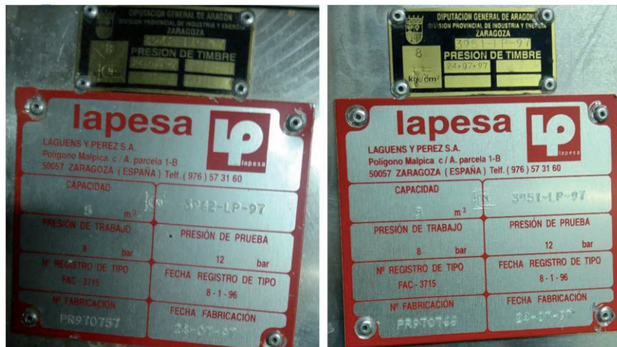
Figura 4. Placa de características depósito de 5 y 3 metros cúbicos
