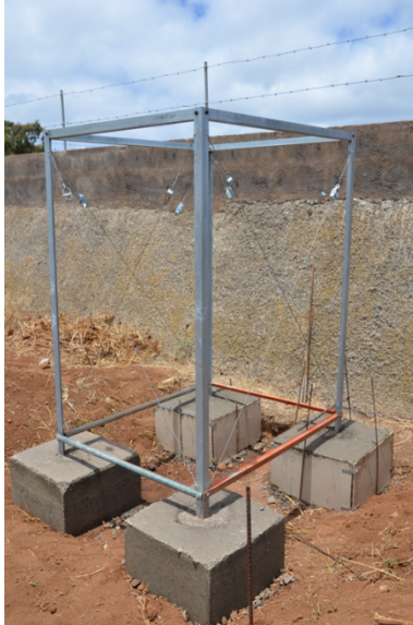
Foto 5. Estructura de elevación del depósito.
