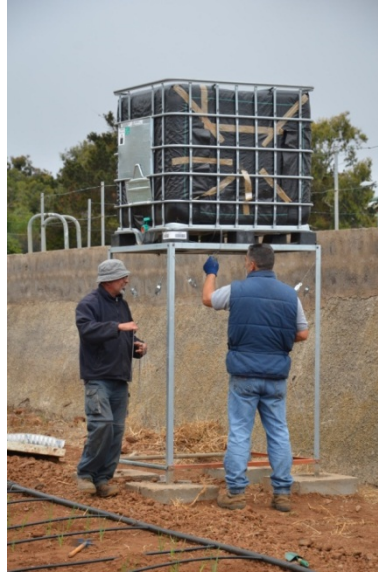
Foto 6. Depósito cubierto con malla negra.
