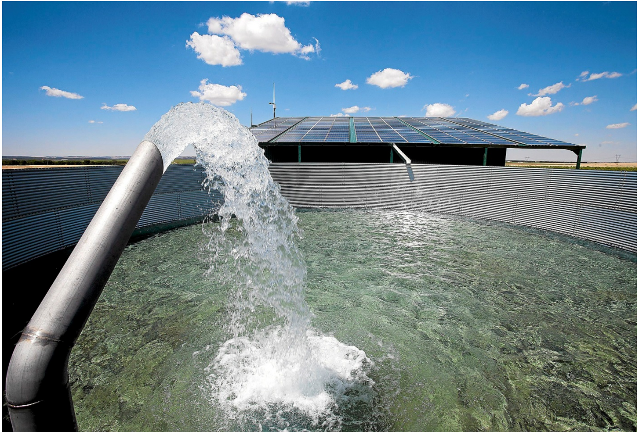
Figura 3: Depósito y nave con las placas solares en la cubierta.
