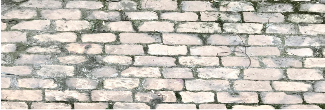
[Fig. 30] Imagen del pavimento exterior de los patios. Fuente: María Teresa Sánchez Fernández.
