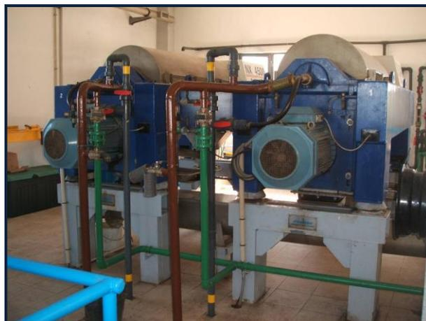
**Figura 19.** Centrífugas deshidratación fangos EDAR Cullera.
