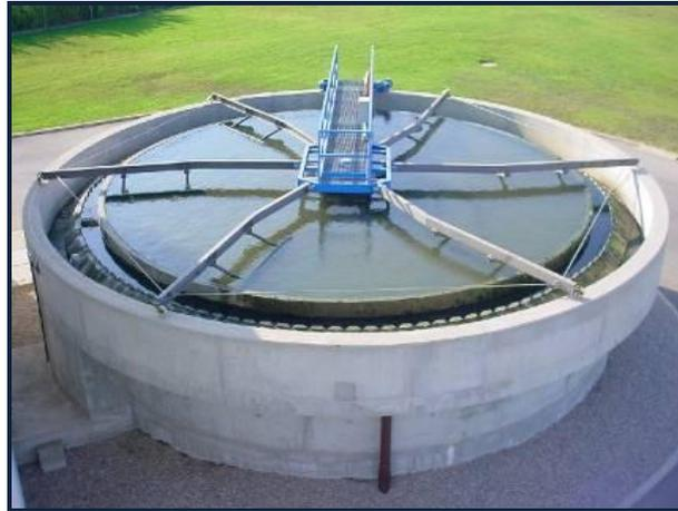
**Figura 18.** Flotador fangos en exceso EDAR Cullera.
