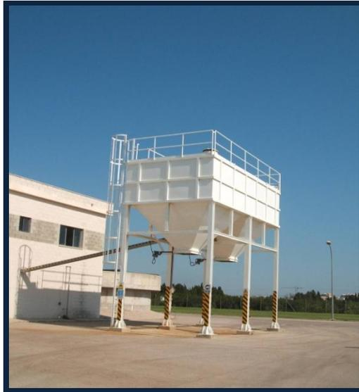
**Figura 20.** Silos almacenamiento fangos deshidratados EDAR Cullera.
