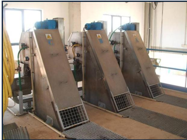
**Figura 11.** Desbaste-Tamizado EDAR Cullera.
