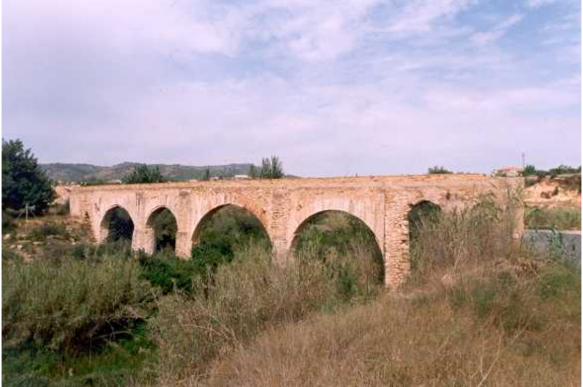
Fotografía acueducto antes de la restauración (obtenida a partir de la Dirección General de Patrimonio Valenciano)
