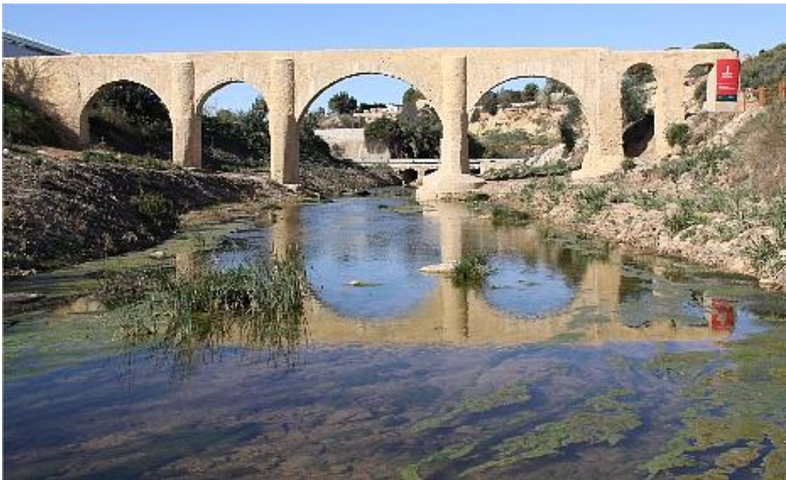
Fotografía acueducto después de la restauración (obtenida a partir de "Levante El Mercantil Valenciano")
