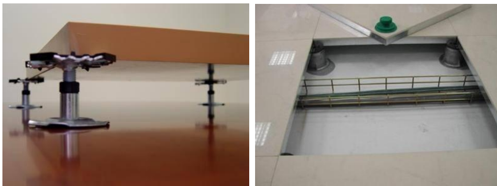
Figura IV.43: Suelo técnico. (Bell,2010).
