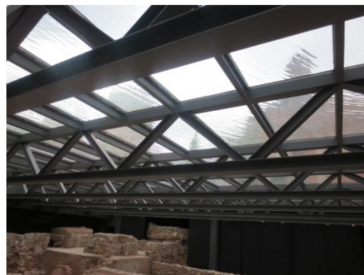
Figura VII.6: Estructura de L'Almoina. Fuente propia.
