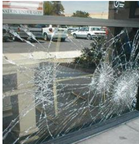
Figura IV.24: Rotura vidrio laminado 13 .
