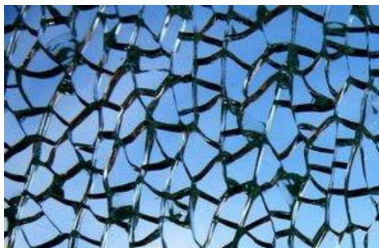
Figura IV.29: Vidrio templado roto 18 .
