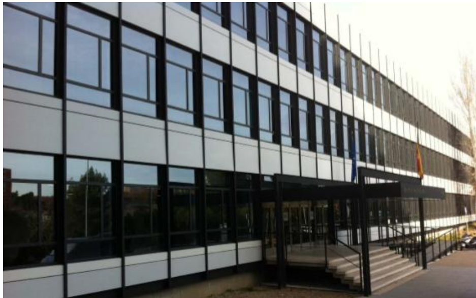
Figura IV.39: Muros cortina montados sobre retícula de elementos simples. (Fran Bretones,2014:3).
