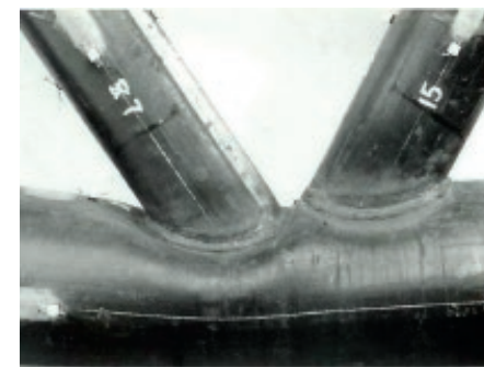
Fig 7.9 Plastificación del cordón
