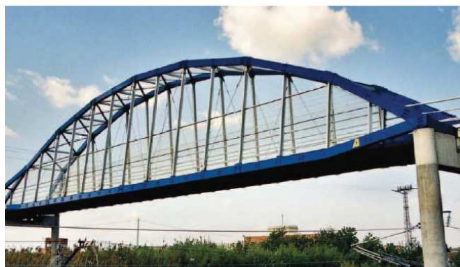
Imagen 3.1. Puente sobre el tren. Lleida.
