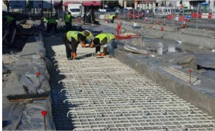
Imagen 1.4 Imagen de la construcción del tranvía de Granada. Tramo enterrado.
