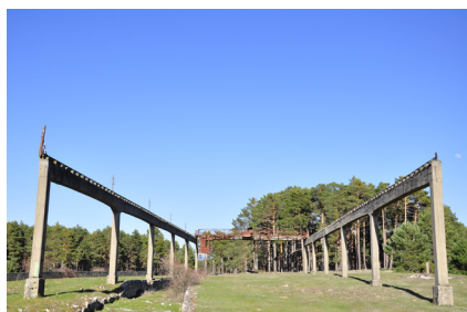
Fig. 43: Embarcader y puente grúa de la estación abandonada Pinar Grande.
