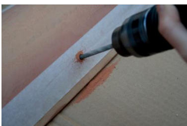
42. Proceso de perforación de las tejas
