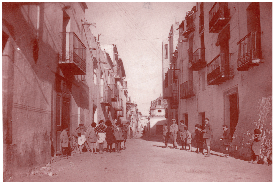
Fig.1. Arxiu fotogràfic de la Biblioteca pública municipal de Càlig, Castelló. Imatge del Carrer Raval. Dècada 1930.
