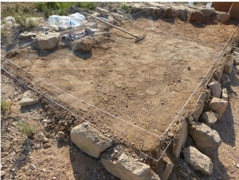
Fig. 3. Encofrado de la sección A de la plataforma y nivelación mediante mezcla de arena y cal hidráulica compactada.
