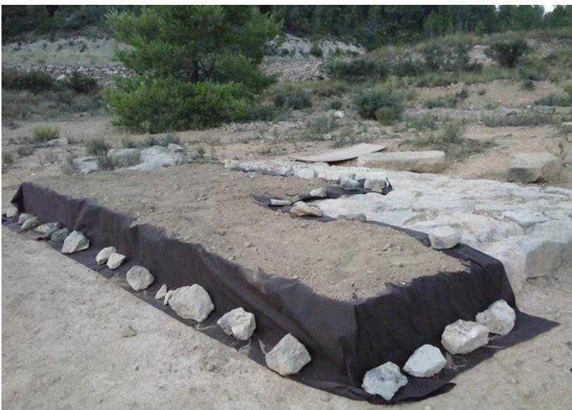
Fig. 10. Durante la fase de protección final de la plataforma mediante geotextil y una capa de tierra.
