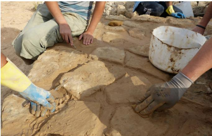
Fig. 8. Rejuntado de los mampuestos en superficie.
