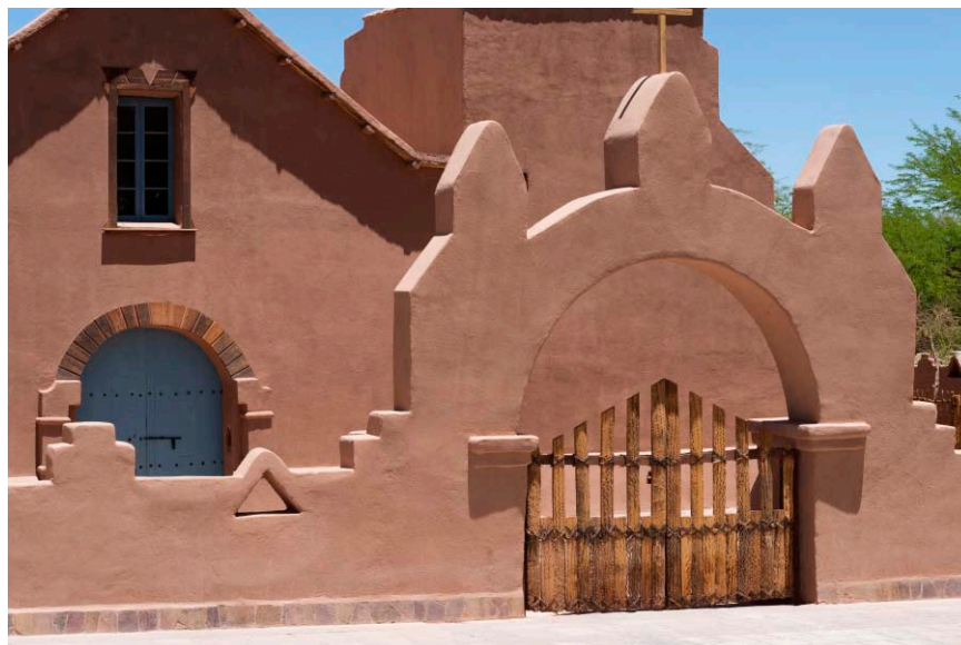
1. Fachada principal de la iglesia de San Pedro de Atacama, restaurada. Fuente: Archivo de la Fundación Altiplano. 1. San Pedro de Atacama church main facade, once restored. Source: Fundación Altiplano archive.
