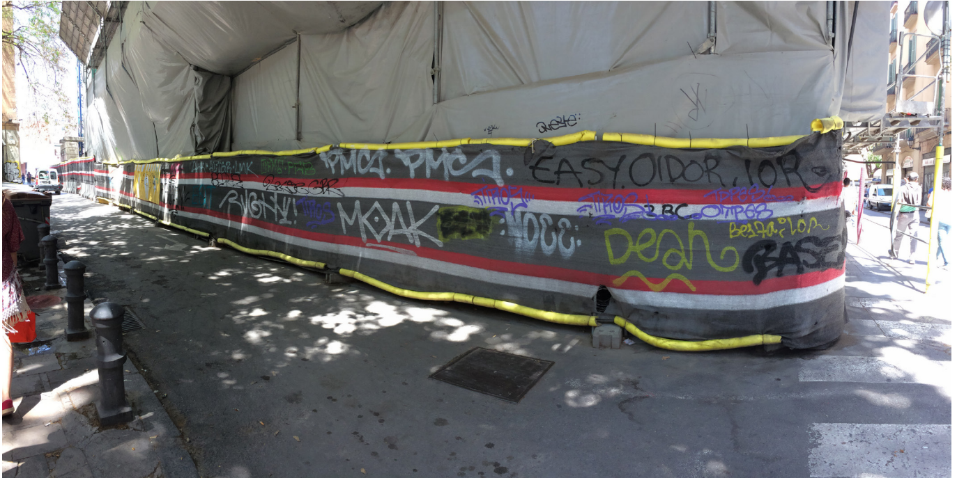
Obras en una calle de Barcelona (fotografía personal)
