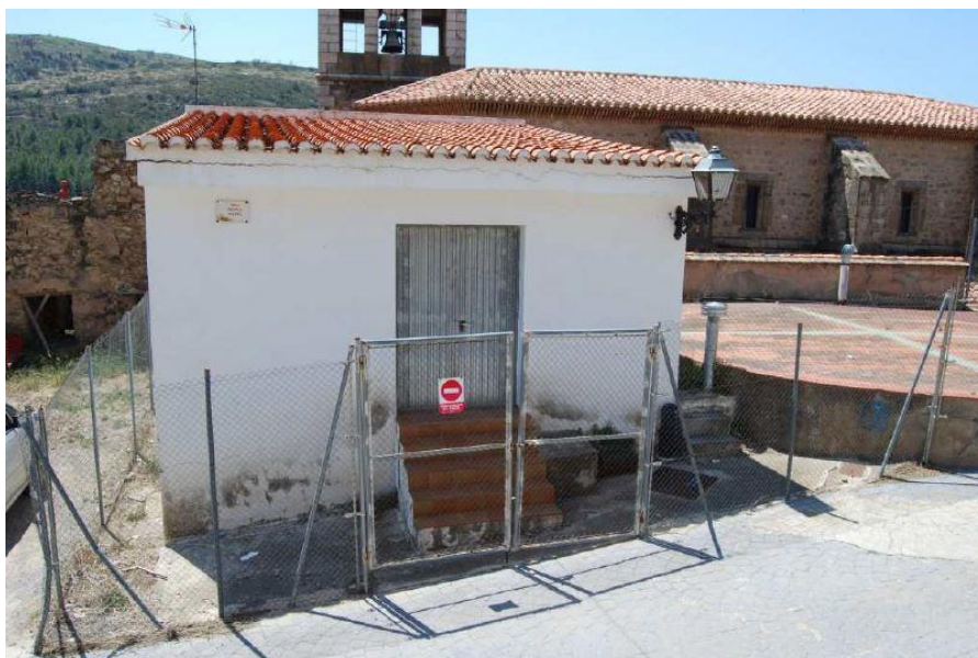
Foto 8.- Depósito Inferior Nuevo
