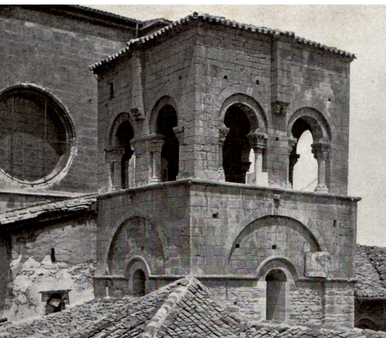
3. Torre Vieja de la Catedral de Oviedo, tras la restauración de Alejandro Ferrant. Fueron reabiertos los vanos y se rebajaron los tejados que ocultaban la estructura, de modo que ésta recuperó su protagonismo en el conjunto.
