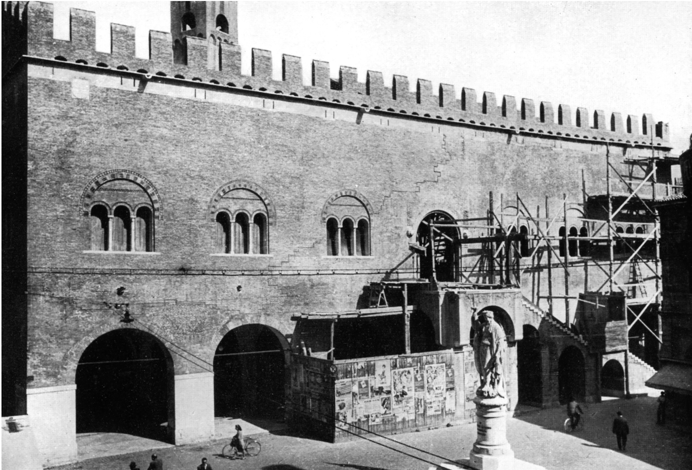
24. El Palazzo dei Trecento, Treviso. Vista exterior actual donde se observa el surco que indica el límite de la zona de derrumbe
