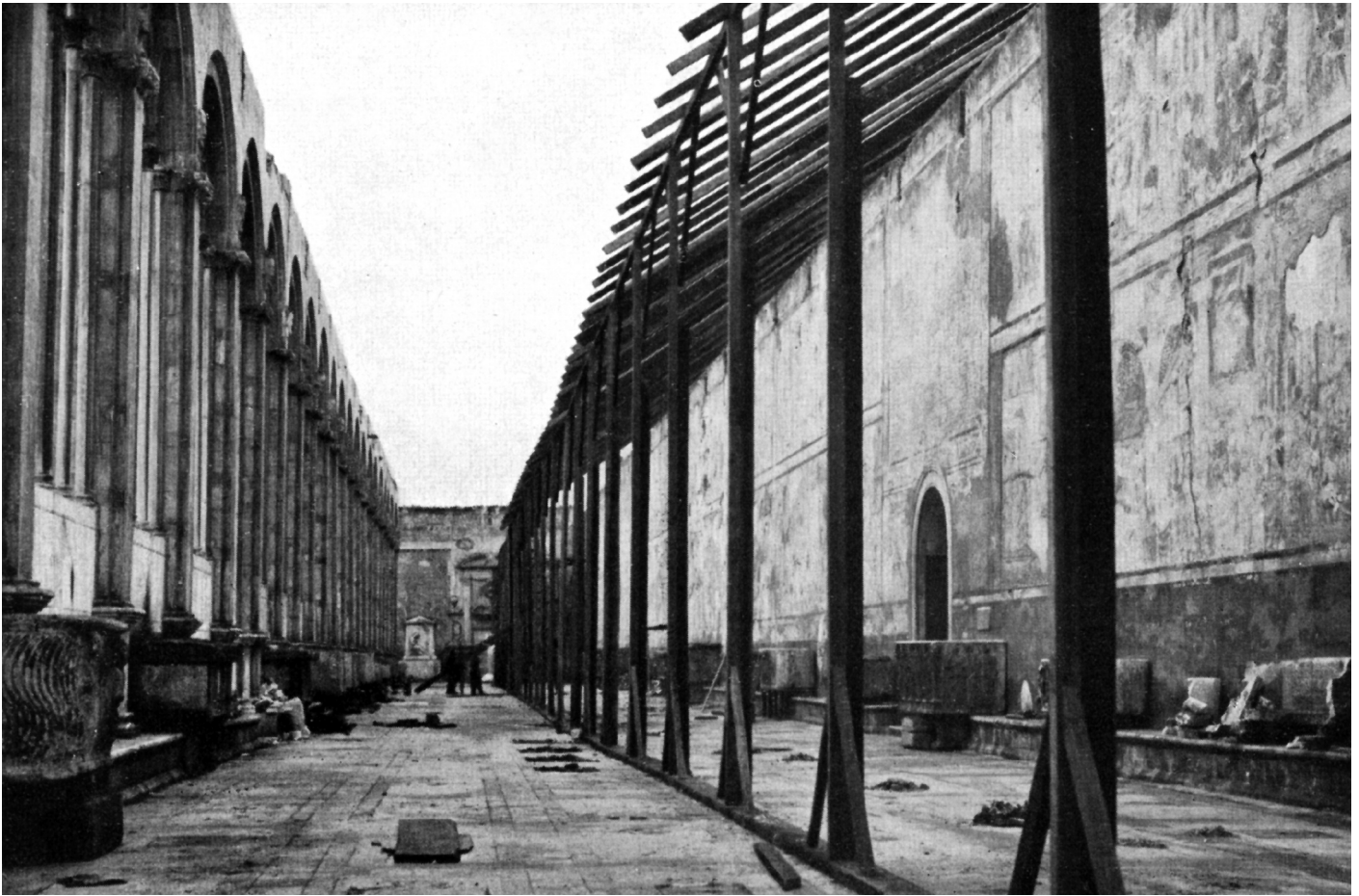
18. El Camposanto monumental de Pisa. Vista de la cubierta provisional de posguerra
