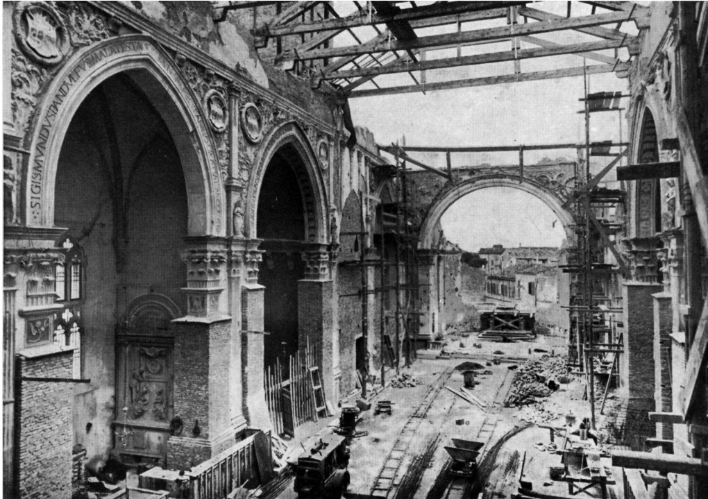
1. Templo Malatestiano de Rimini. Los bombardeos causaron la caída de de la zona del presbiterio, el ábside y las cubiertas, además de varias lesiones en la fábrica de Alberti, en las esculturas, en la decoración y en los frescos
