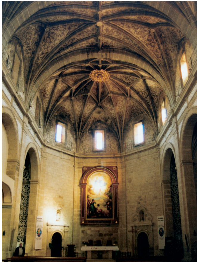
Interior de la iglesia antes de la restauración
