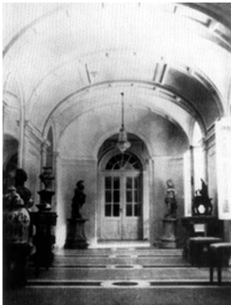
Figura 28 | Galería. Puerta que comunica con el den Foto antigua (probablemente de la época en la que los Wharton vivieron en The Mount ). El verde de las molduras sobre el fondo blanco parece que no forma parte de la idea original.
