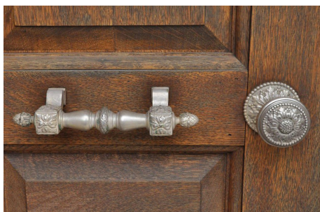
Figura 21 | Pomo y tirador de la puerta de entrada.
